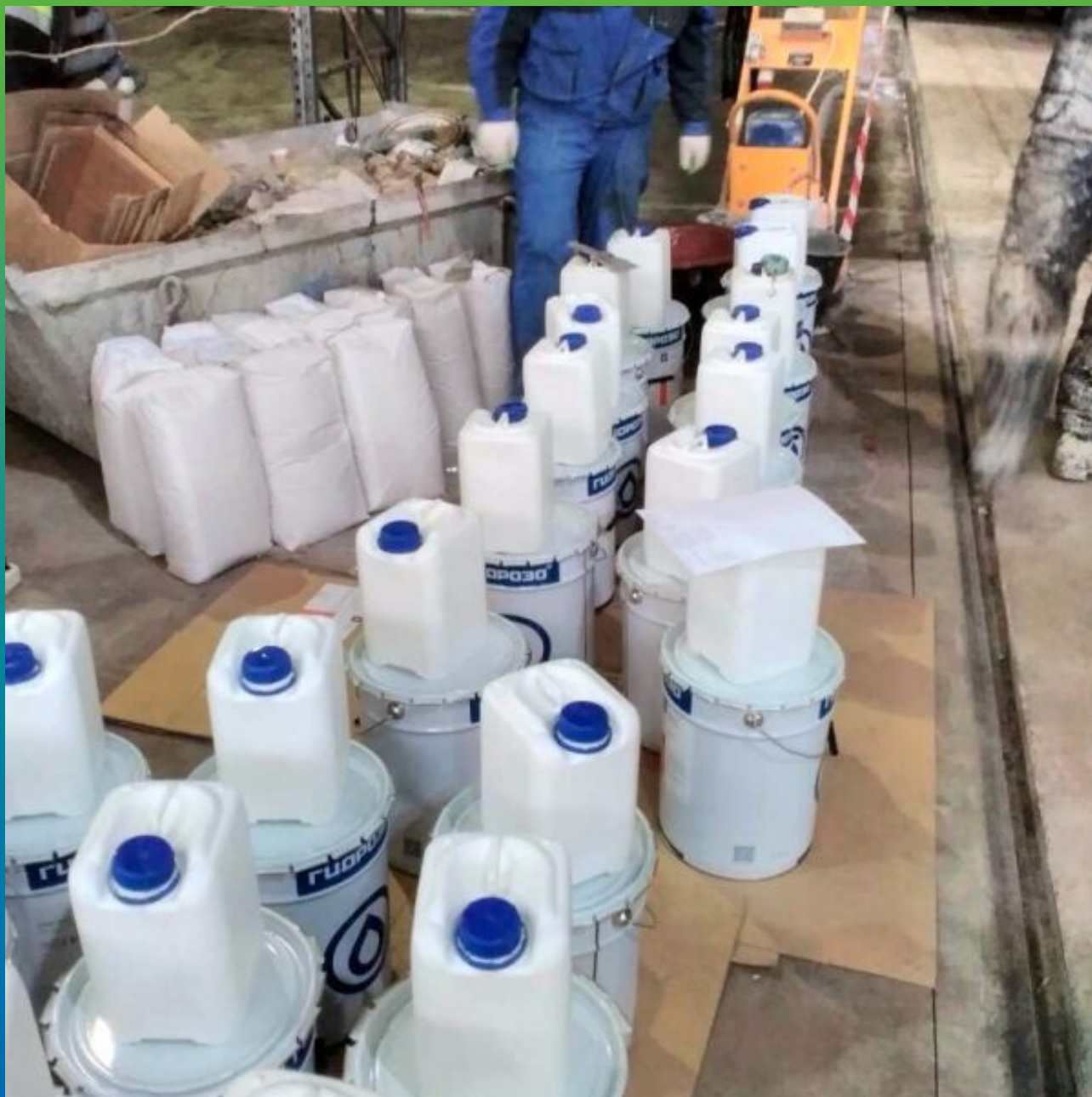
Материалы Гидрозо на объекте
