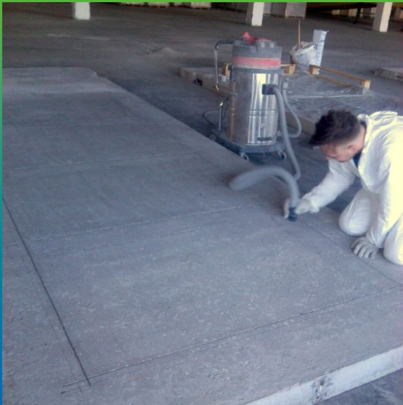
Обеспыливание и уборка мусора
