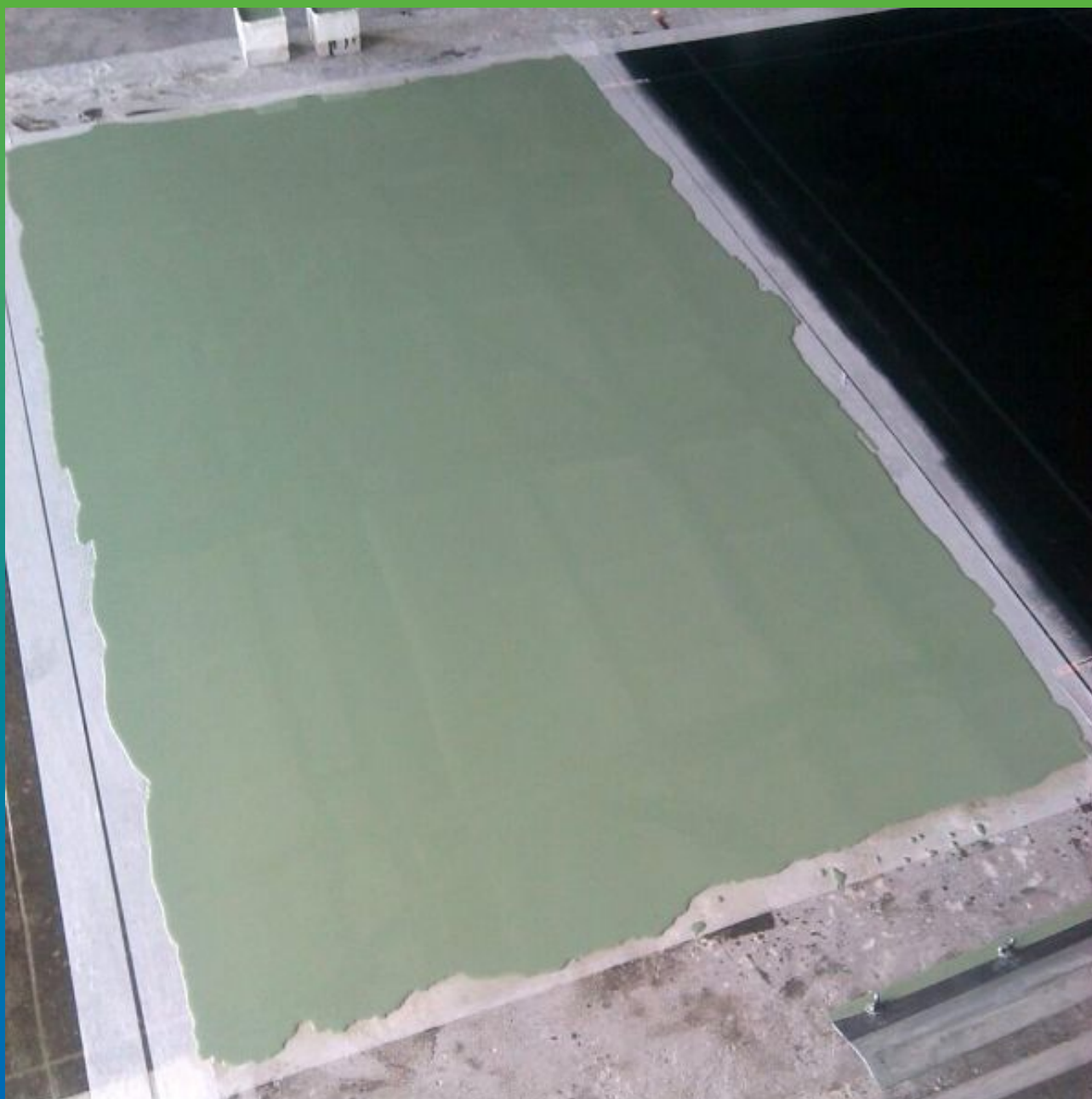
Распределение и укладка эпоксидной системы ДенсТоп ЭП 500
