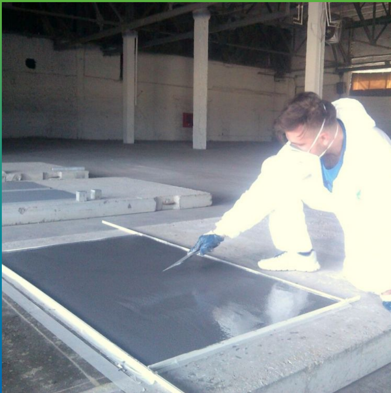
Распределение и укладка ЦПУ Денстоп ПМ 605 Тровел
