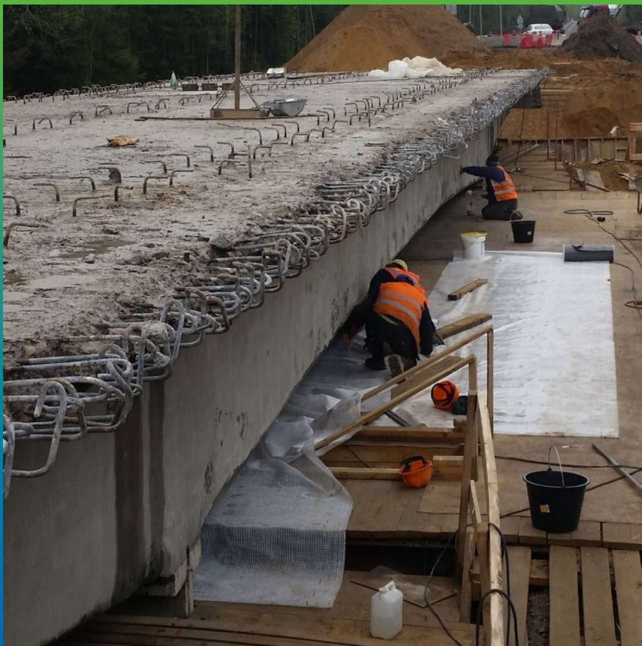
Монтаж системы усиления
