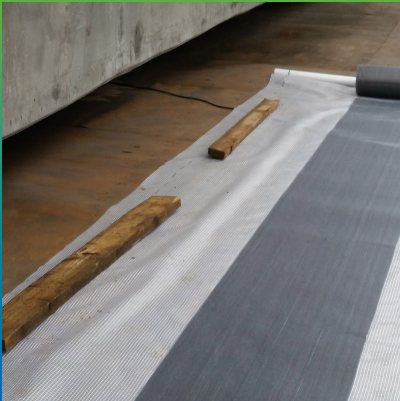
Подготовка углеволоконного полотна Армошел KB 500
