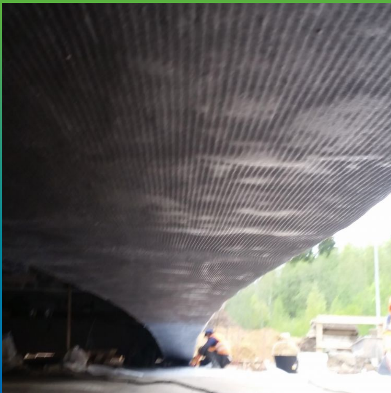
Вид на усиленный участок пролетного строения моста
