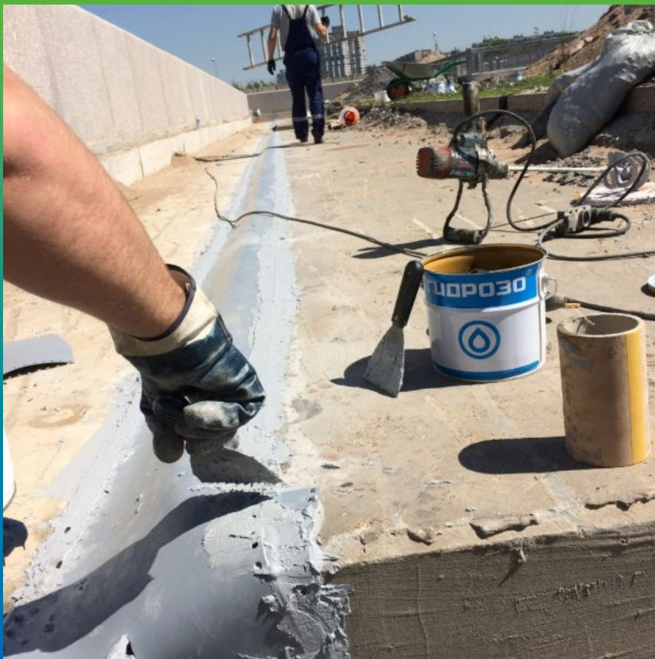
Монтаж ленты Манодил Про на двухкомпонентный эпоксидный состав Манопокс 331
