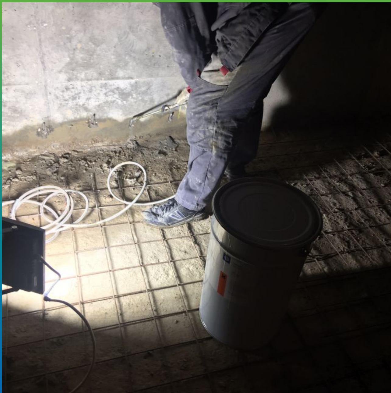
Инъектирование примыкания Манопур Гелем
