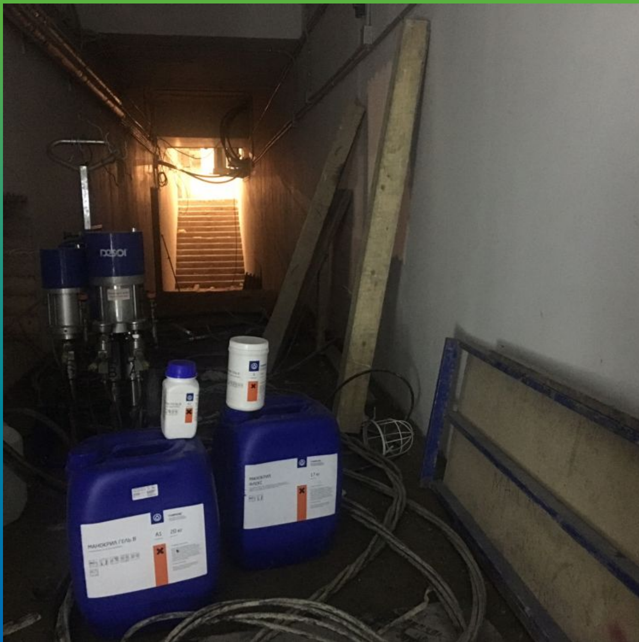
Материалы Гидрозо на объекте
