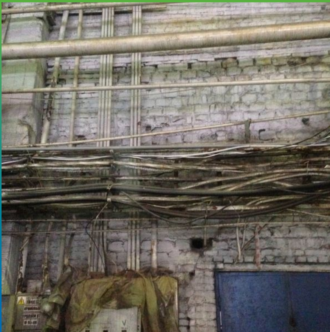
Старая кладка с выветренным кладочным раствором и полостями.
