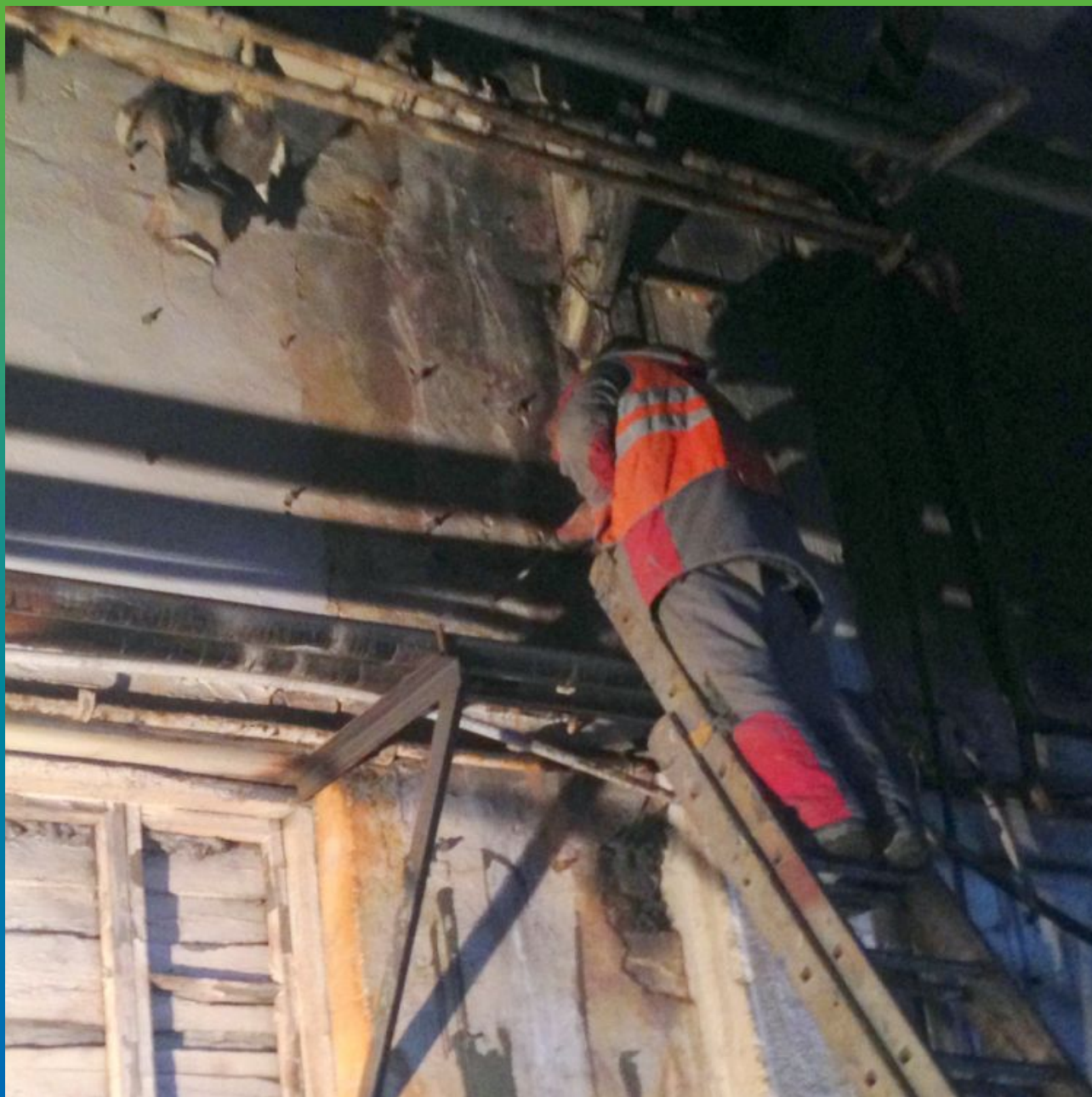
Бурение шпуров в швах кладки.
