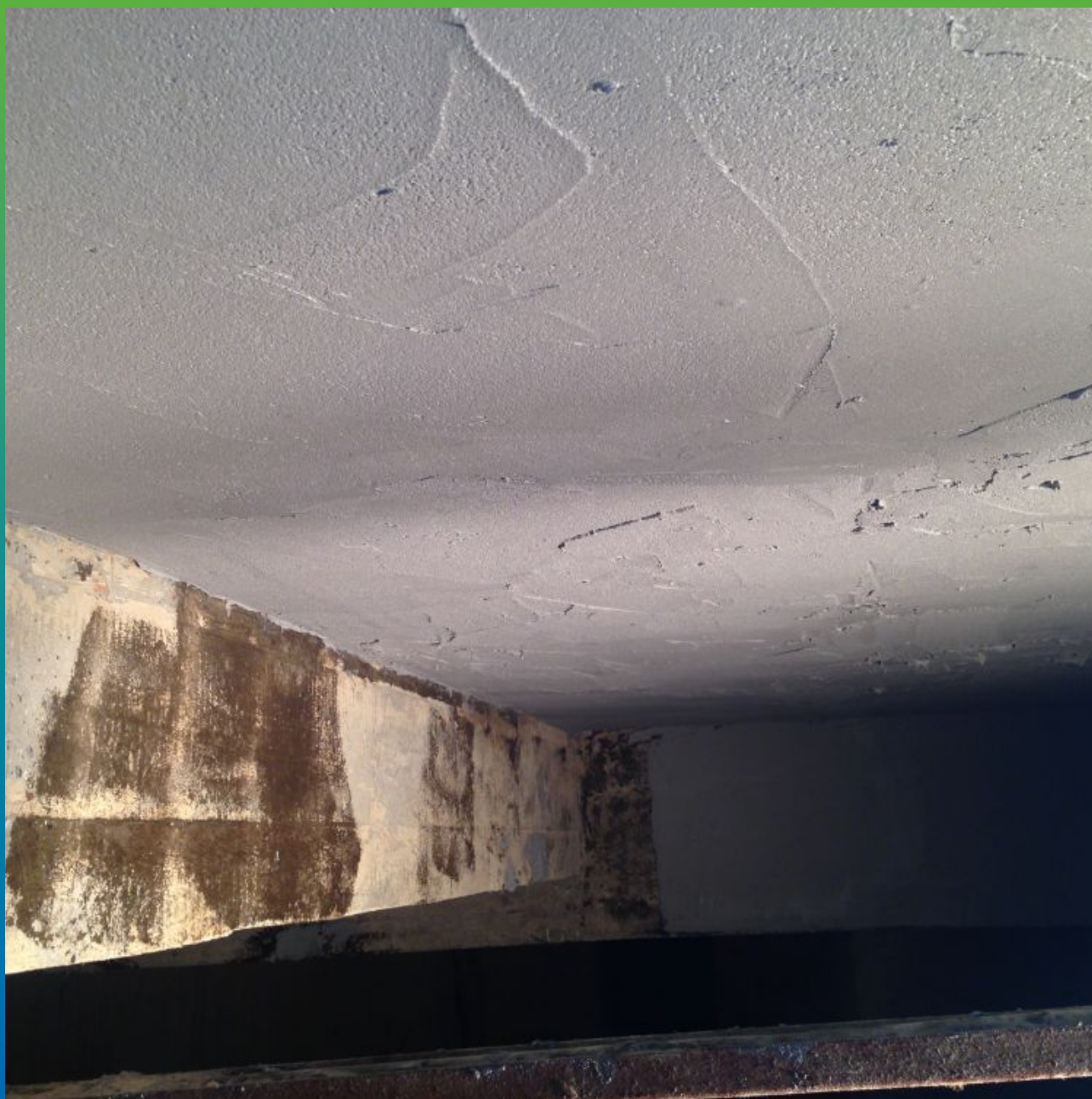
Общий вид подготовленного основания цеха для монтажа системы усиления ФАП.
