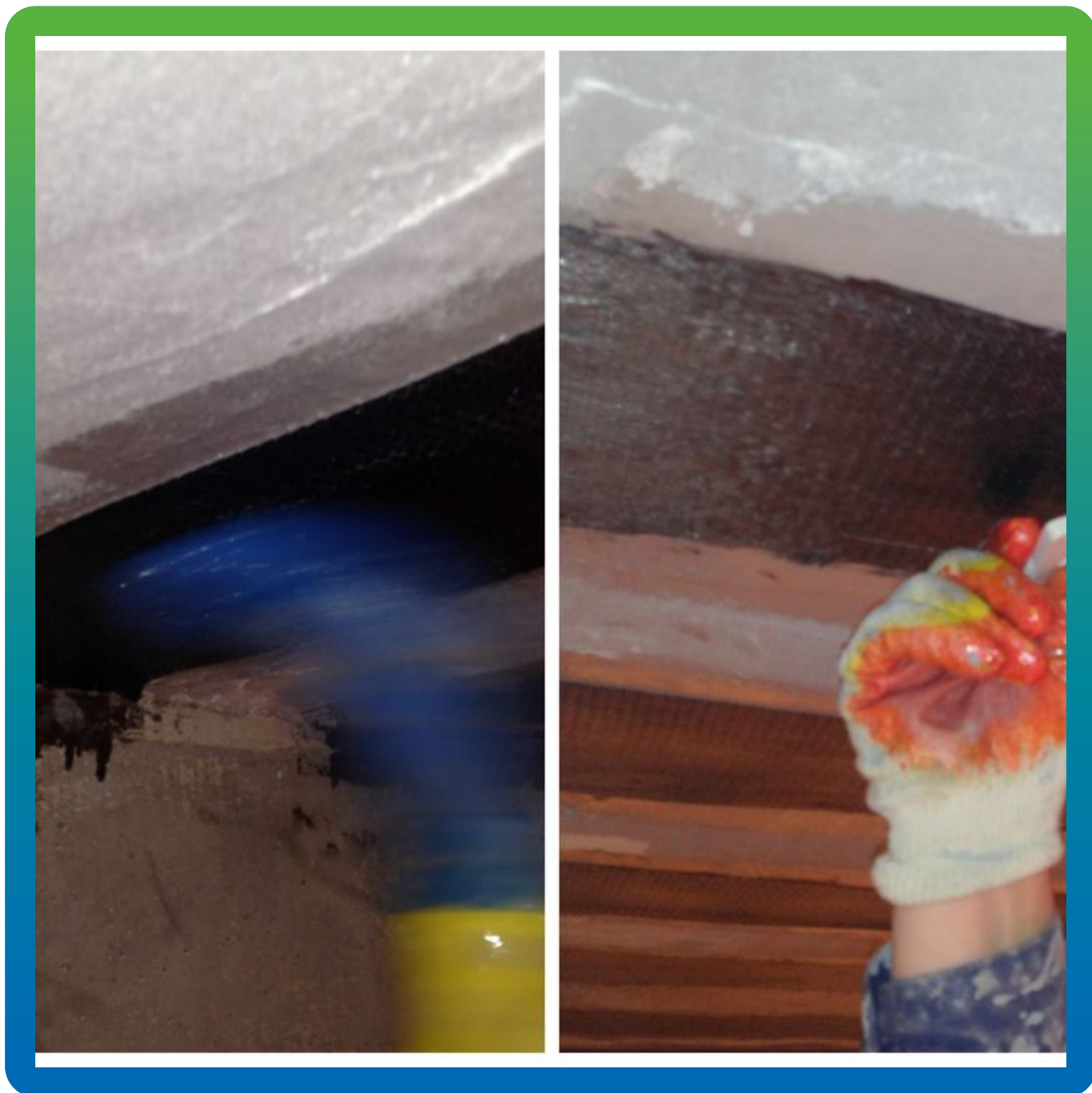
Разглаживание ткани вдоль расположения волокон и удаление воздуха.
