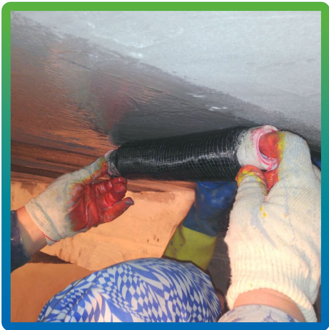
Процесс монтажа ткани Армошел KB 500.
