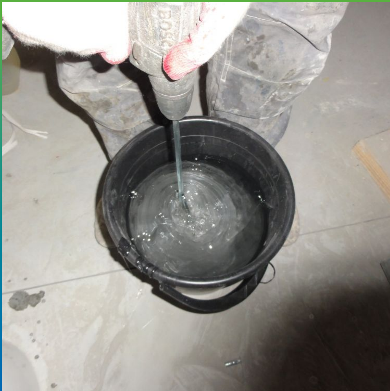
Замешивание клея Манопокс 372 компоненты А+Б.
