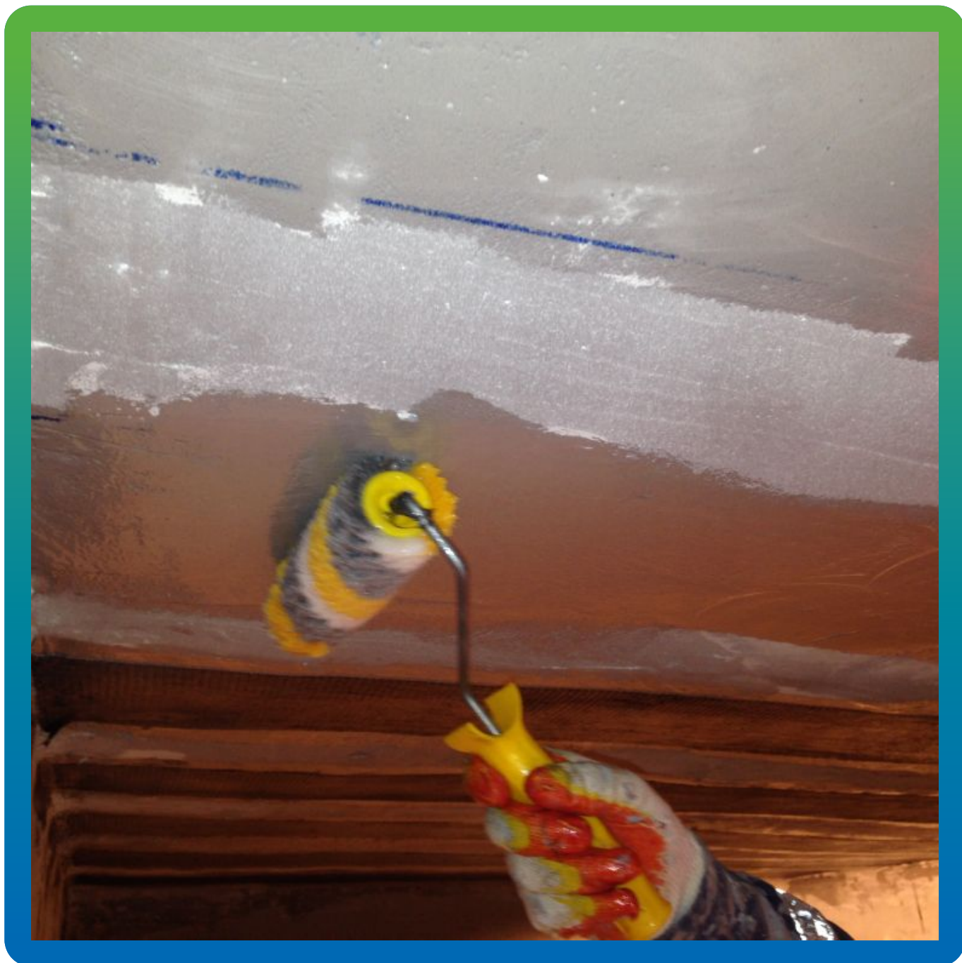
Нанесения загущенного клея на прогрунтованное основание.
