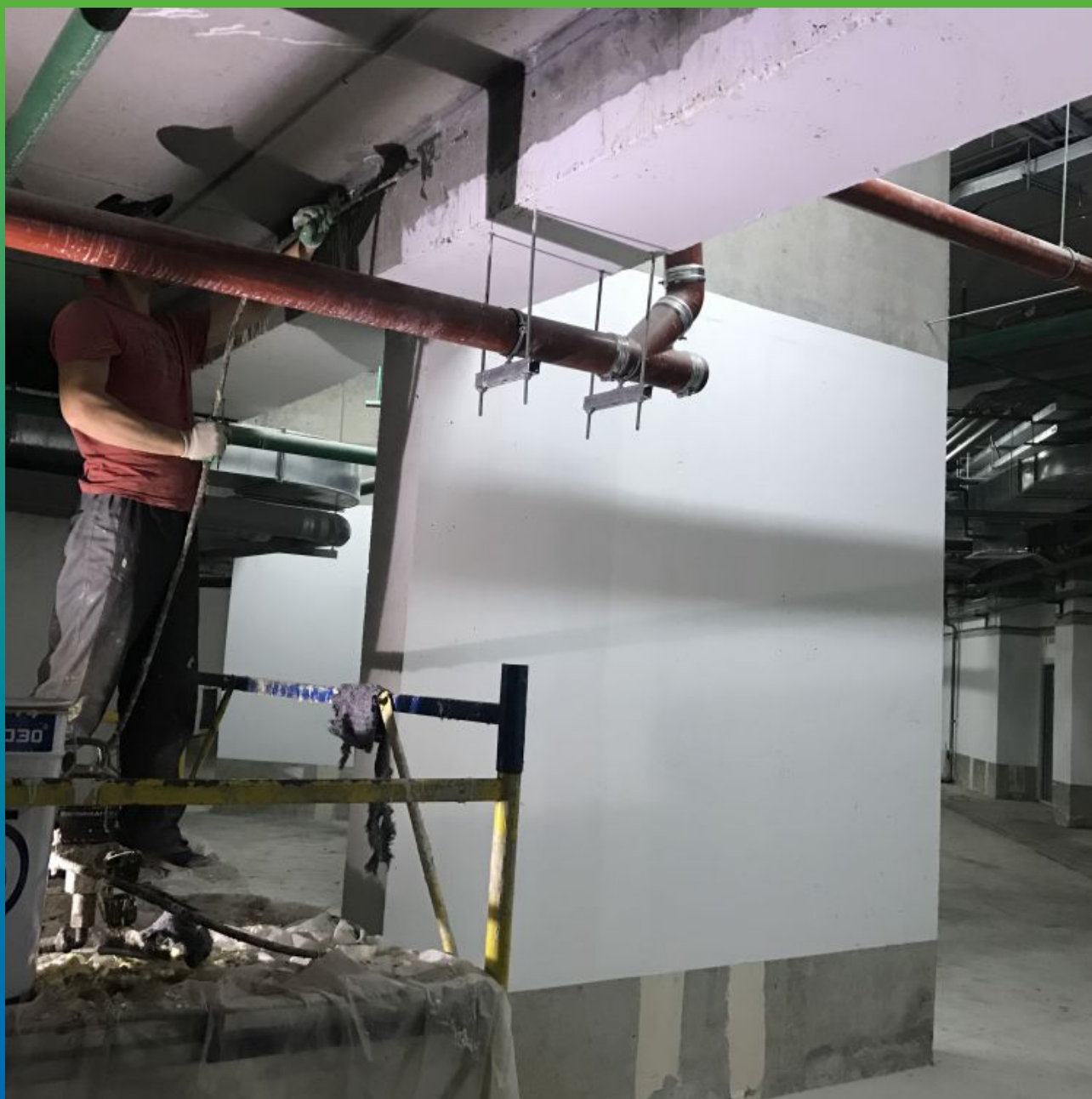
Процесс инъектирования холодного шва тугопластичной вспенивающейся смолой Манопур У Флекс.
