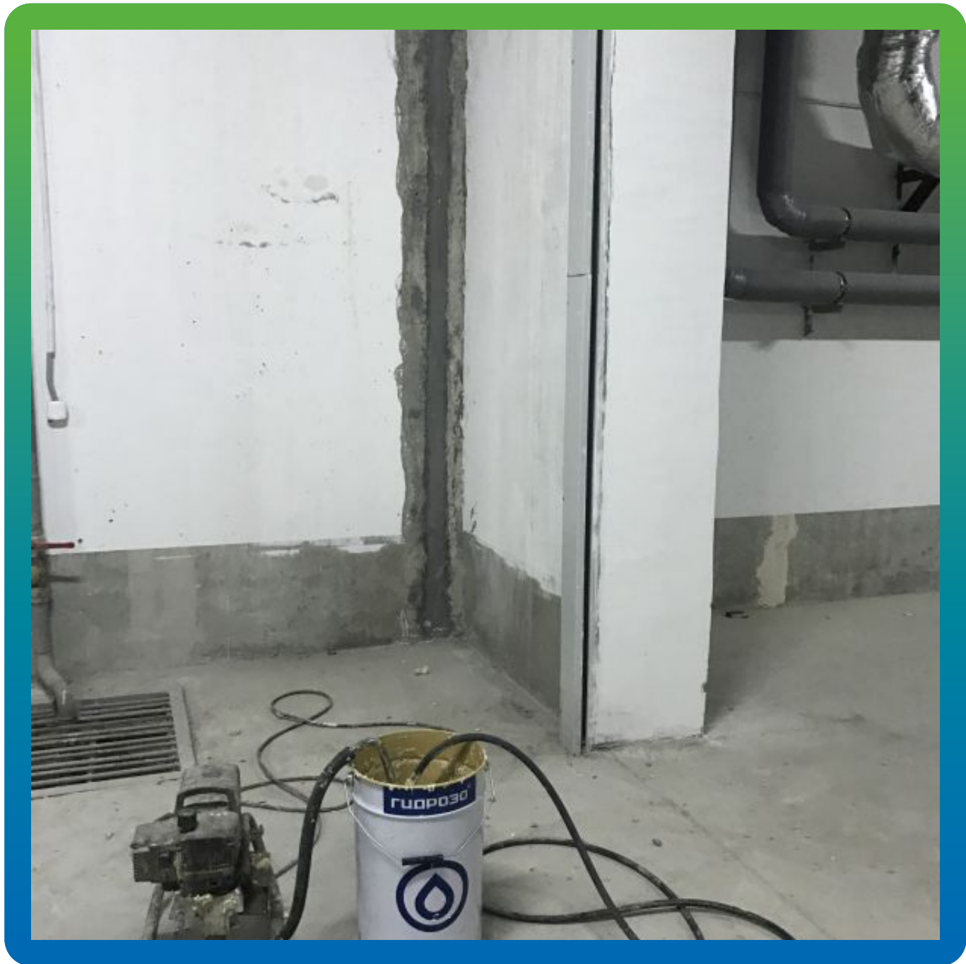
Инъектирование холодного шва между стенами тугопластичной пеной Манопур У Флекс.
