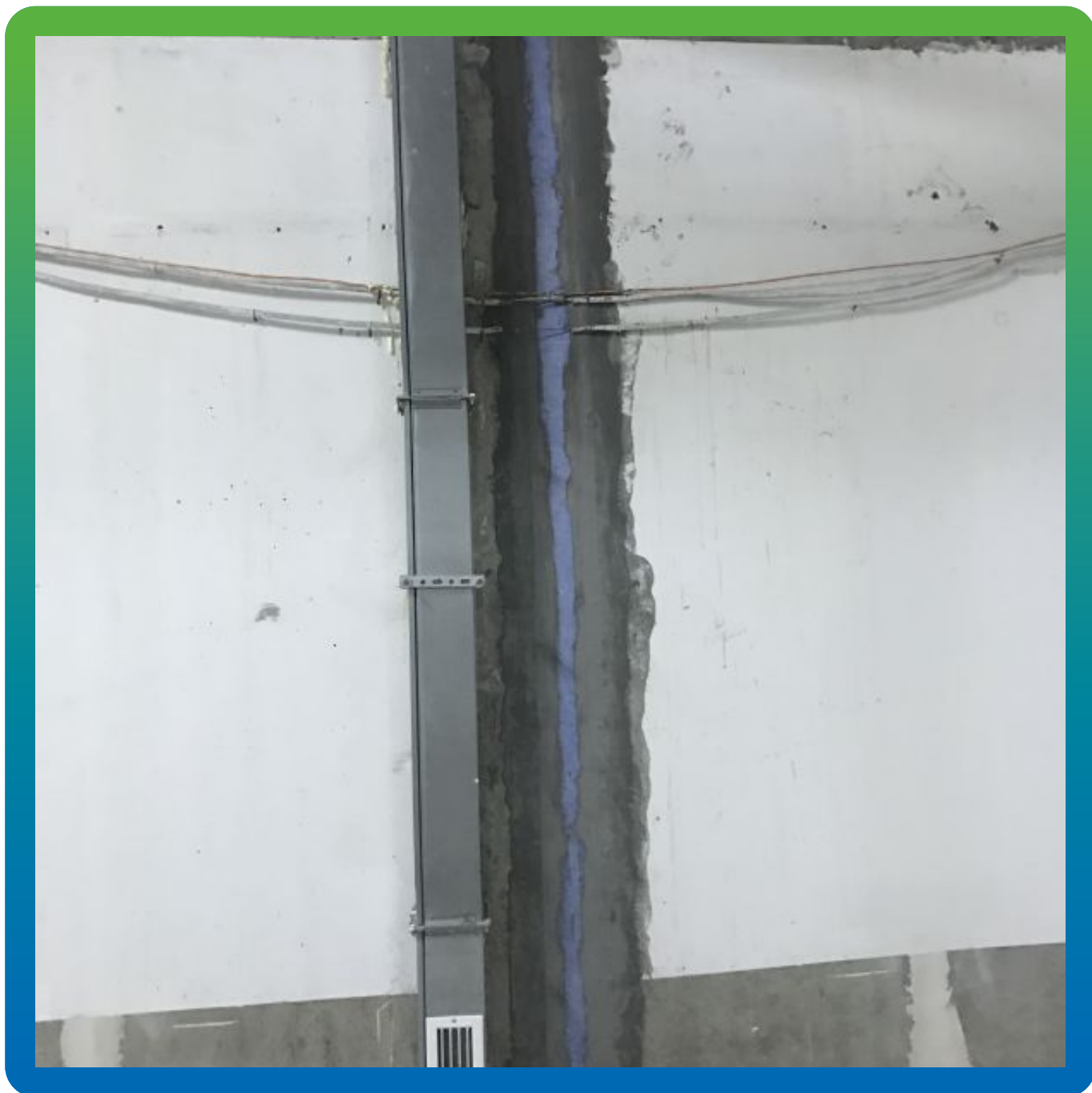
Гидроизоляция деформационного шва эластичной лентой Манодил Гео и Максил Флекс (после инъектирования).
