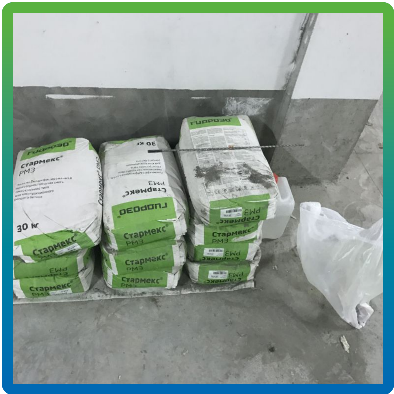
Безусадочный тиксотропный раствор Стармекс РМ3 на объекте.
