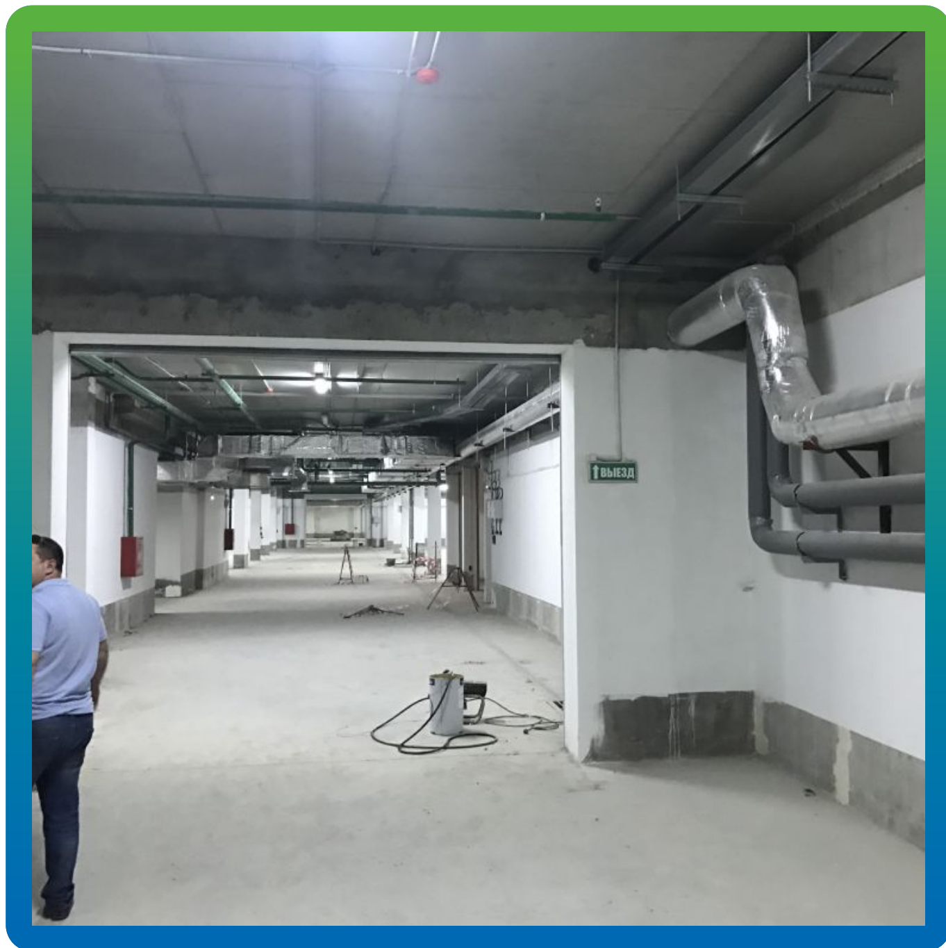
Общий вид первой очереди подземного паркинга.
