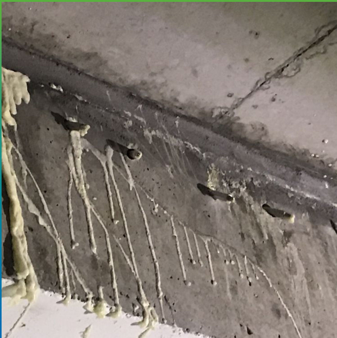
Увеличенный вид прокаченного холодного шва вспенивающейся смолой Манопур У Флекс.
