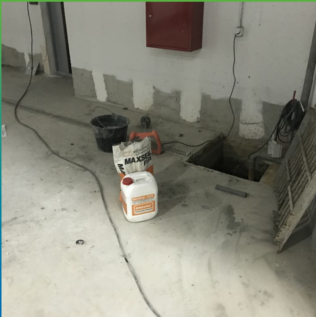
Эластичное гидроизоляционное покрытие Максил Флекс на объекте.
