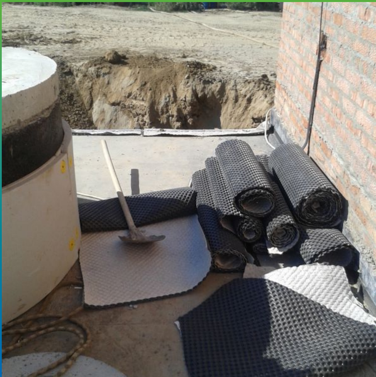
Максдрейн 8 ГТ на объекте
