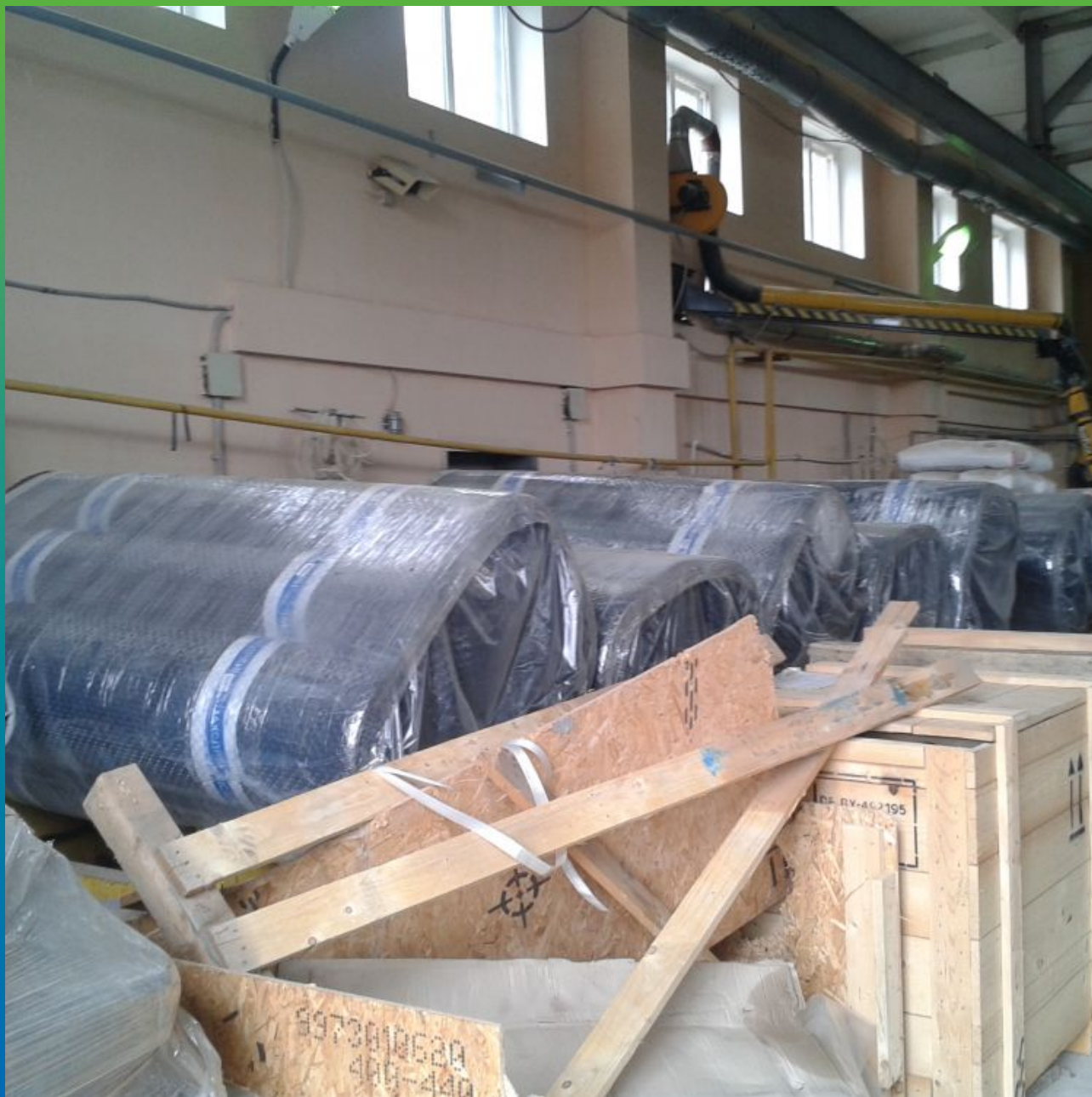
Дренажное полотно Максдрейн 8 ГТ на складе на объекте
