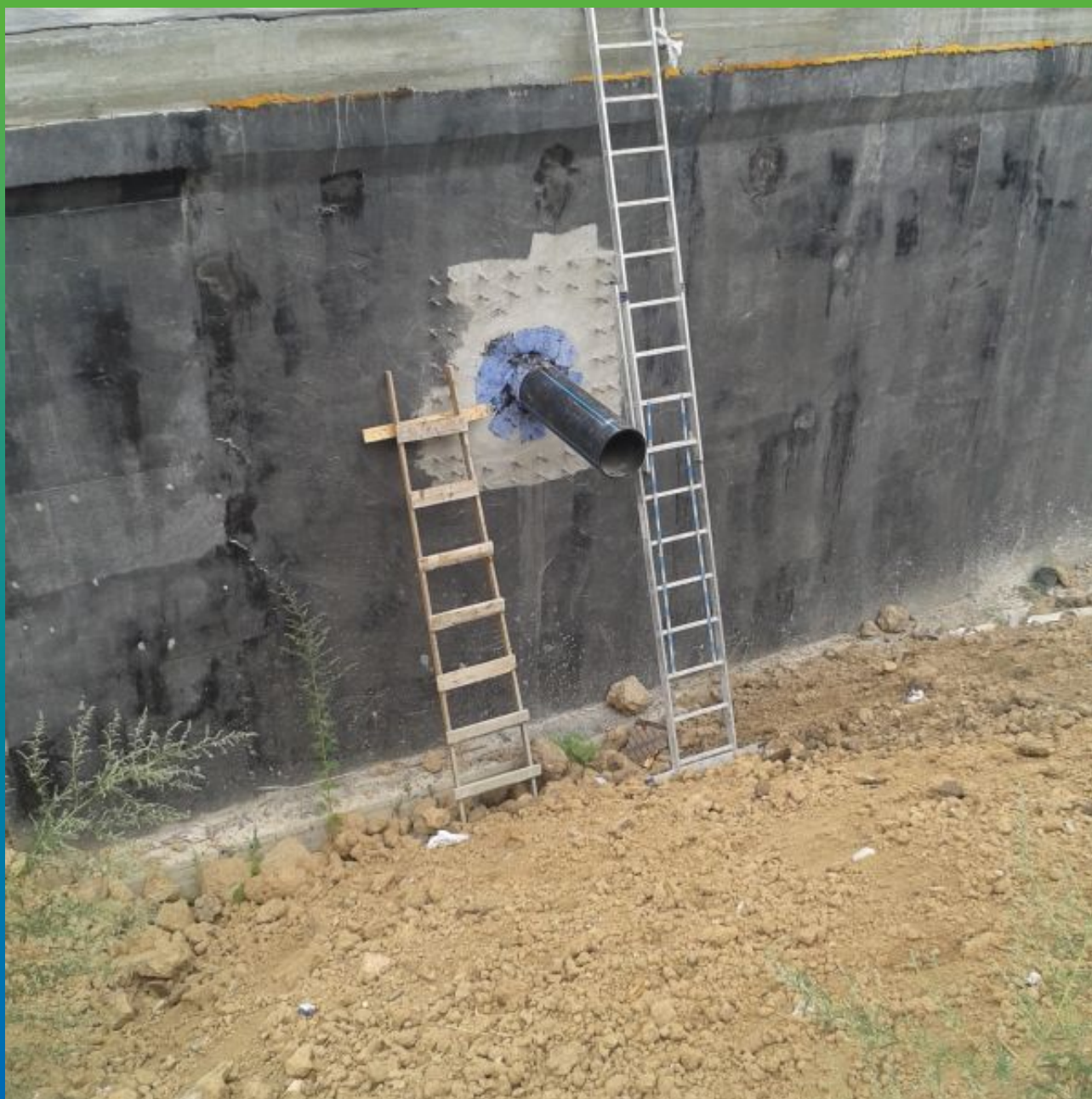
Завершенный вид ввода коммуникаций с наружной стороны резервуара
