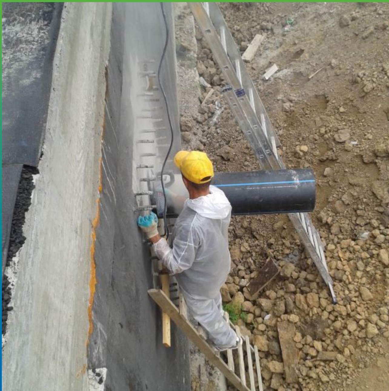
Шлифовка бетона перед нанесением герметика
