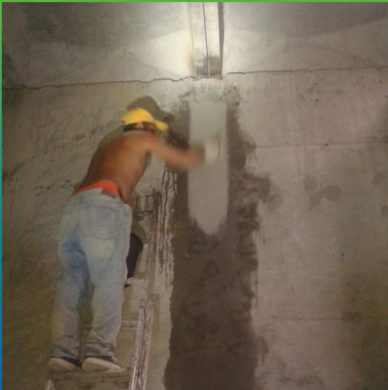
Нанесение Стармекс Сил Флекс на швы сборных железобетонных стен резервуара
