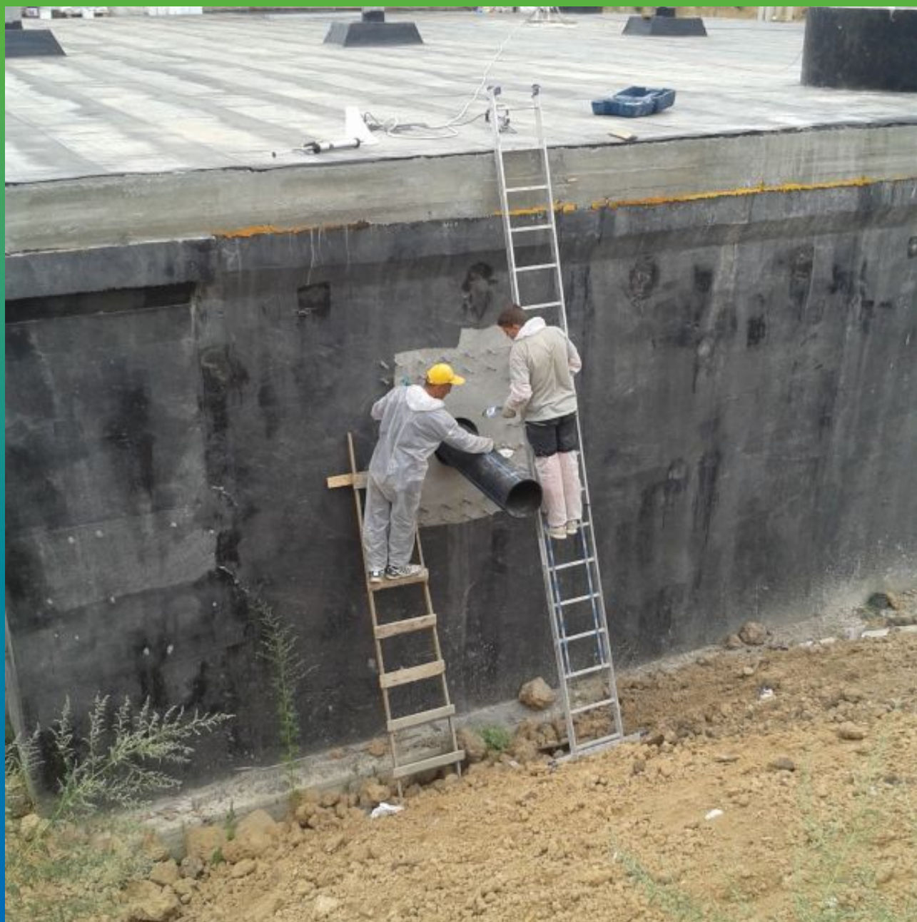
Обезжиривание поверхности пластиковой трубы перед монтажом ленты Манодил Гео
