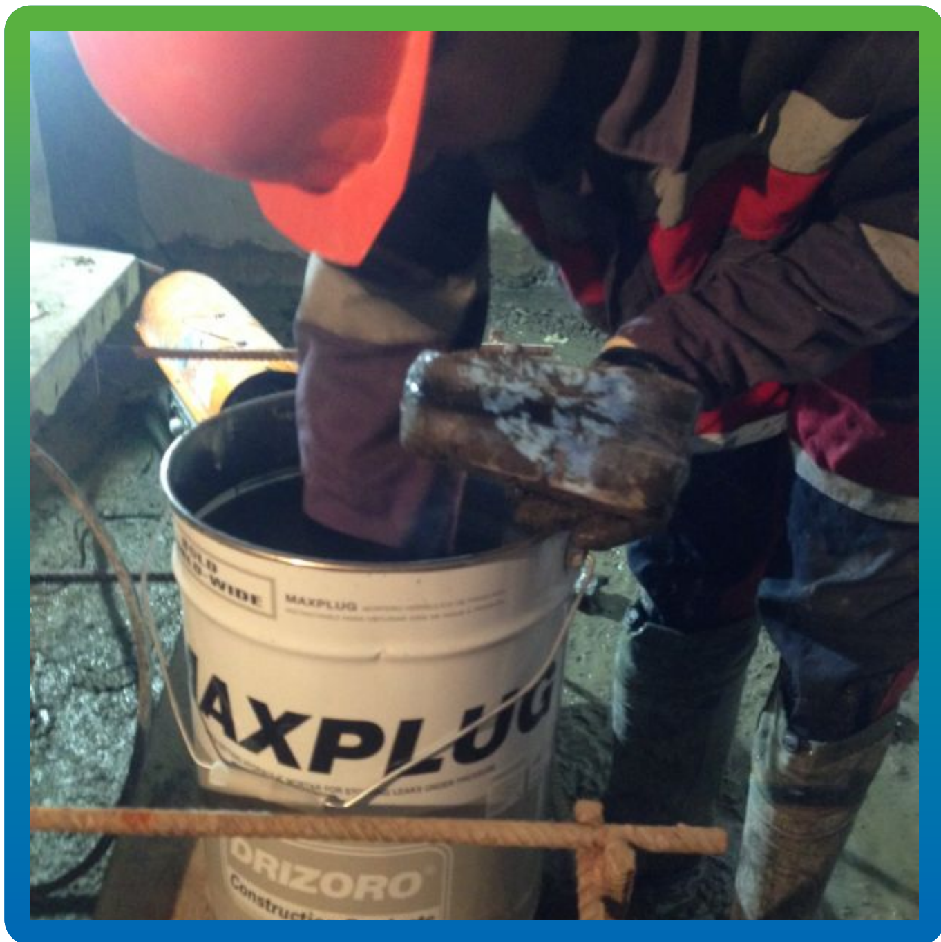
Замешивание гидропломбы Максplug.
