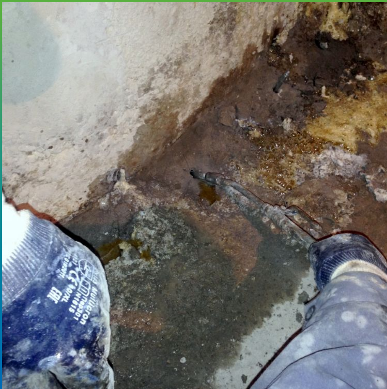
Процесс инъектирования смол.
