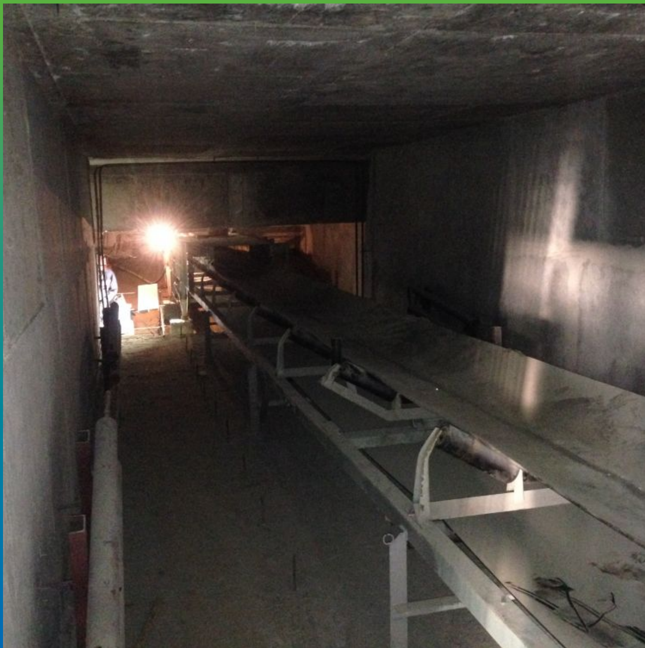
Детальный вид. Наклонная шахта конвейера.
