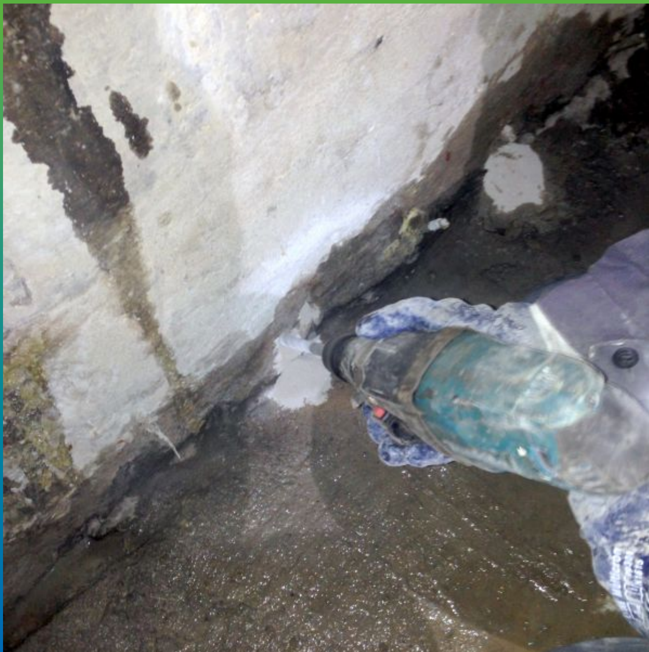
Бурение шпуров для установки пакеров.
