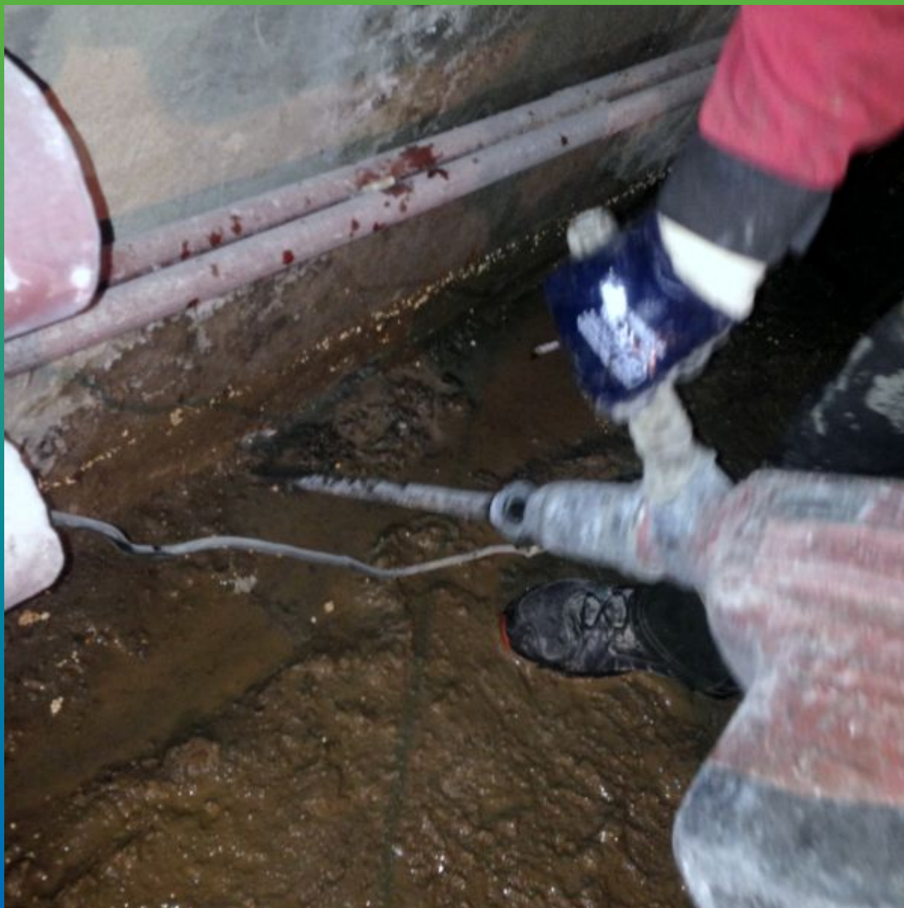
Подготовка фильтрующего шва. Штробление.
