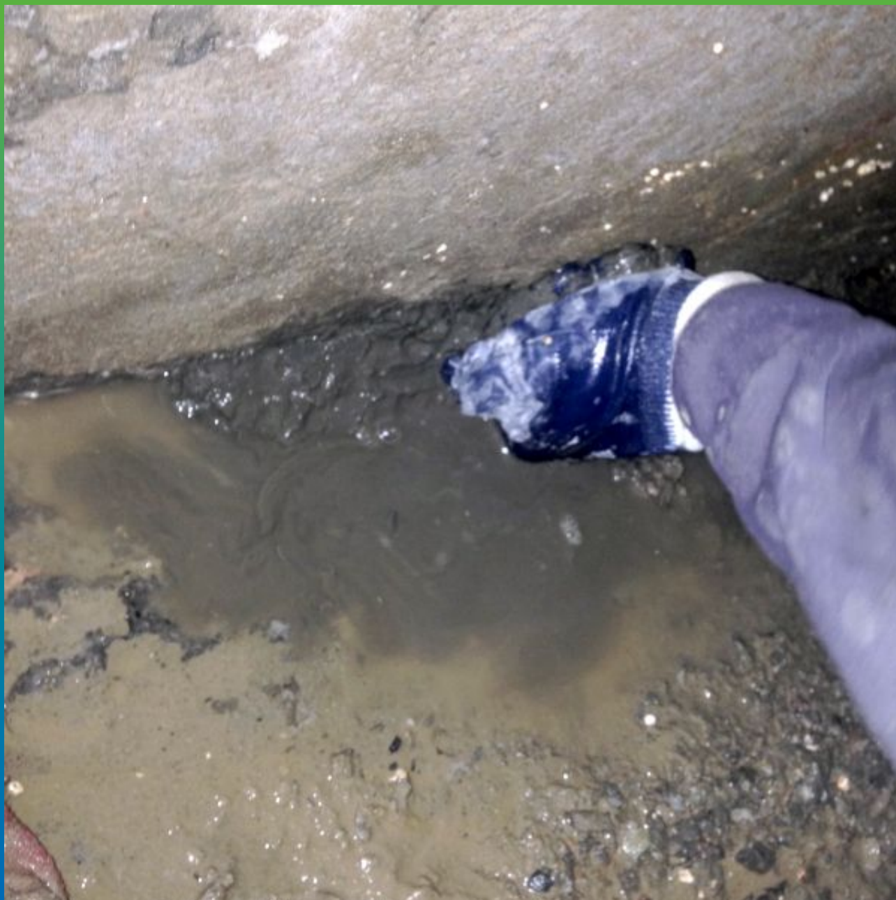
Заделка штробы, остановка течи.
