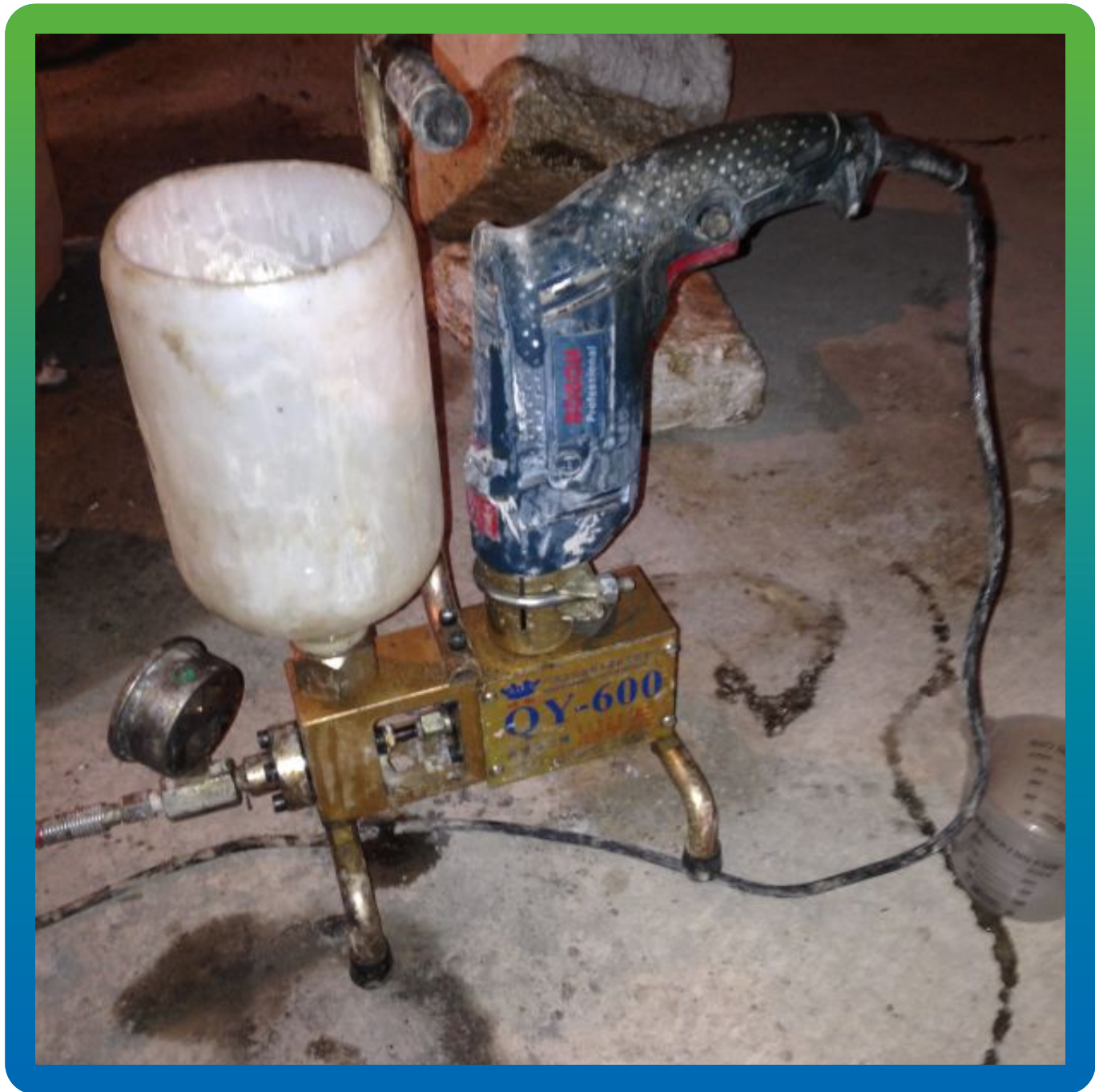
Подготовка инъекционного насоса.
