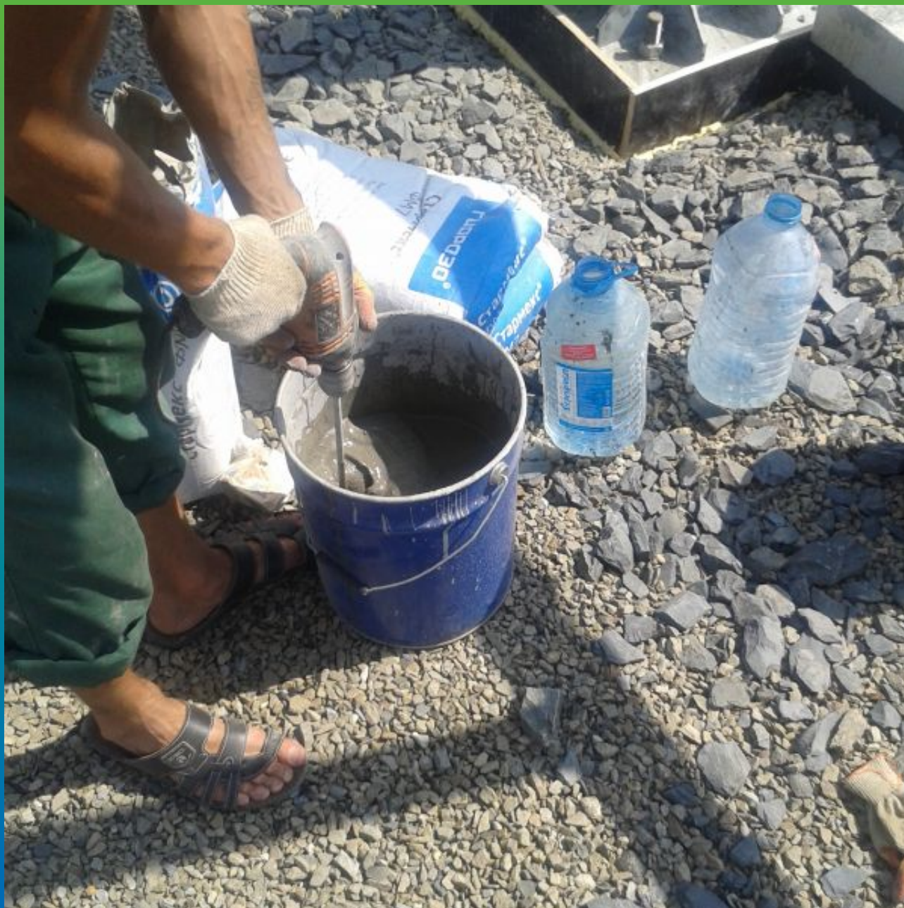
Приготовление смеси Стармекс ФМ7
