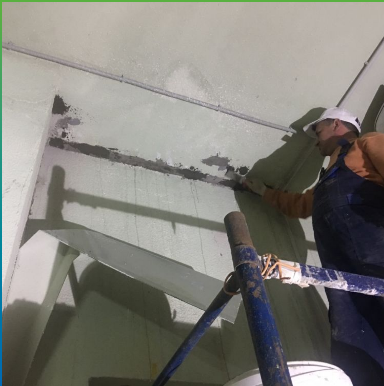
Заделка отверстий от пакеров
