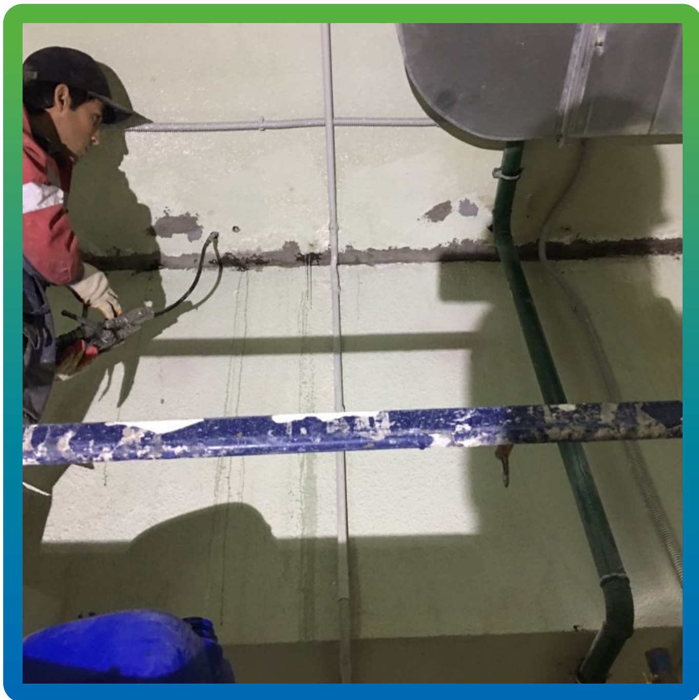
Инъектирование акрилатного геля Манокрил Гель В
