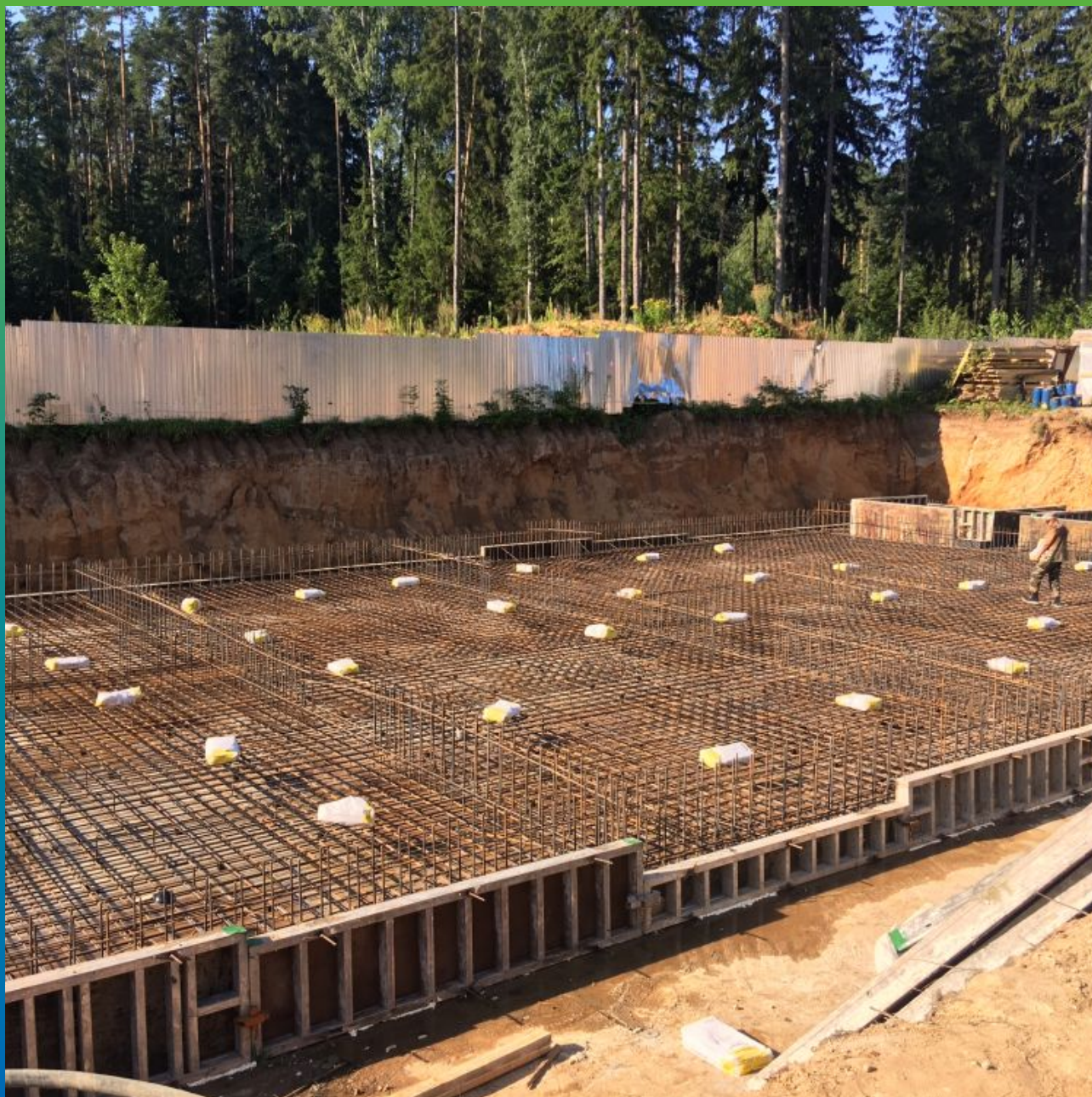
Распределение мешков Стармекс Сил по арматурному каркасу
