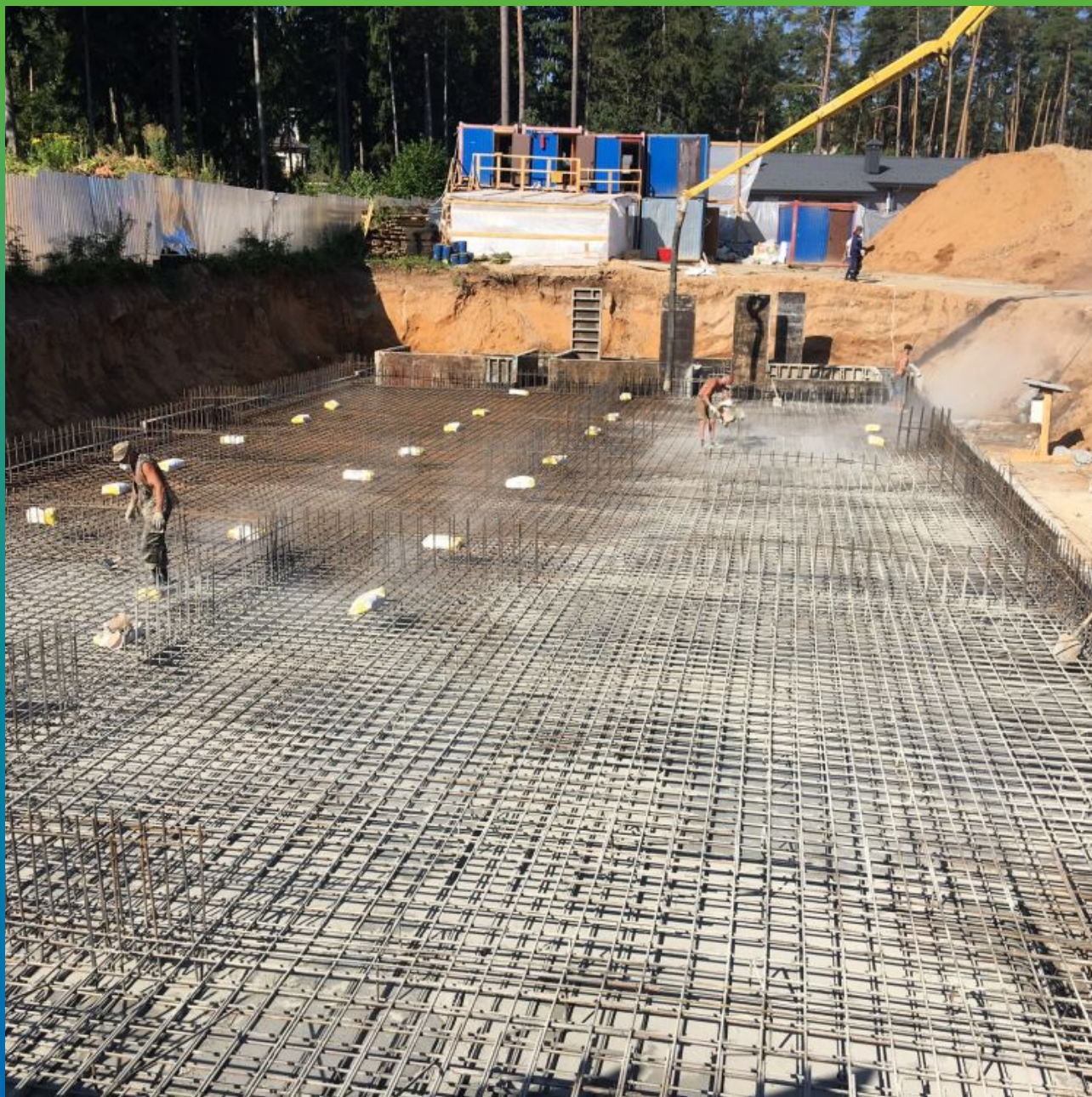
Просыпка материала Стармекс Сил по бетонной подготовке
