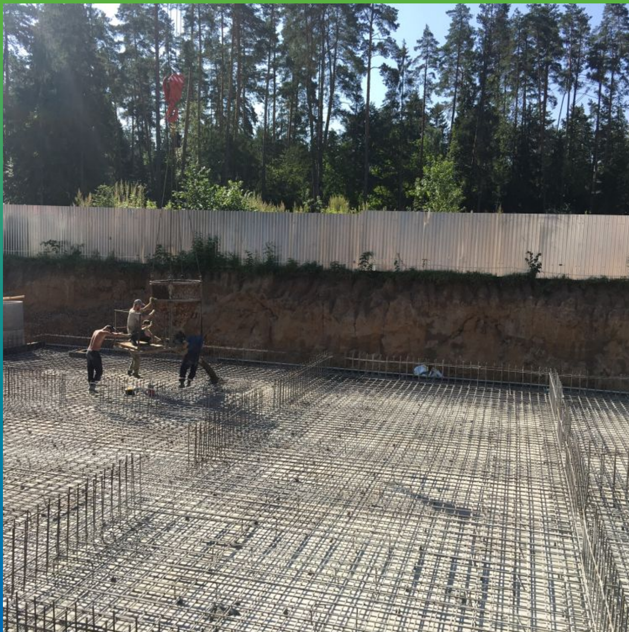
Подача бетона, отливка фундаментной плиты
