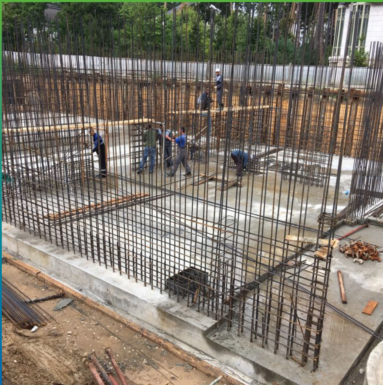
Выполненная фундаментная плита
