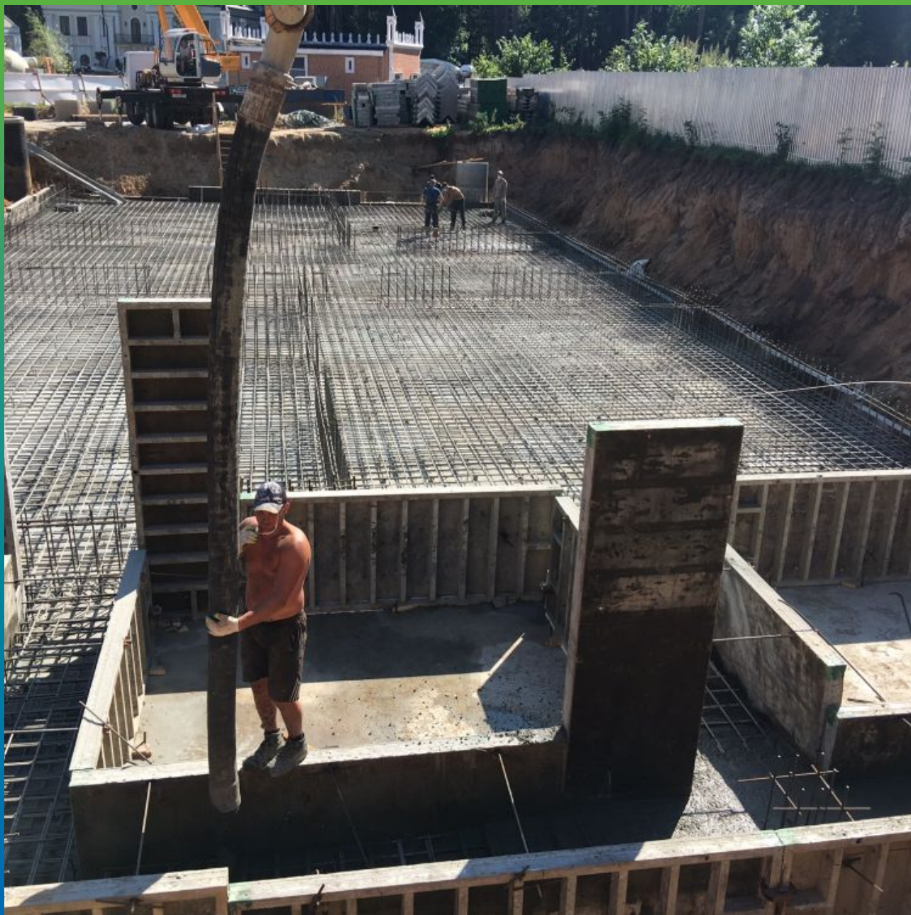
Подача бетона, отливка фундаментной плиты
