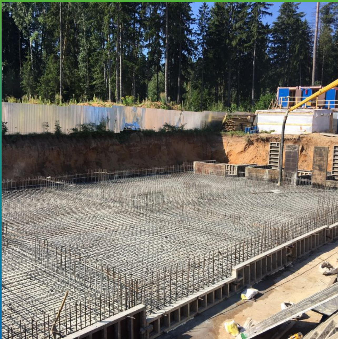
Просыпанная гидроизоляция Стармекс Сил по бетонной подготовке
