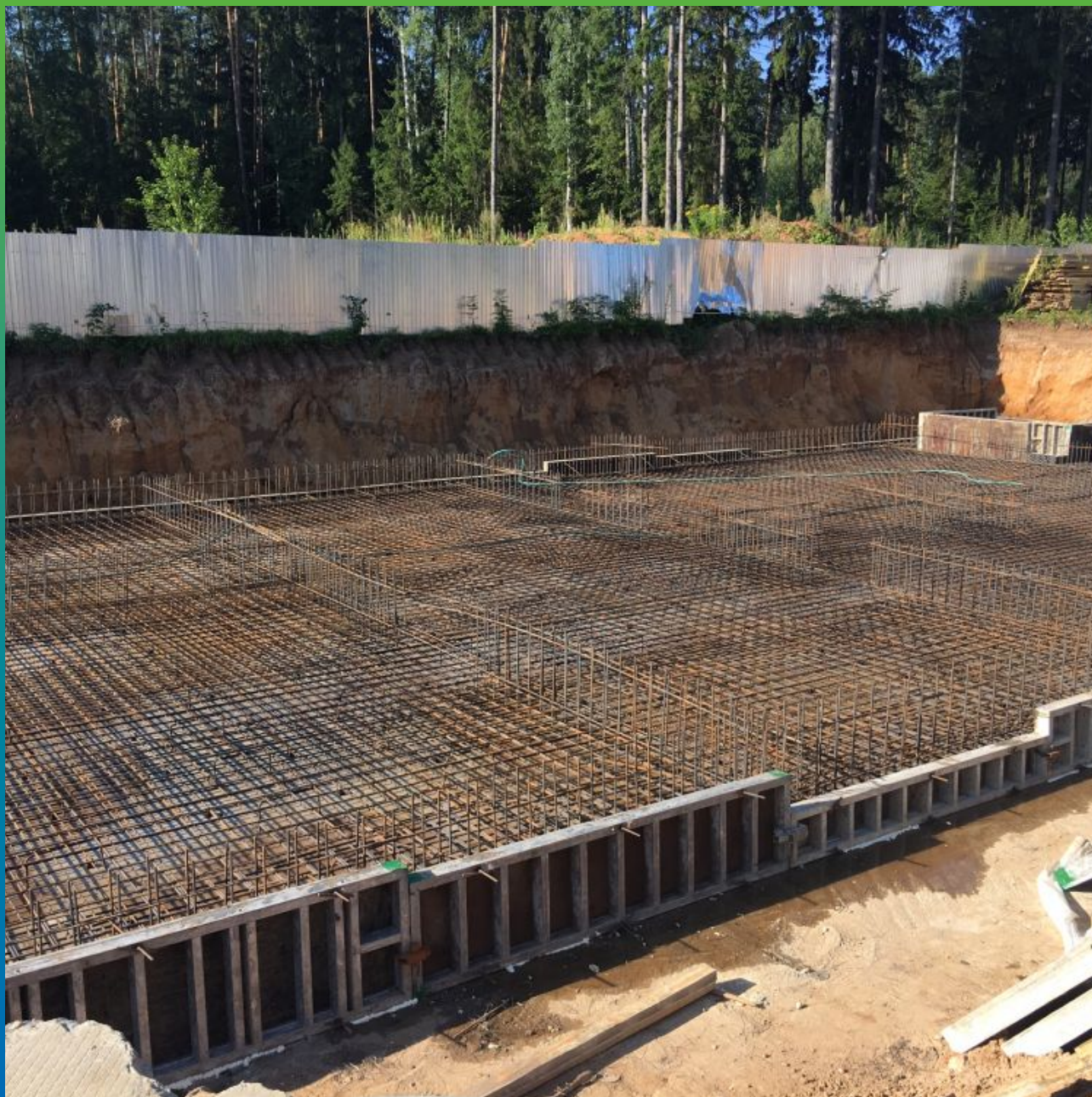
Общий вид перед бетонными работами по устройству фундаментной плиты
