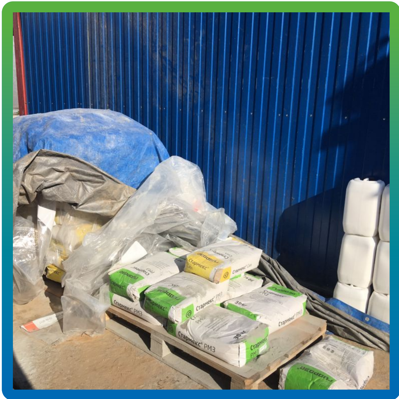
Материалы Гидрозо на объекте
