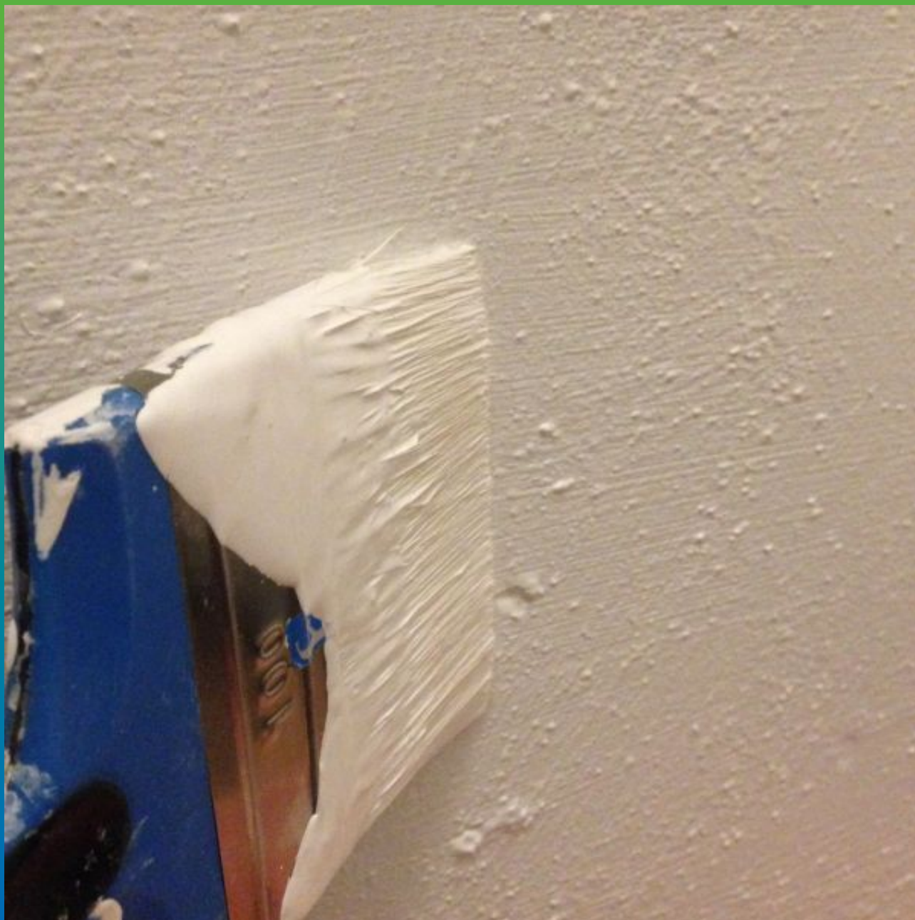
Конечный вид покрытия.
