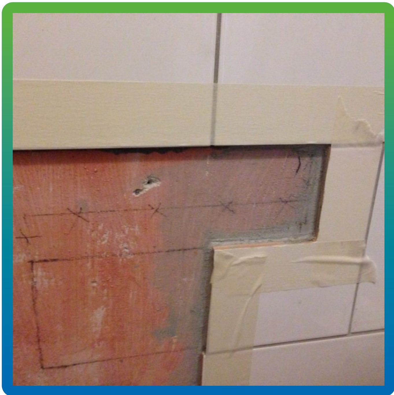
Защита кромок плитки малярным скотчем.
