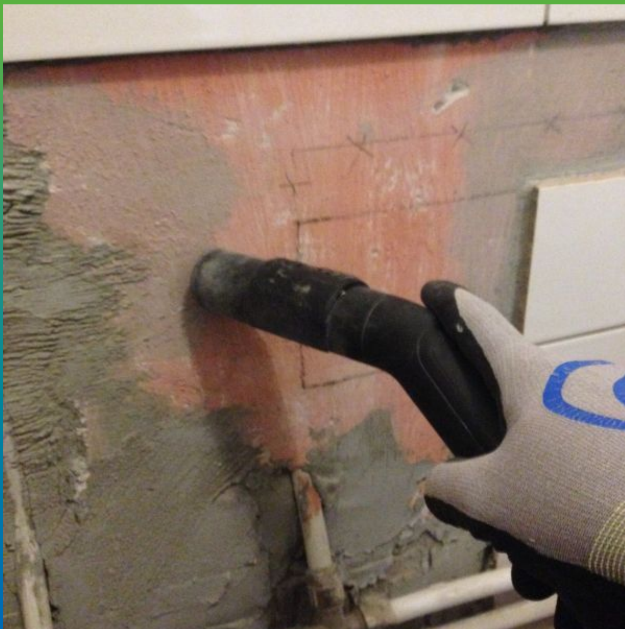
Обеспыливание поверхности строительным пылесосом.
