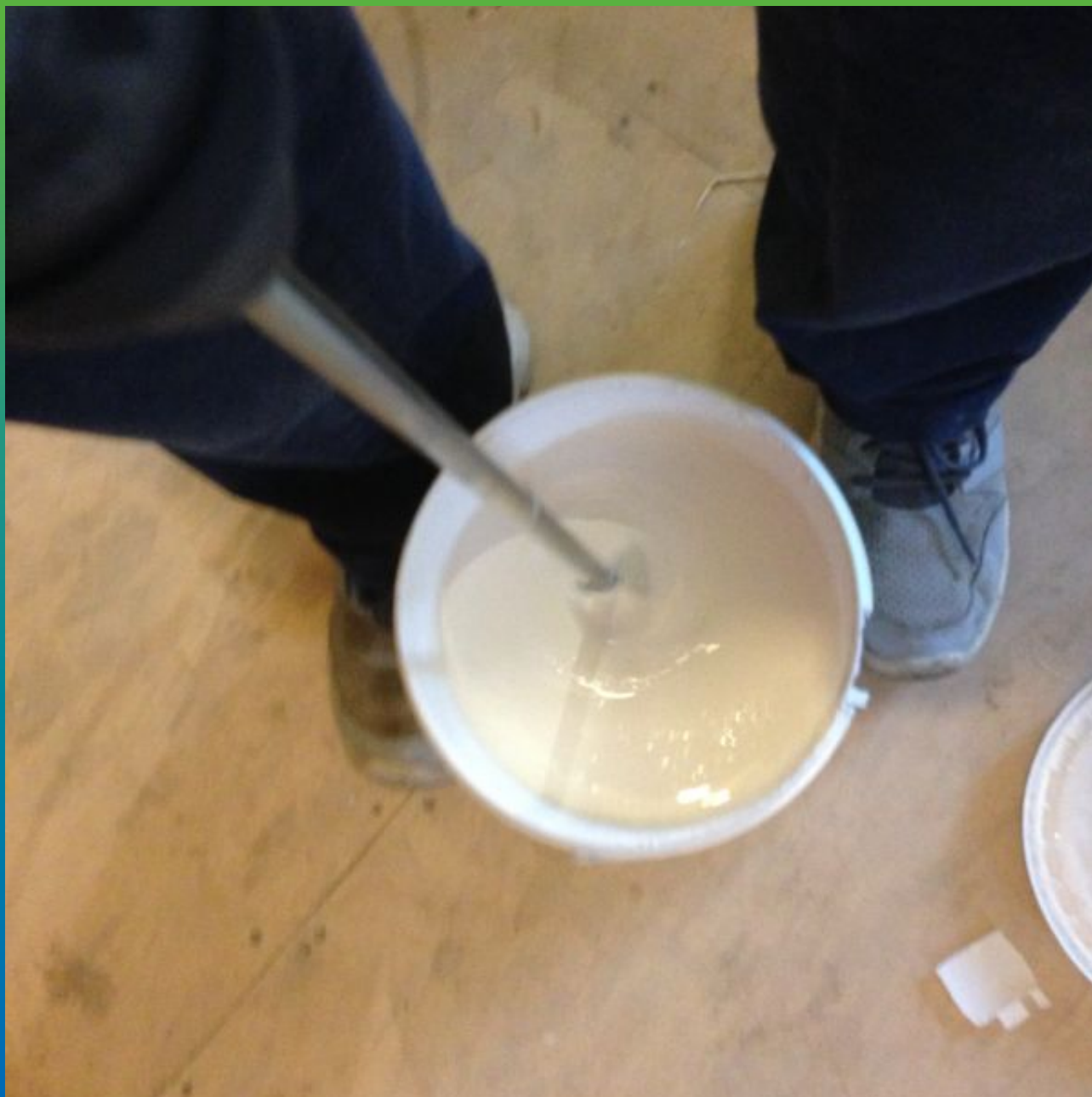
Предварительное перемешивание состава Максшин Эластик.
