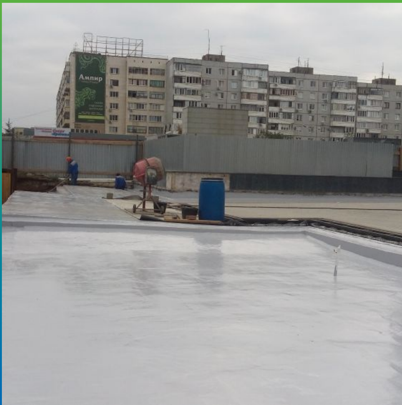
Вид нанесенного покрытия Максэластик Пур.
