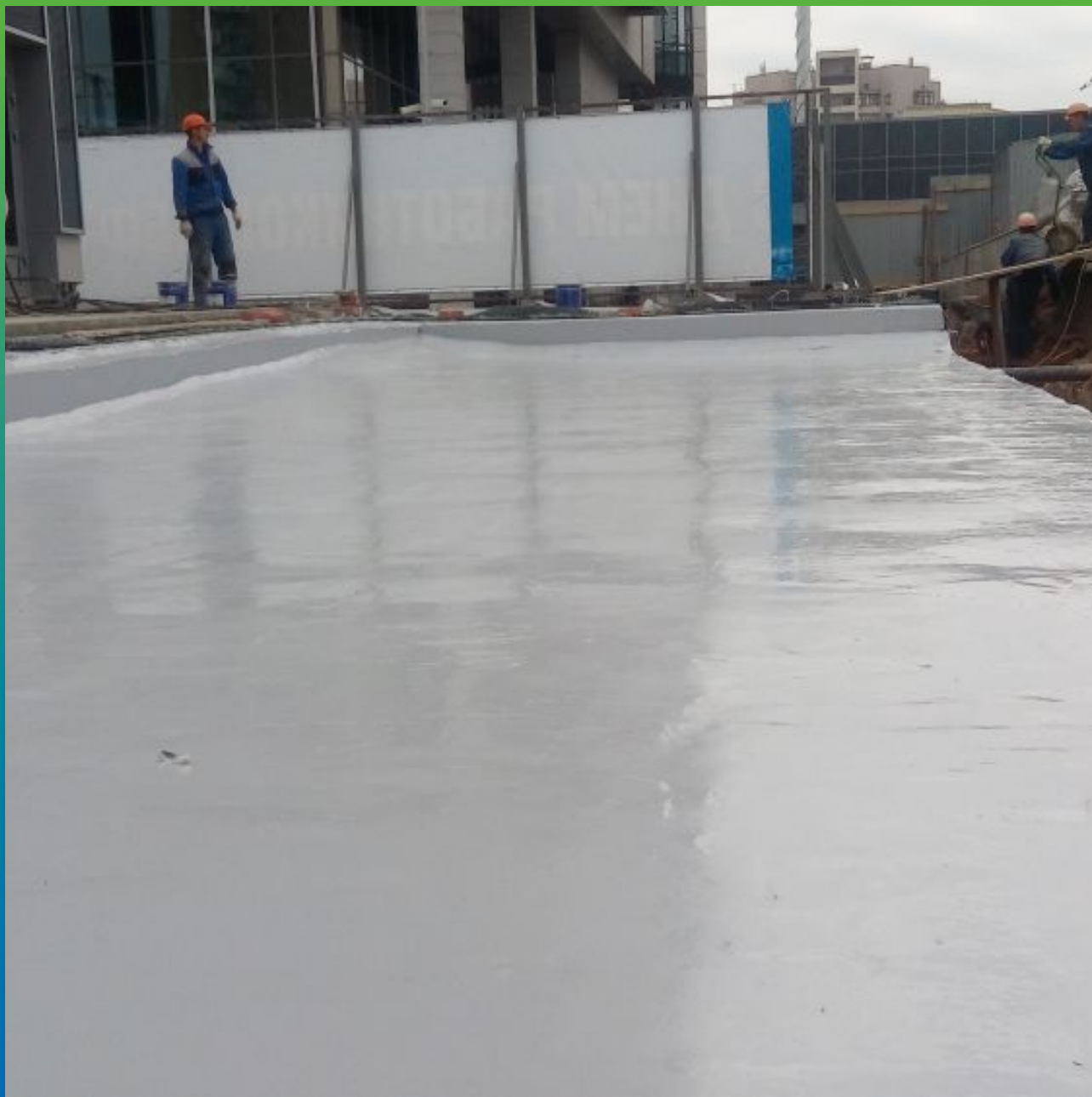
Вид нанесенного покрытия Максэластик Пур.
