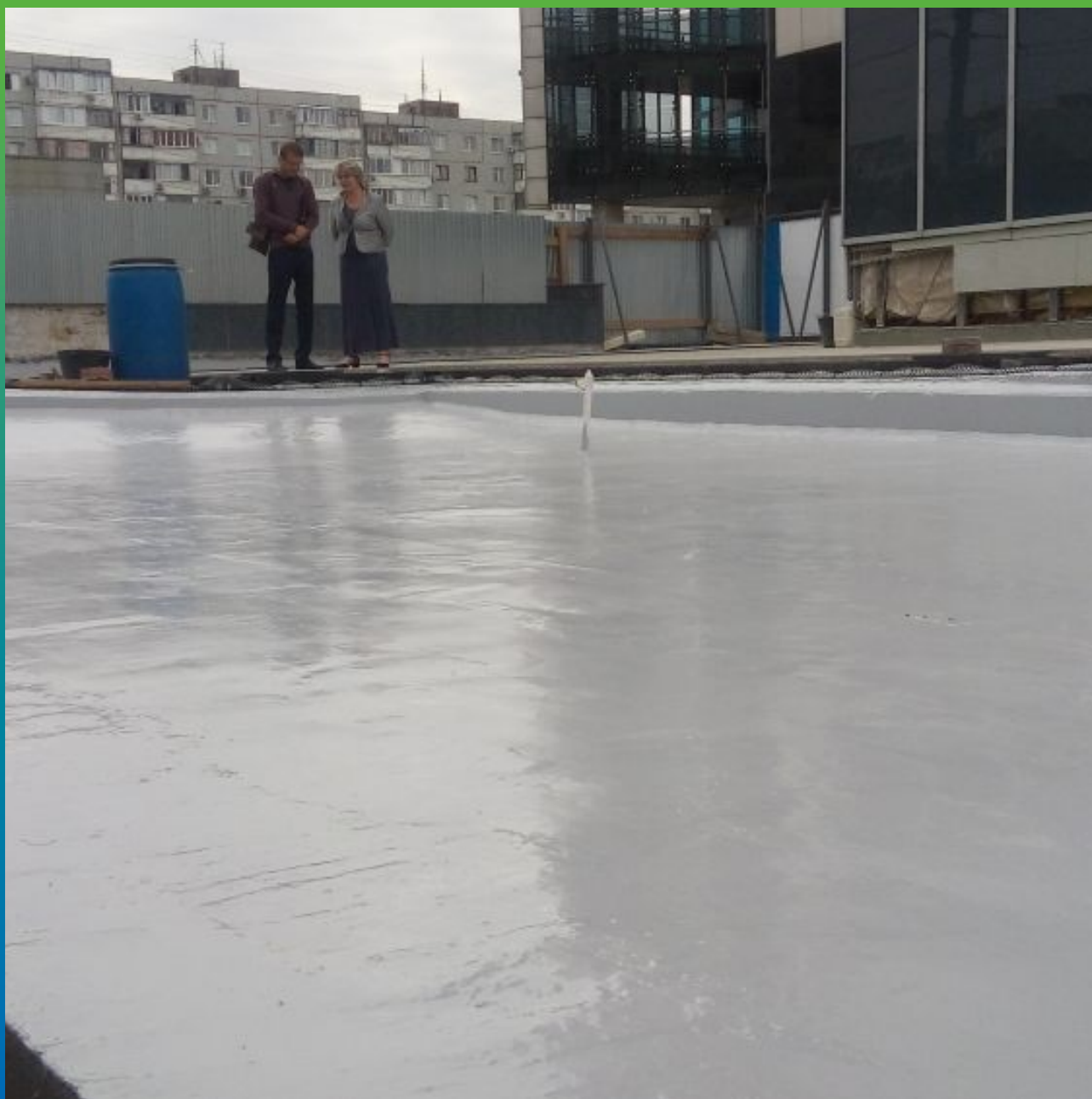
Вид нанесенного покрытия Максэластик Пур.
