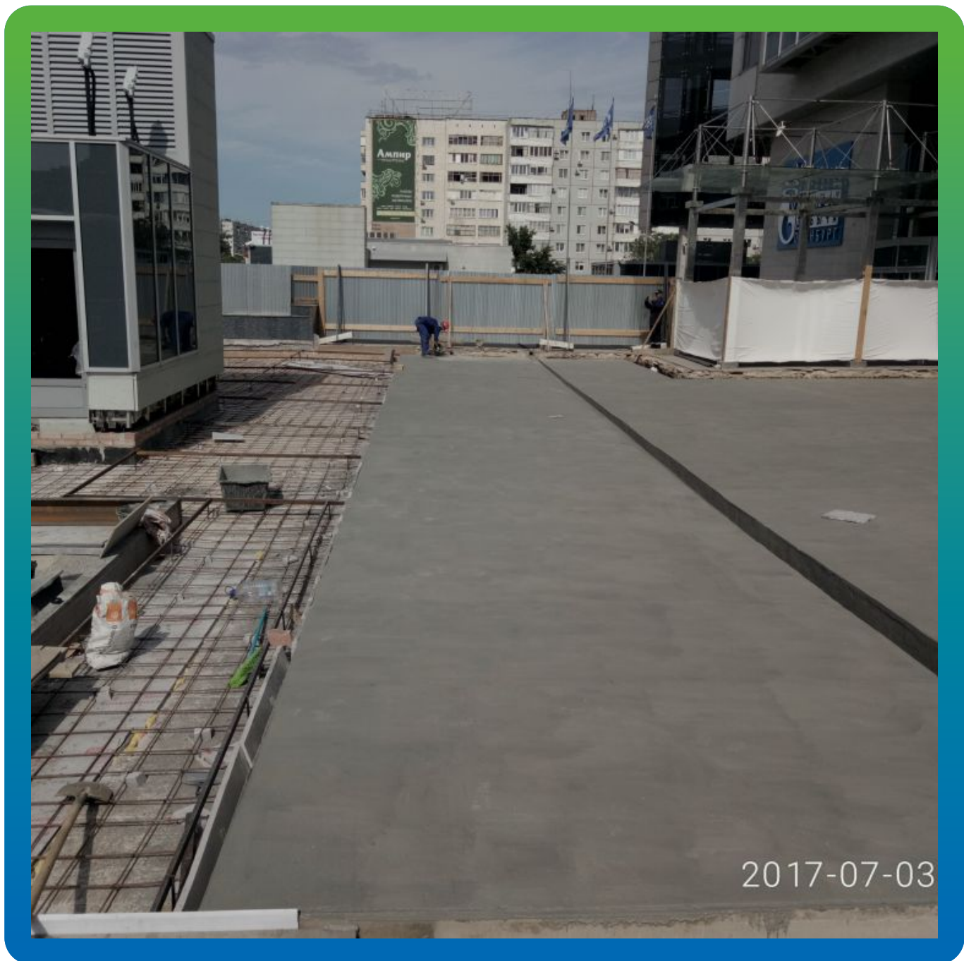
Гидроизоляция основания эластичным гидроизоляционным покрытием Стармекс Сил Флекс
