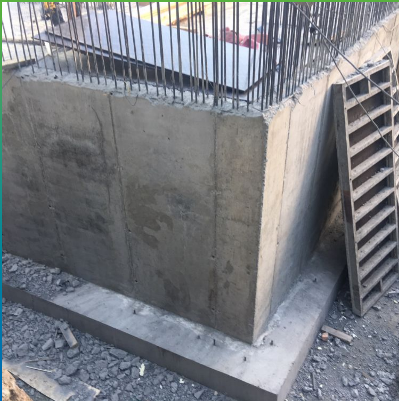
Фундамент с плитой гидроизолированной материалом Максил Супер
