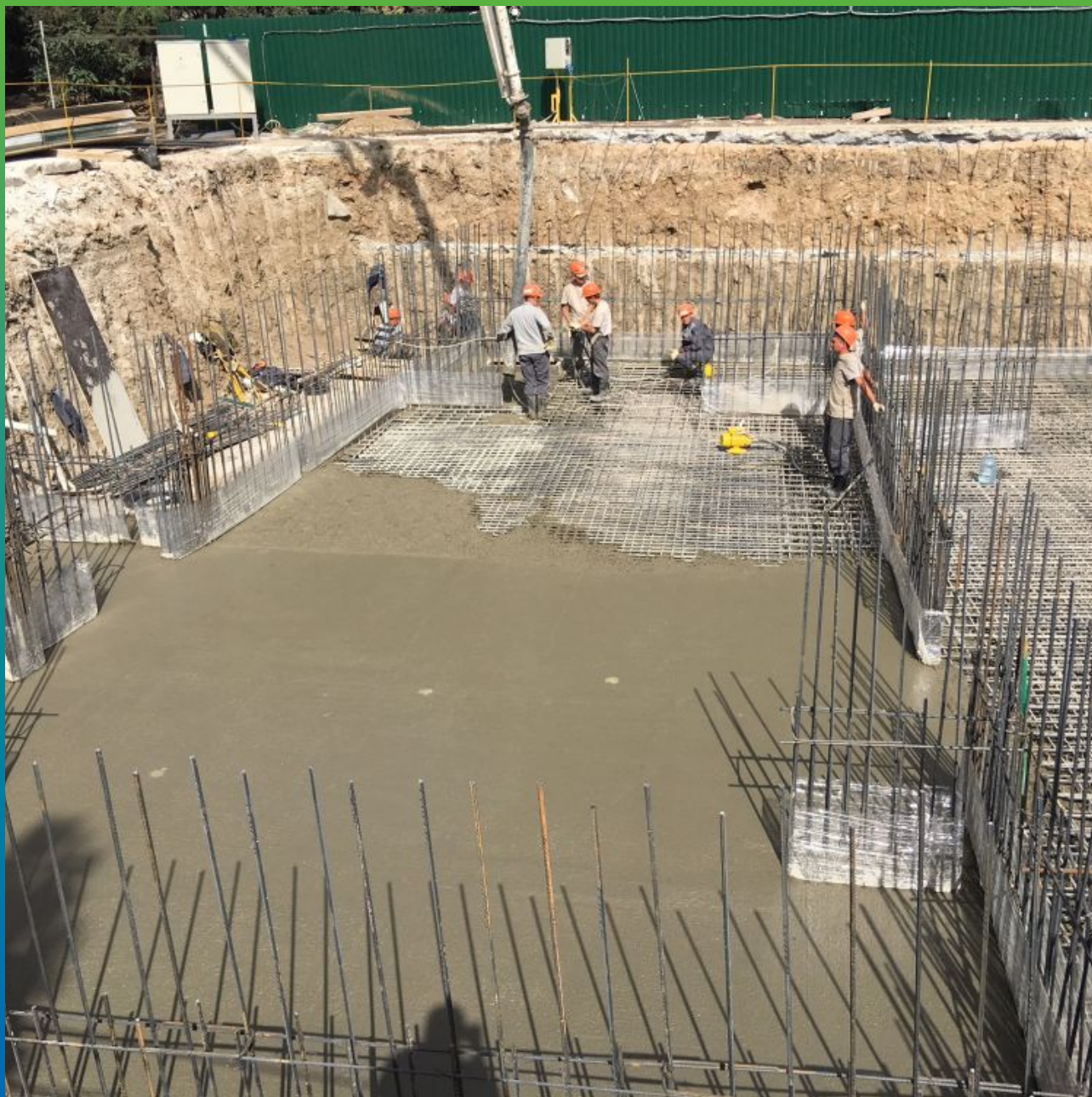
Процесс бетонирования фундаментной плиты
