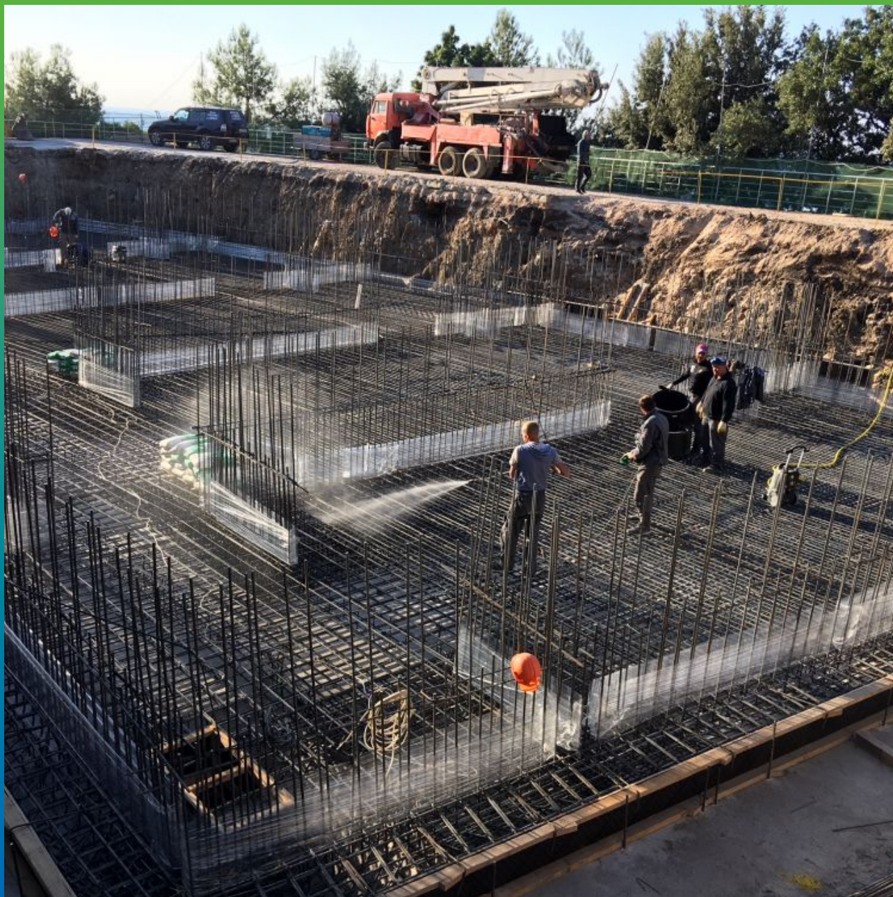
Смачивание бетонной подготовки перед гидроизоляционными работами
