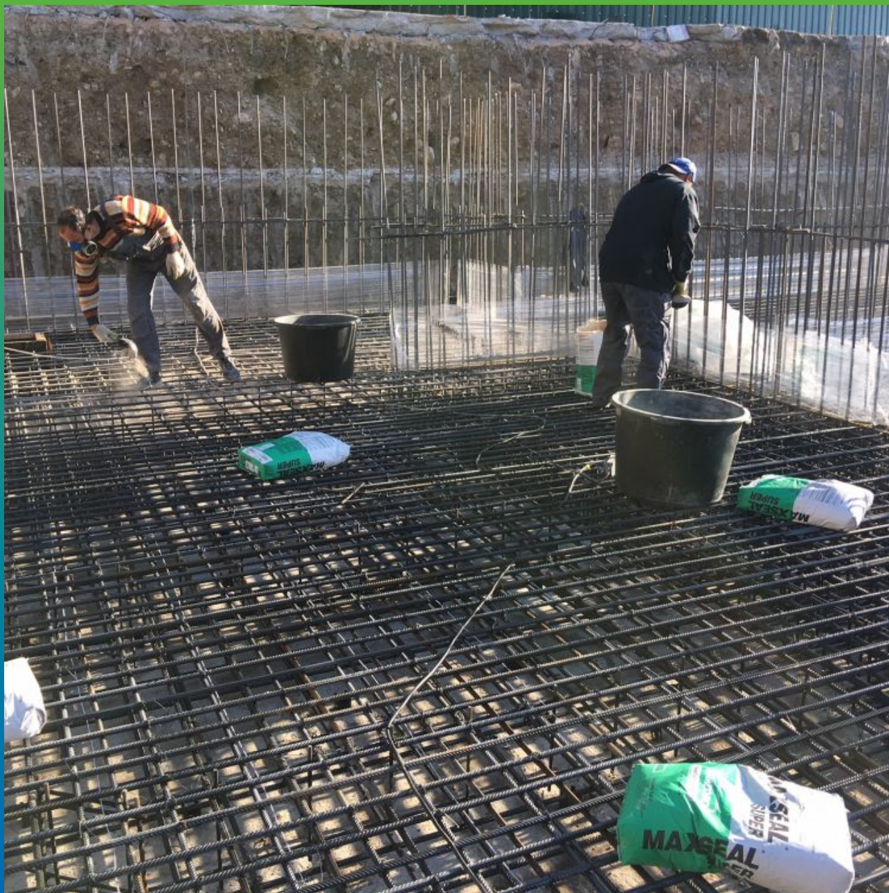
Просыпка материала Макссил Супер по бетонной подготовке и арматурному каркасу
