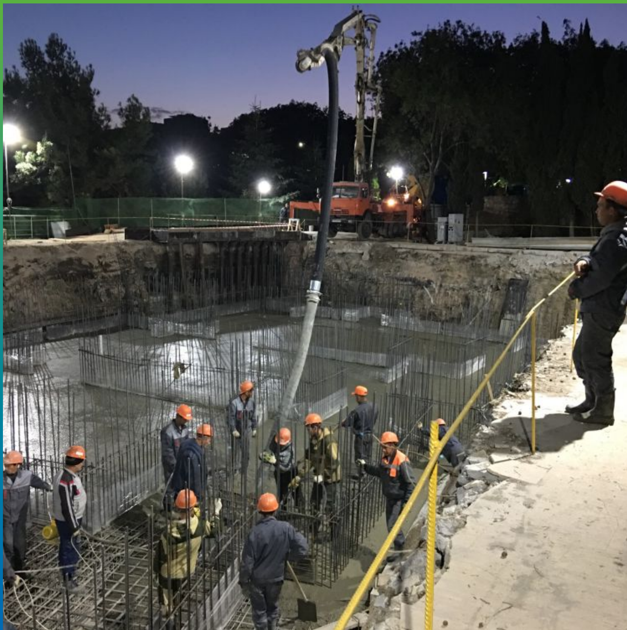
Работы по бетонированию фундаментной плиты в ночное время
