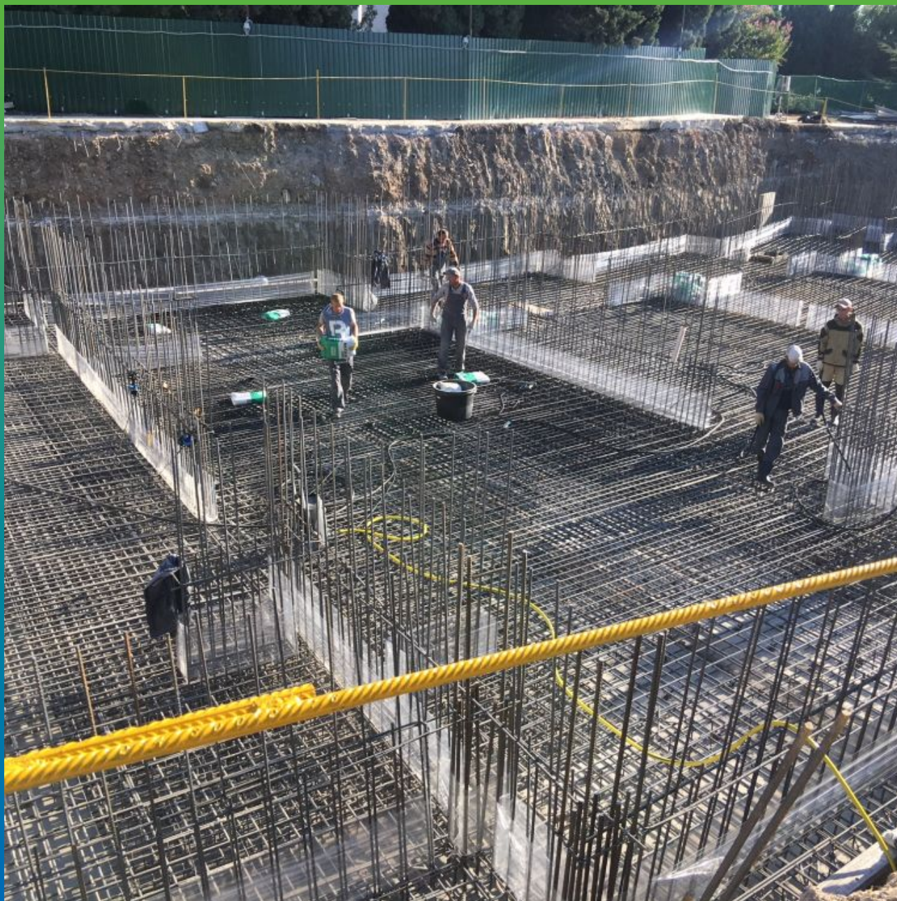
Распределение мешков Макссил Супер по арматурному каркасу
