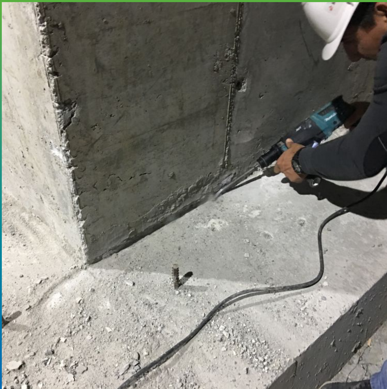
Штрабление примыкания стены с полом
