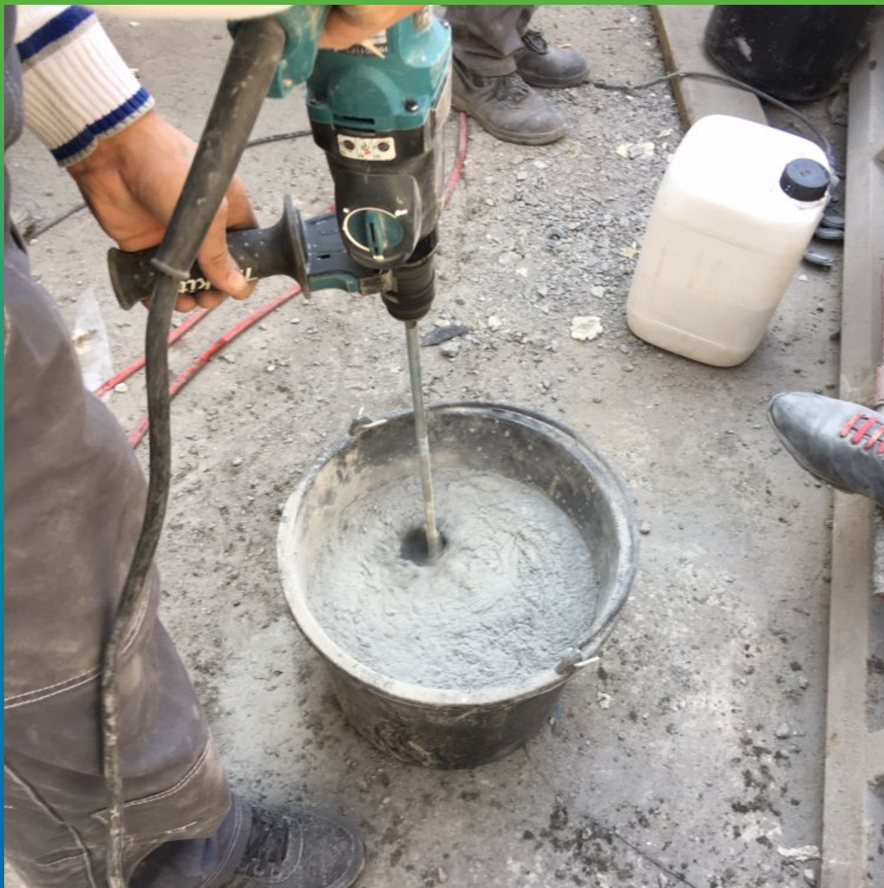
Подготовка гидроизоляционного раствора Стармекс Сил Флекс
