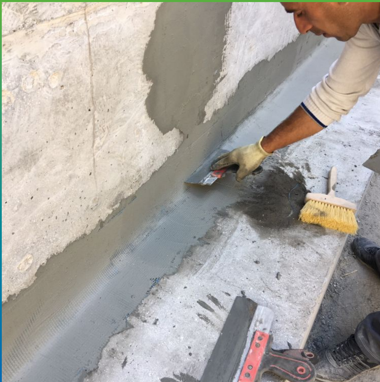
Нанесение Стармекс Сил Флекс на примыкание стены с полом
