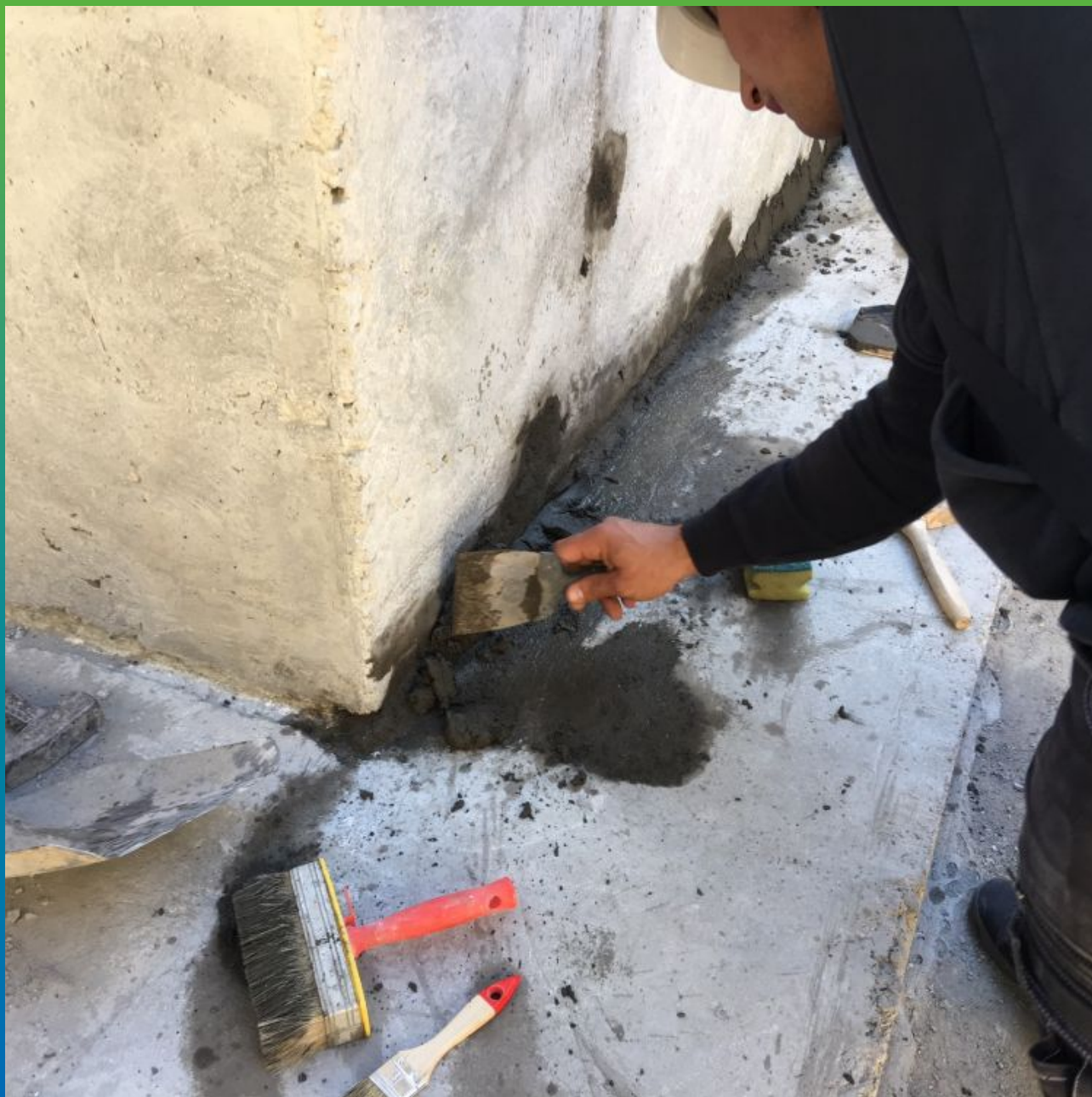
Заделка штрабы раствором Максрайт 700
