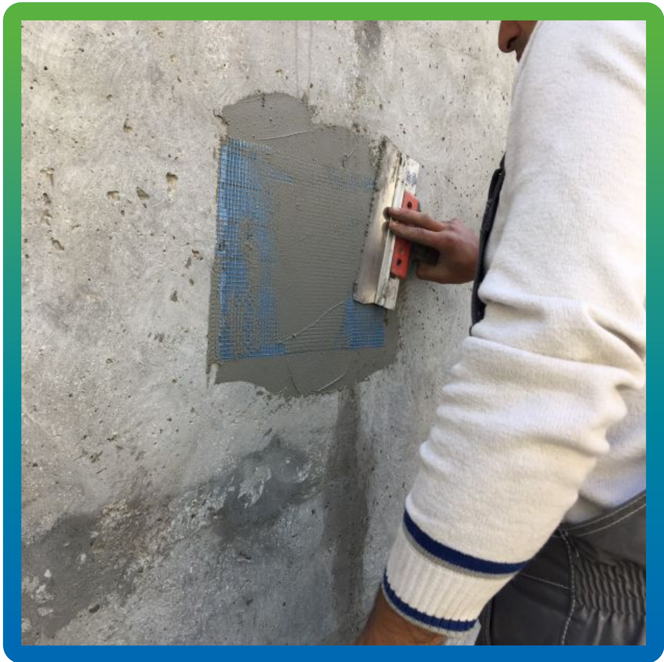
Нанесение Стармекс Сил Флекс через стеклоткань на место отверстий от опалубки
