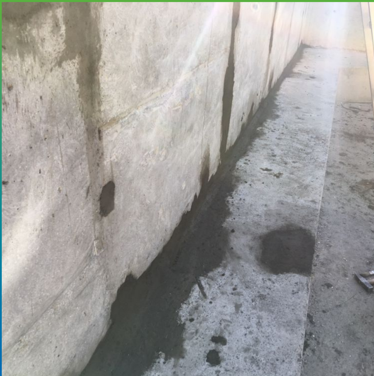
Вид отремонтированной стены и заделанной штрабы раствором Максрайт 700
