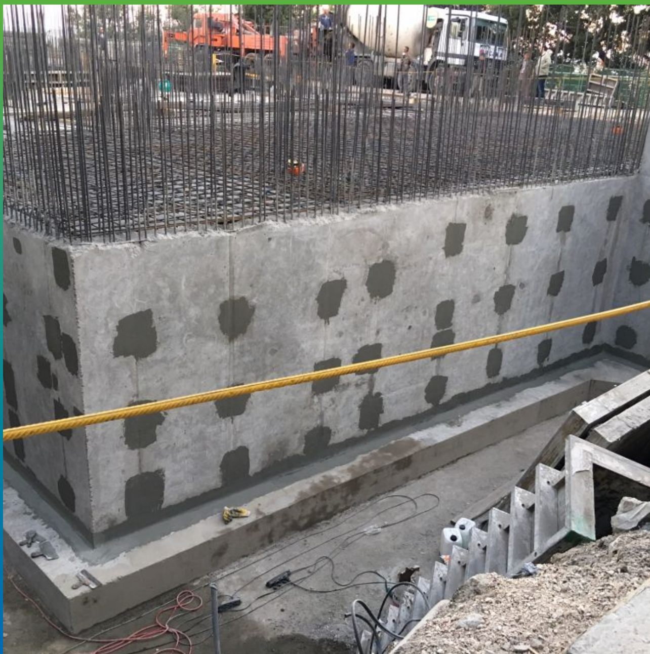
Вид подземной части с заделанными отверстиями и примыканием
