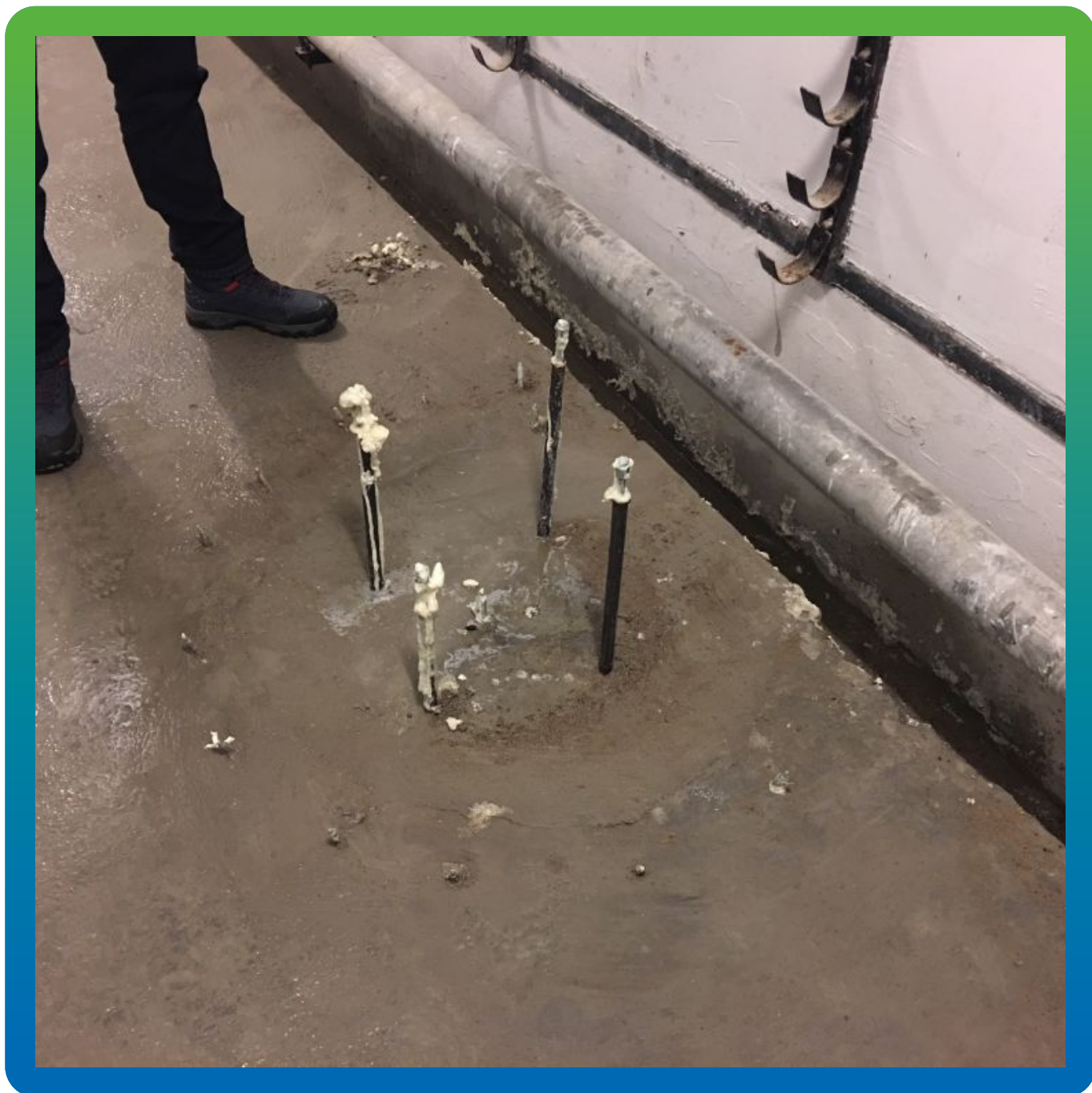
Остановленные протечки по зумпфу
