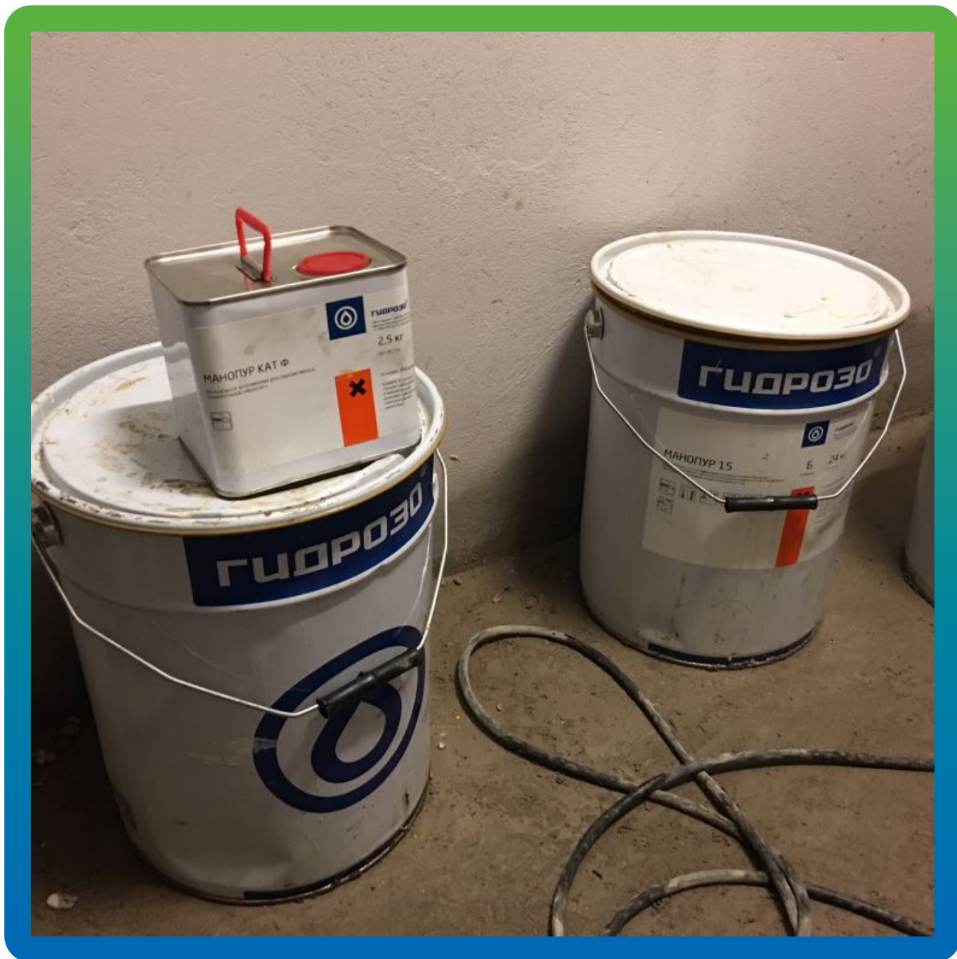
Продукция Гидрозо на объекте
