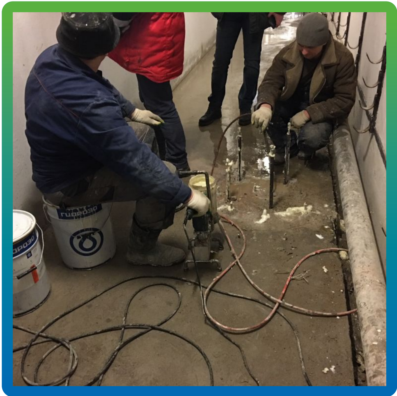
Инъектирование материала Манопур 15
