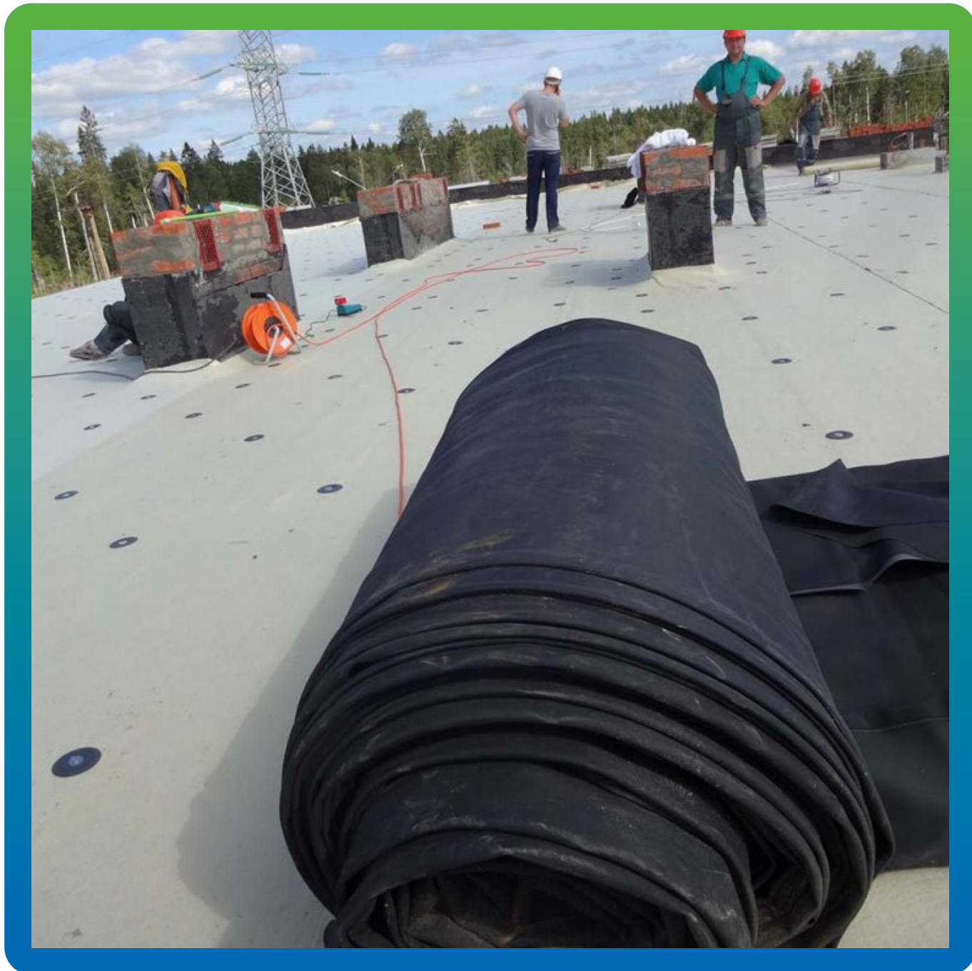
Мембраны Прелести СТ 1,2 мм на объекте
