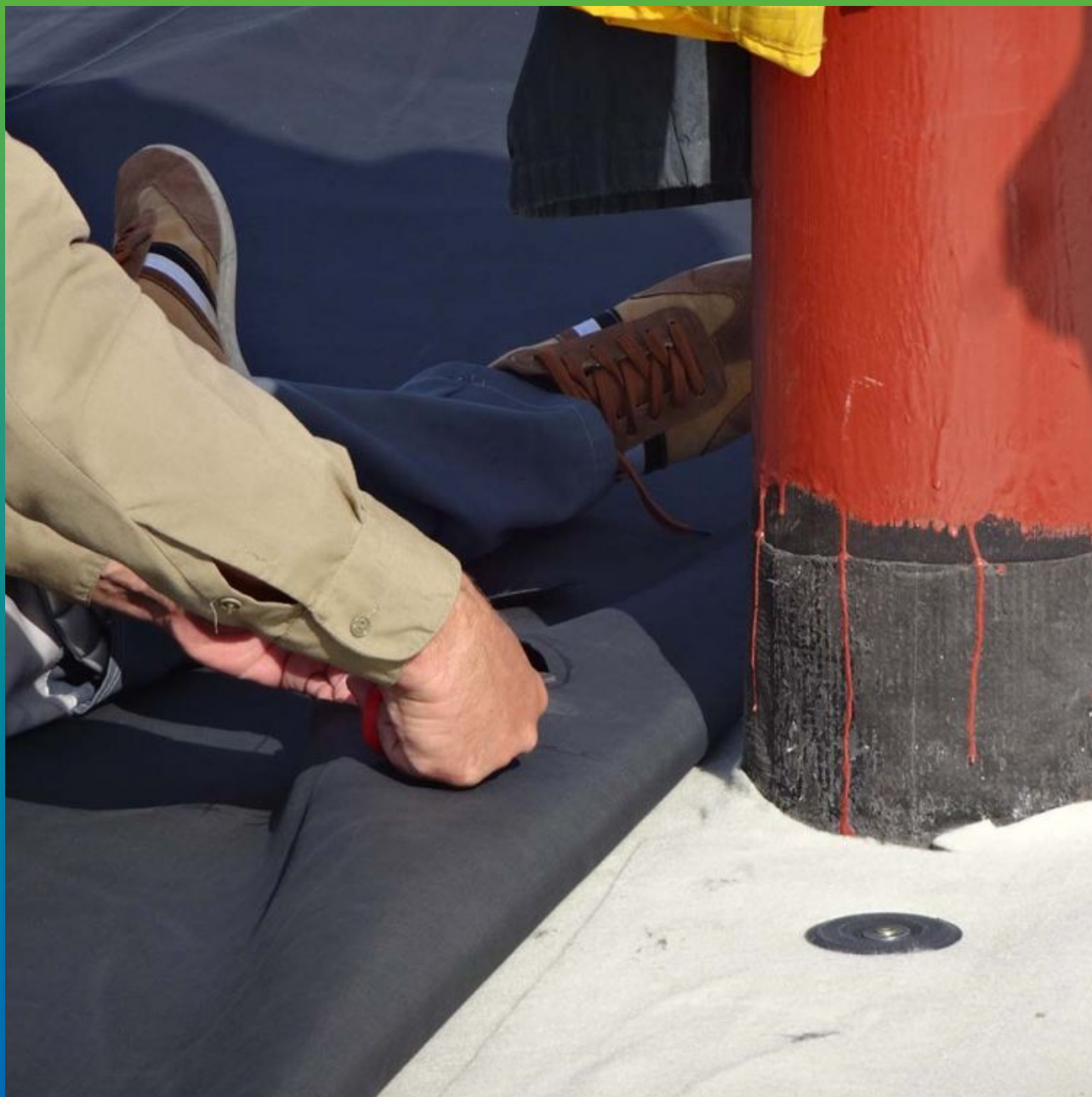
Монтаж технологических отверстий в мембране с учетом особенностей стройплощадки
