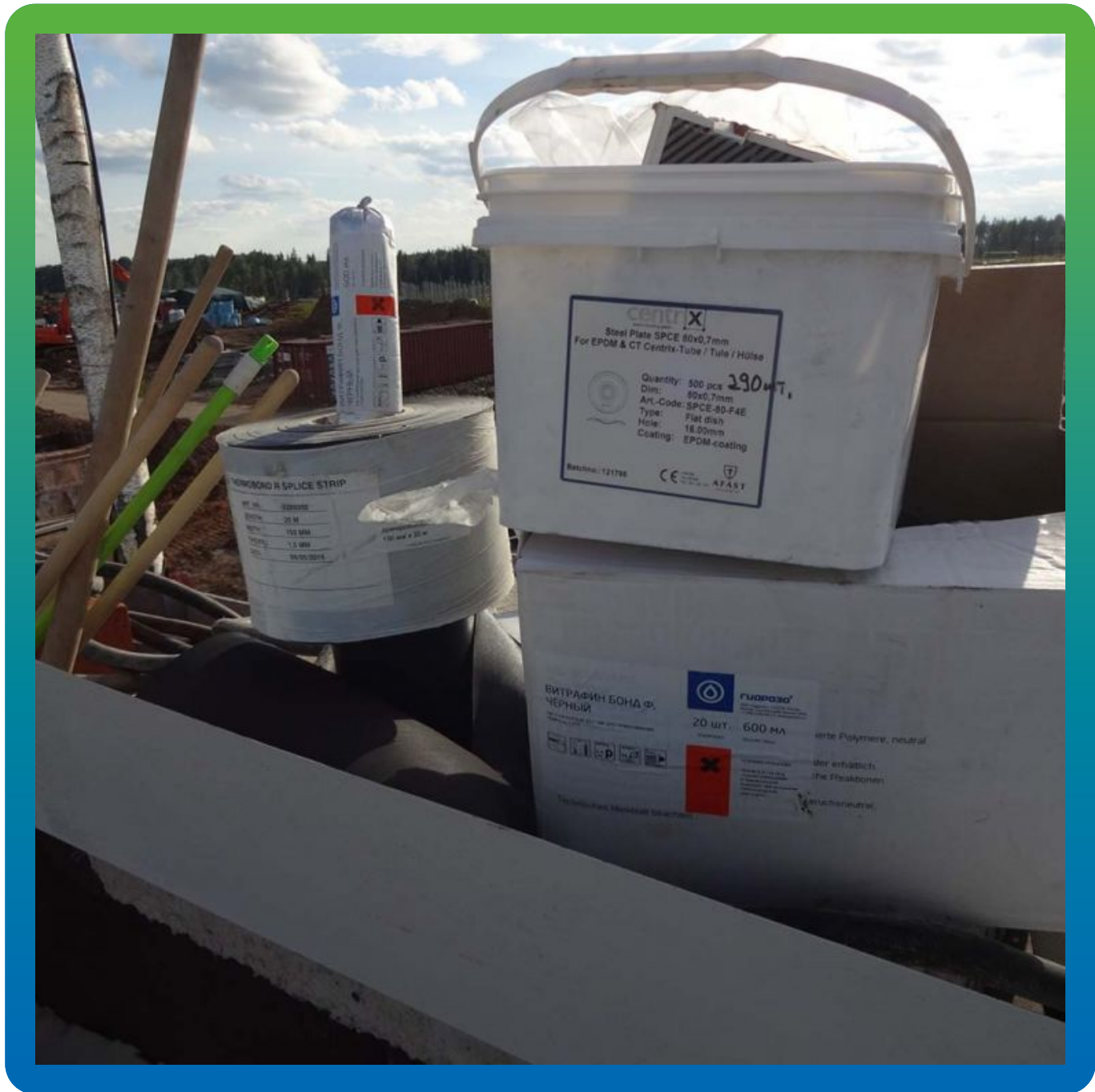
Материалы Гидрозо на объекте
