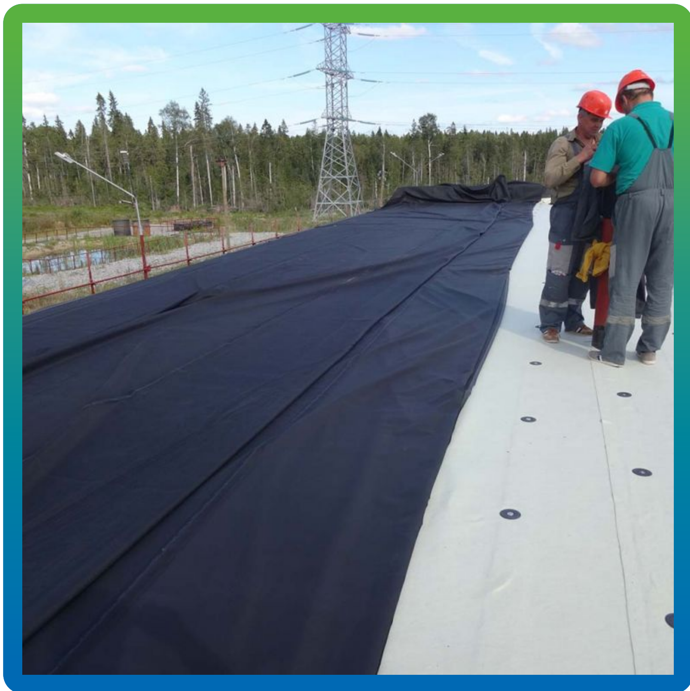
Процесс растаскивания мембраны Преласты СТ 1,2 мм на кровле
