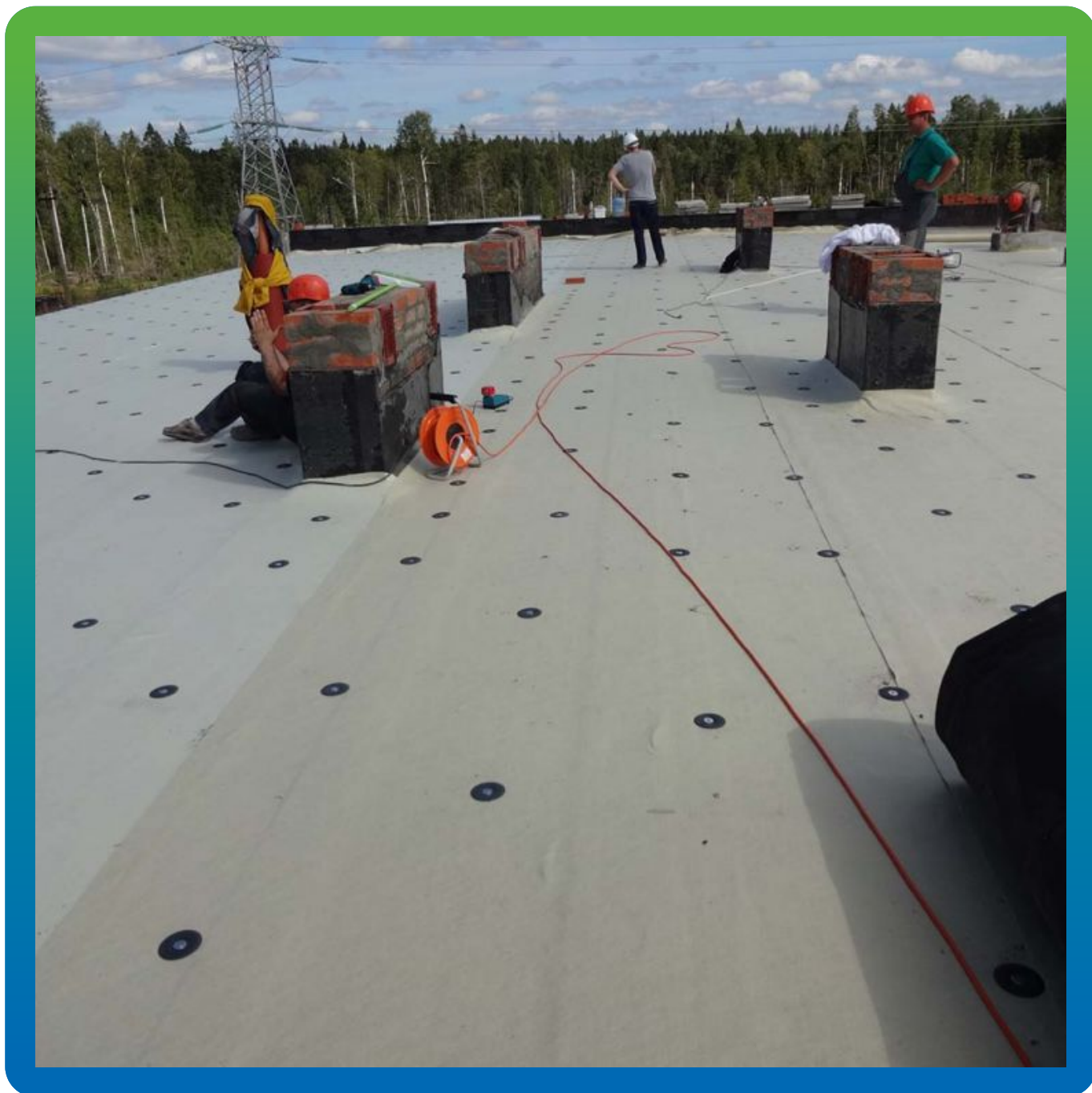
Установка шайб "Центрикс" на подготовленное основание
