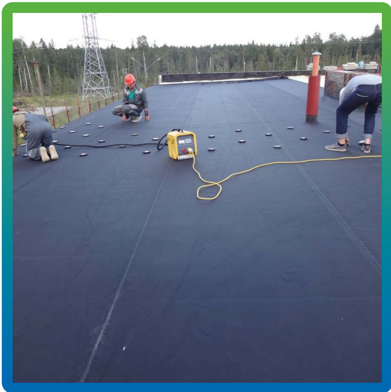
Механическое крепление шайб Центрикс к мембране Преласты СТ 1,2 мм. без прокола мембраны
