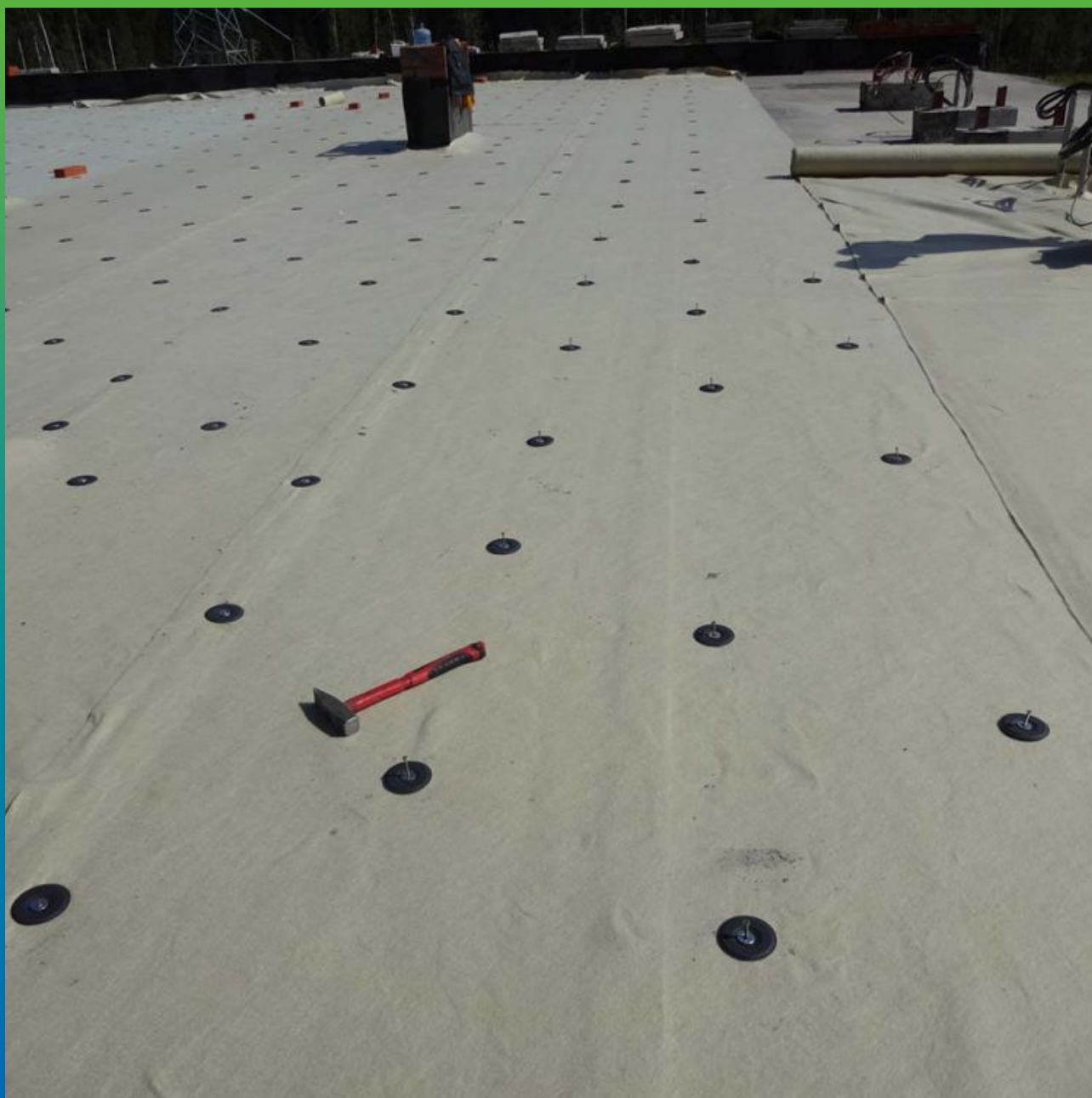
Установка шайб "Центрикс" на подготовленное основание
