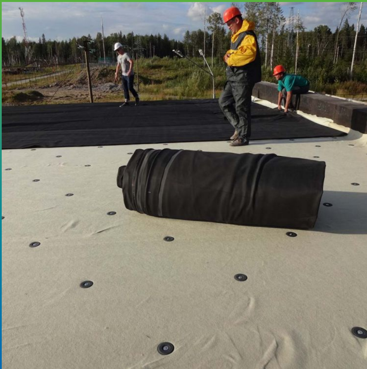
Процесс растаскивания мембраны Преласта СТ 1,2 мм на кровле
