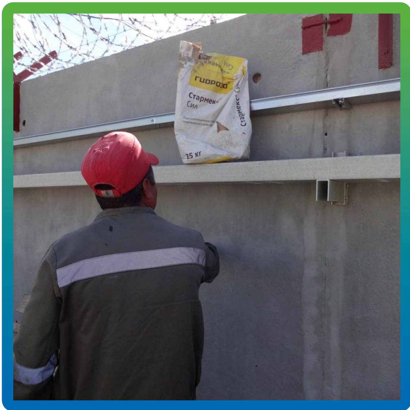
Нанесение Стармекс Сил на увлажнённую поверхность
