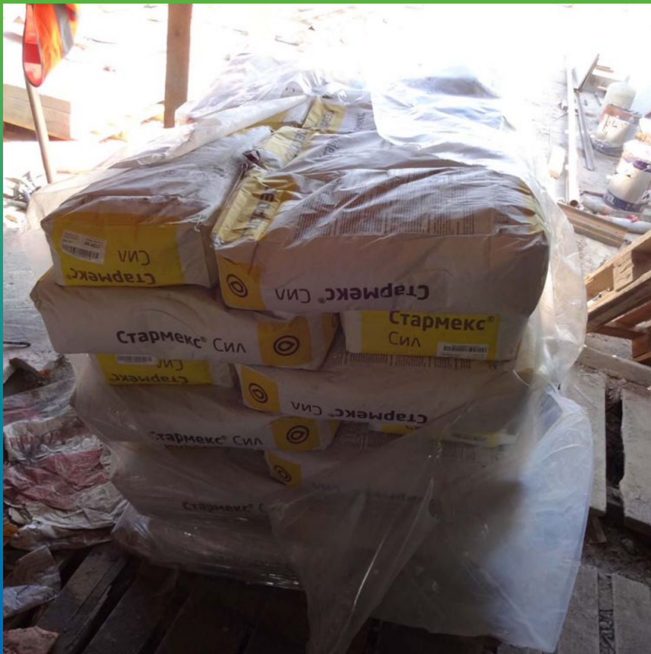
Материалы Гидрозо на объекте
