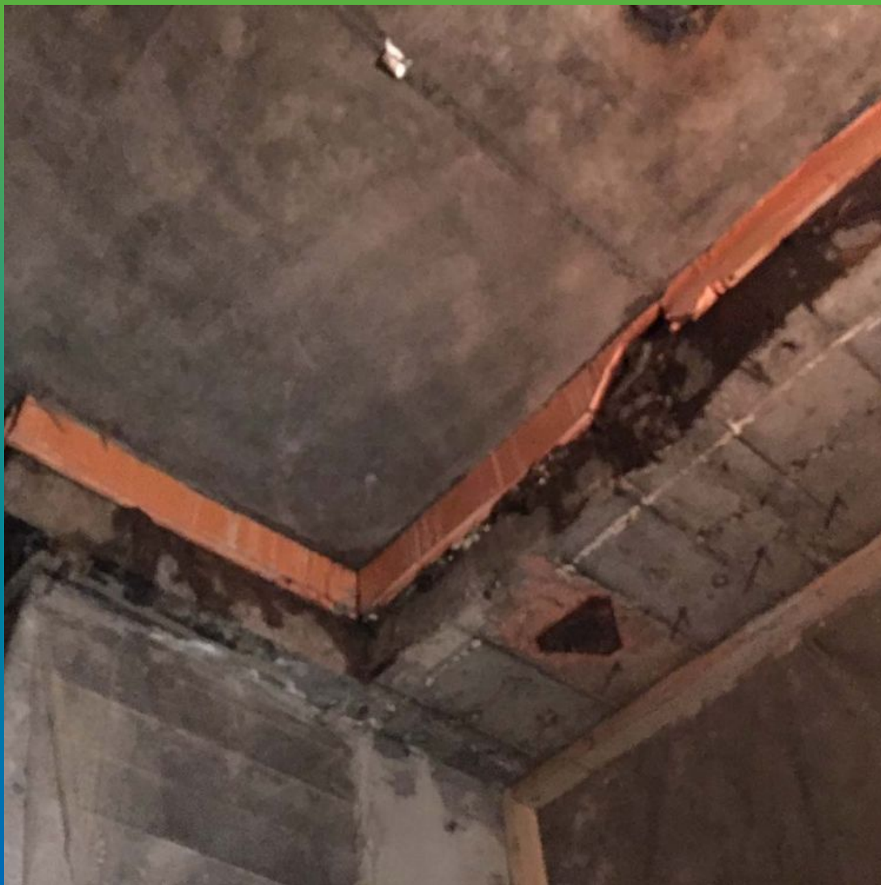
Протечки по деформационному шву
