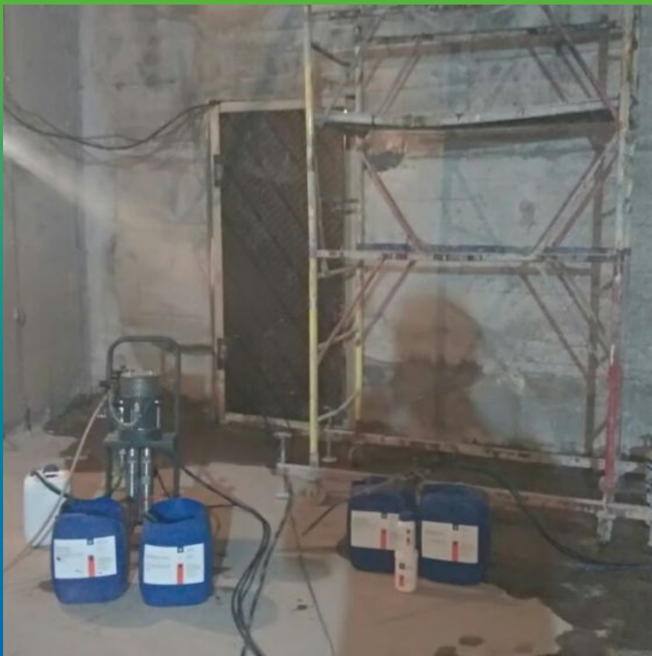
Подготовка оборудования и материала для инъектирования
