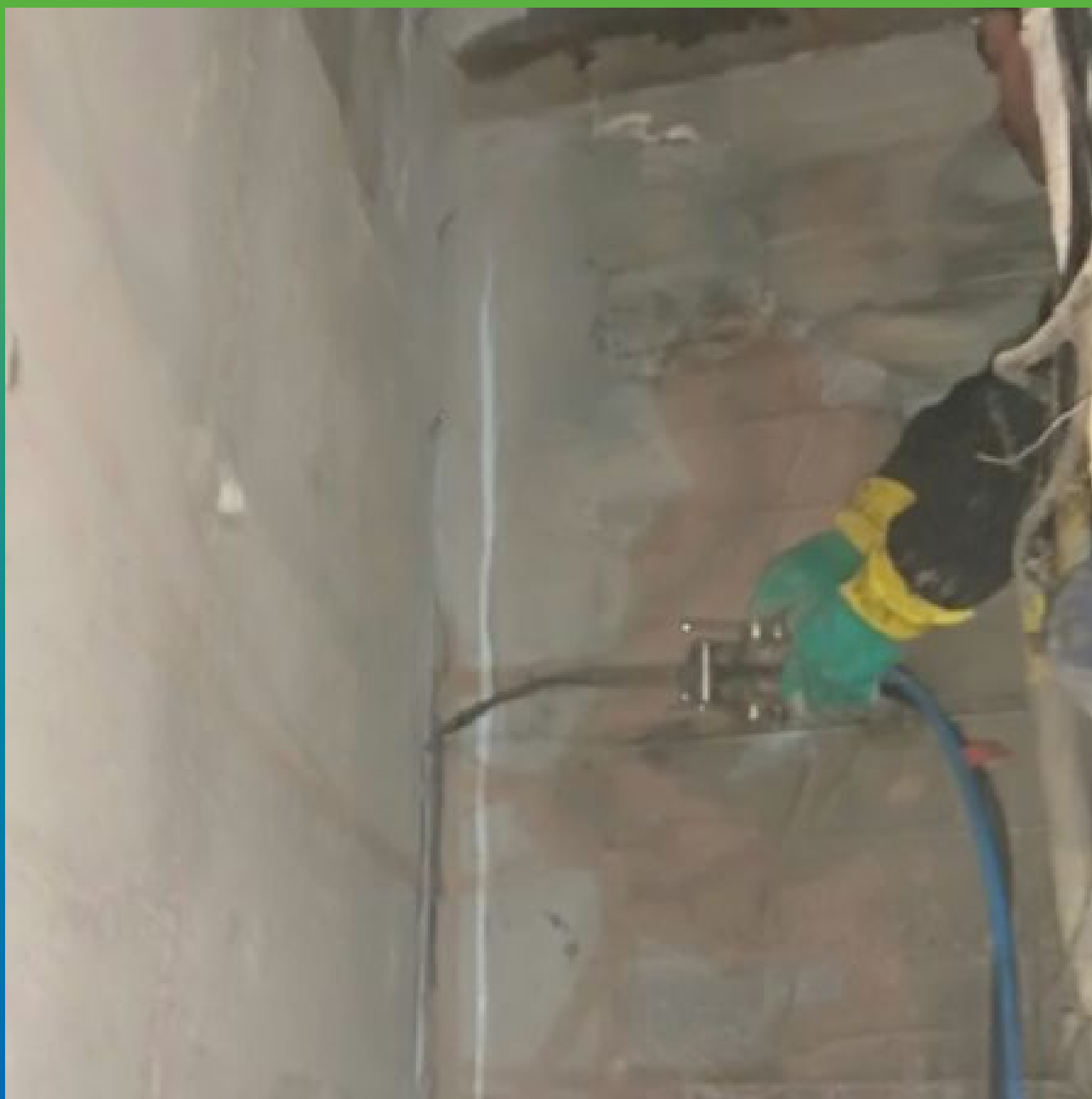
Инъектирование вертикальной части шва
