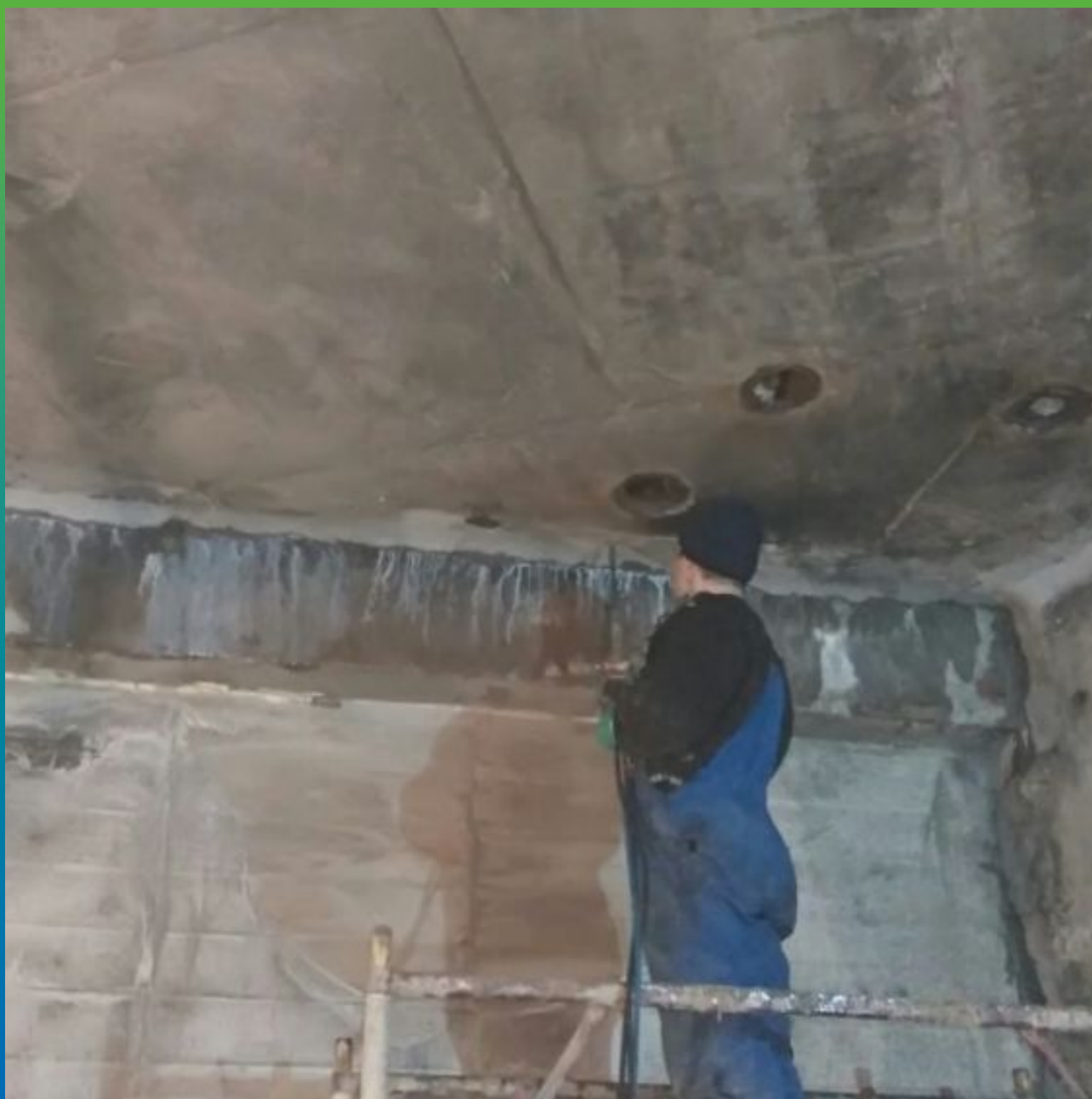
Инъектирование деформационного шва материалом Манокрил гель В + Манокрил Флекс
