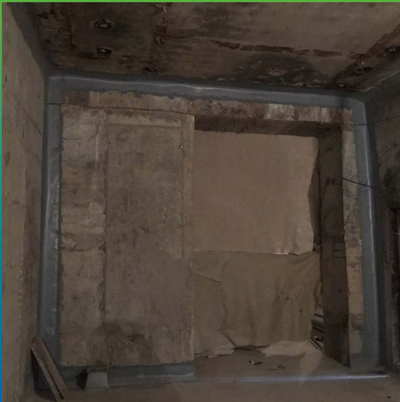
Деформационный шов с финишной защитной лентой Манодил Про приклеенной Манопоксом 331
