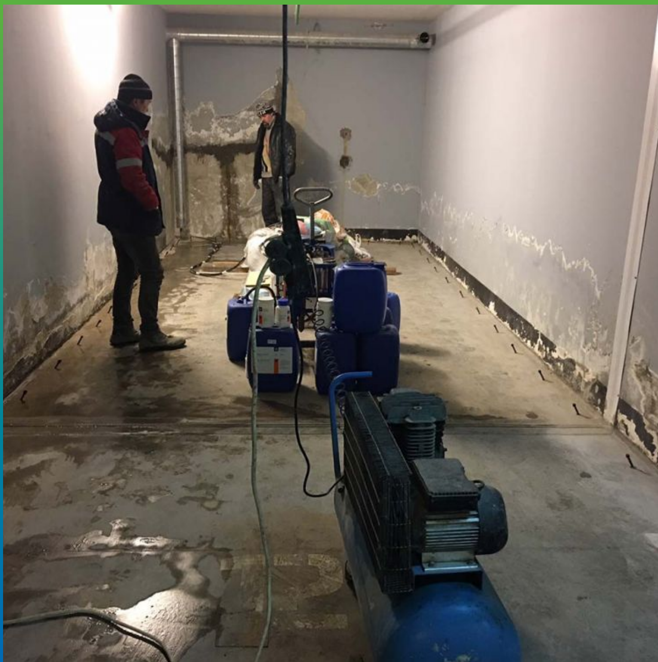
Общий вид рабочего места с подготовленным оборудованием и материалом для инъектирования
