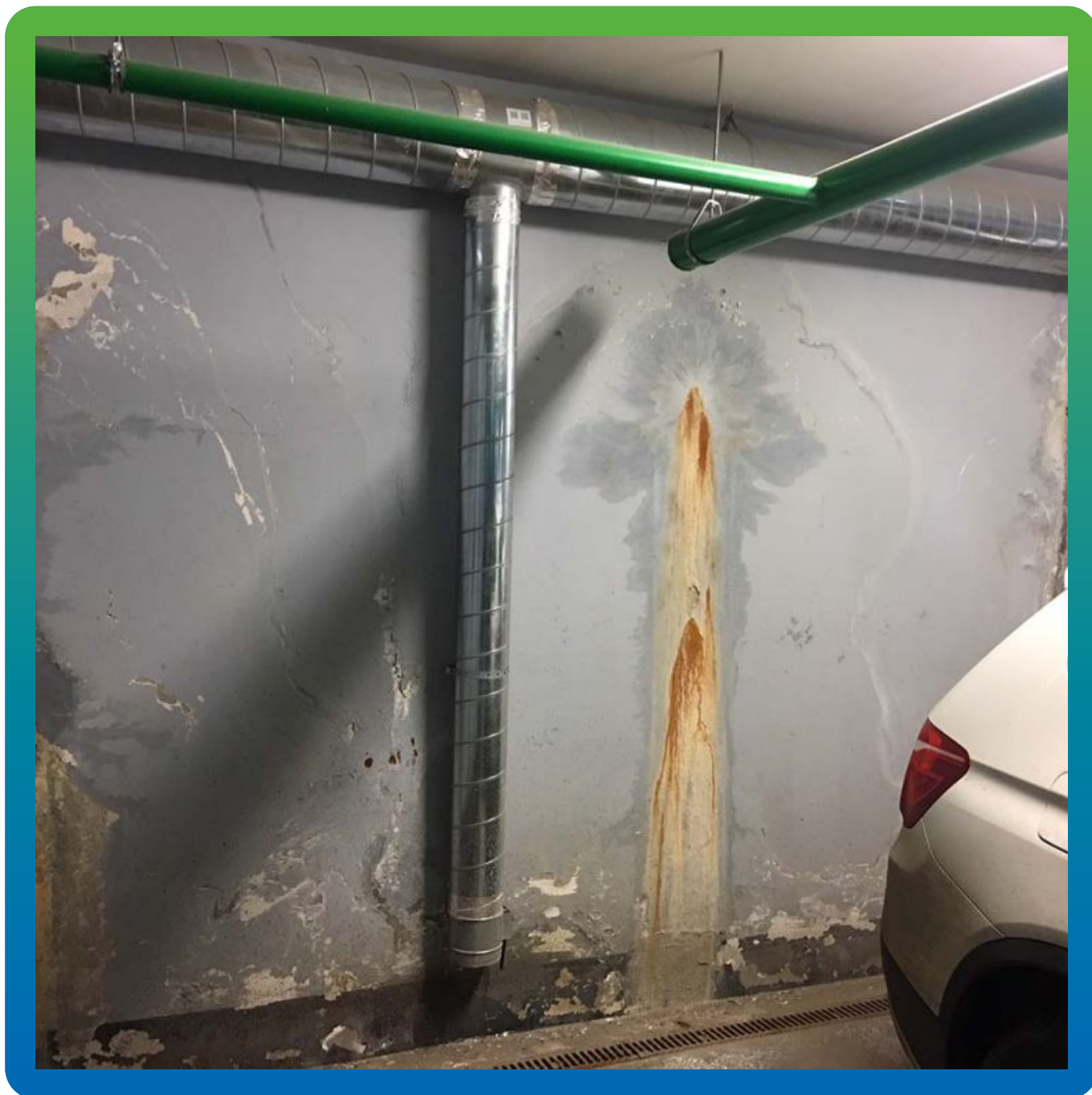
Вид стены до проведения работ
