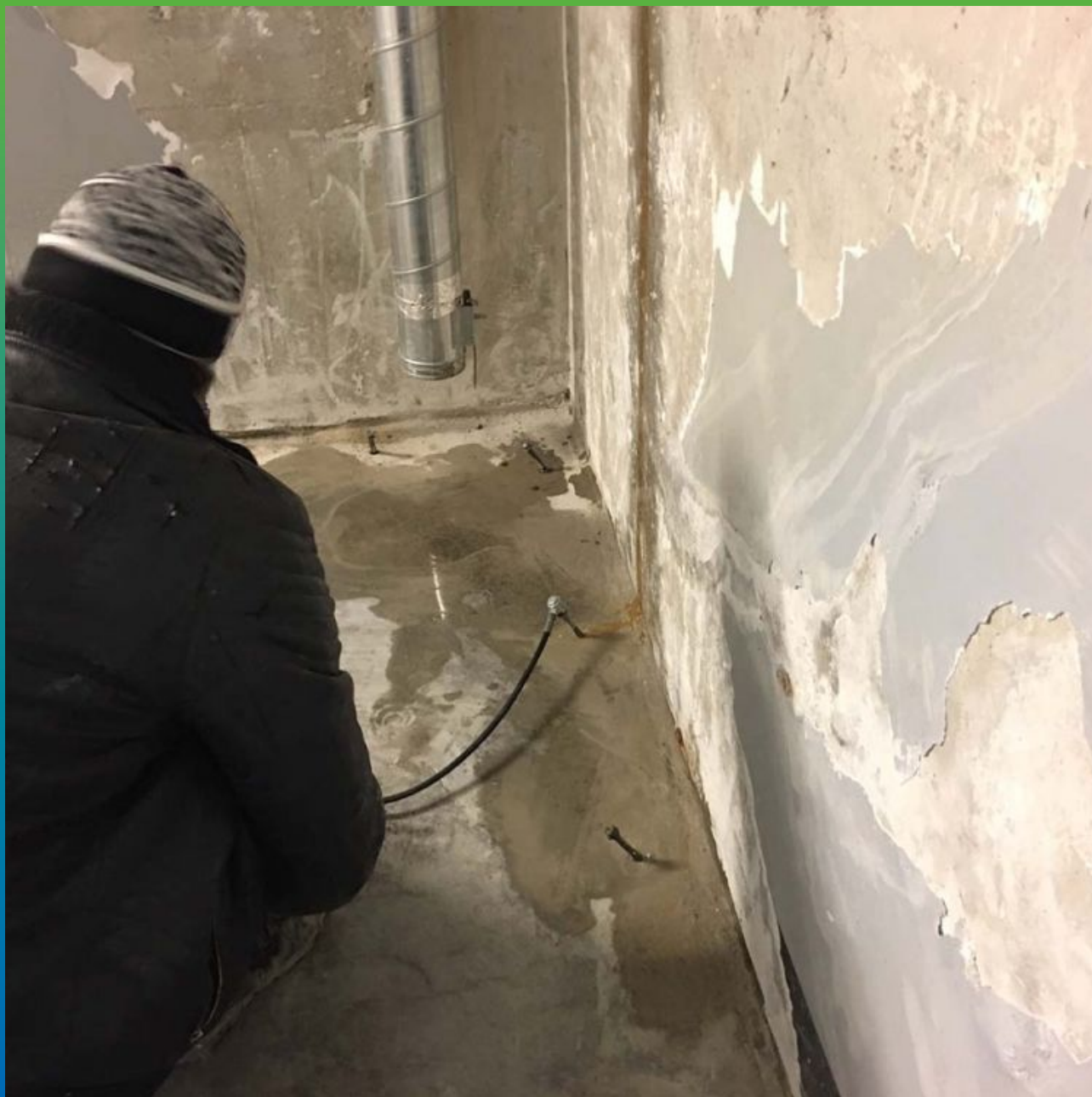
Инъектирование холодного шва материалом Манокрил Гель В
