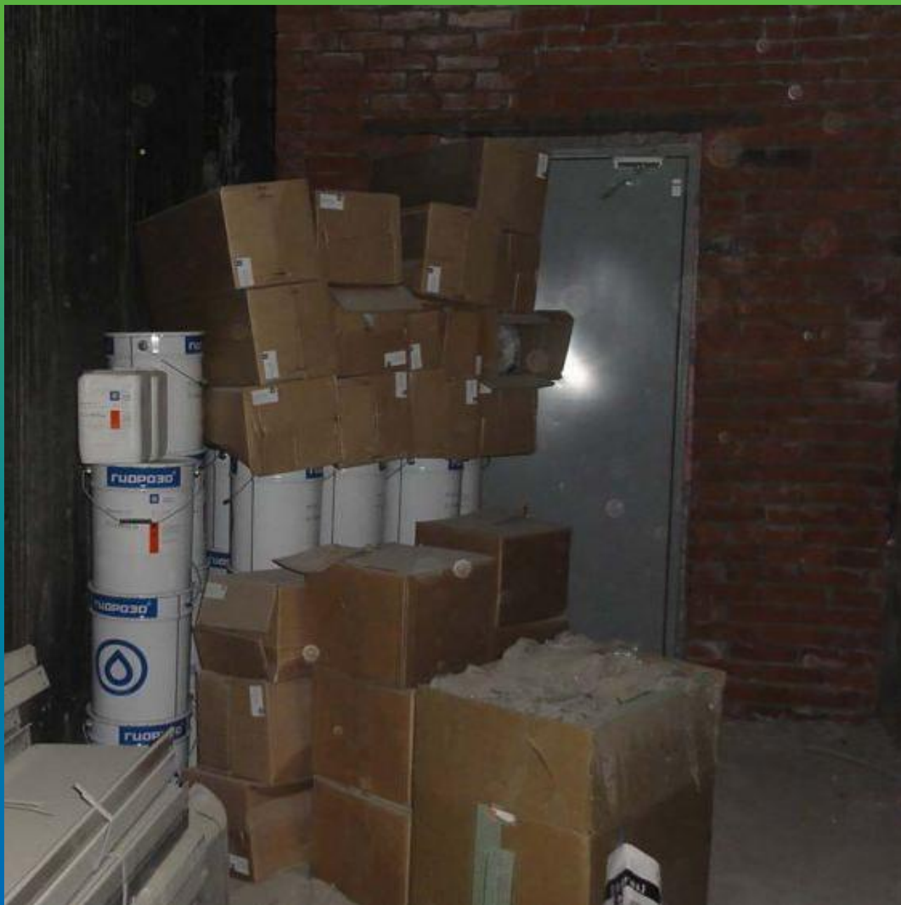
Материалы Гидрозо на объекте
