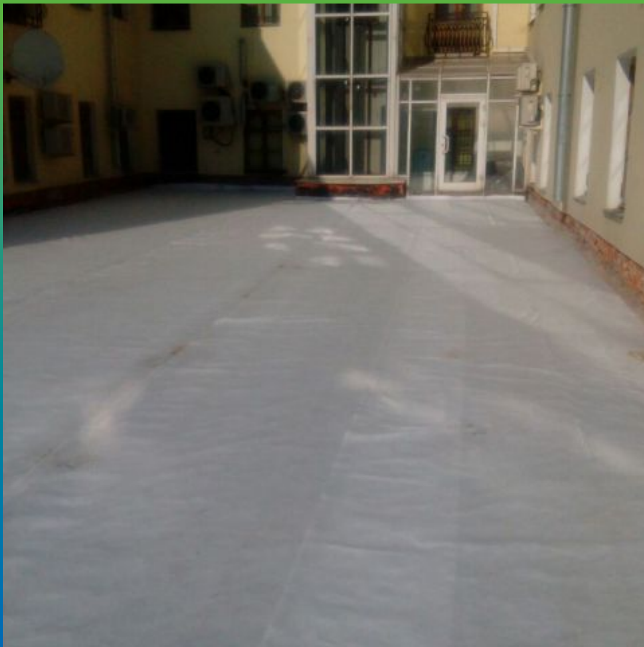
Уложенный защитный слой из геотекстиля перед монтажом мембраны
