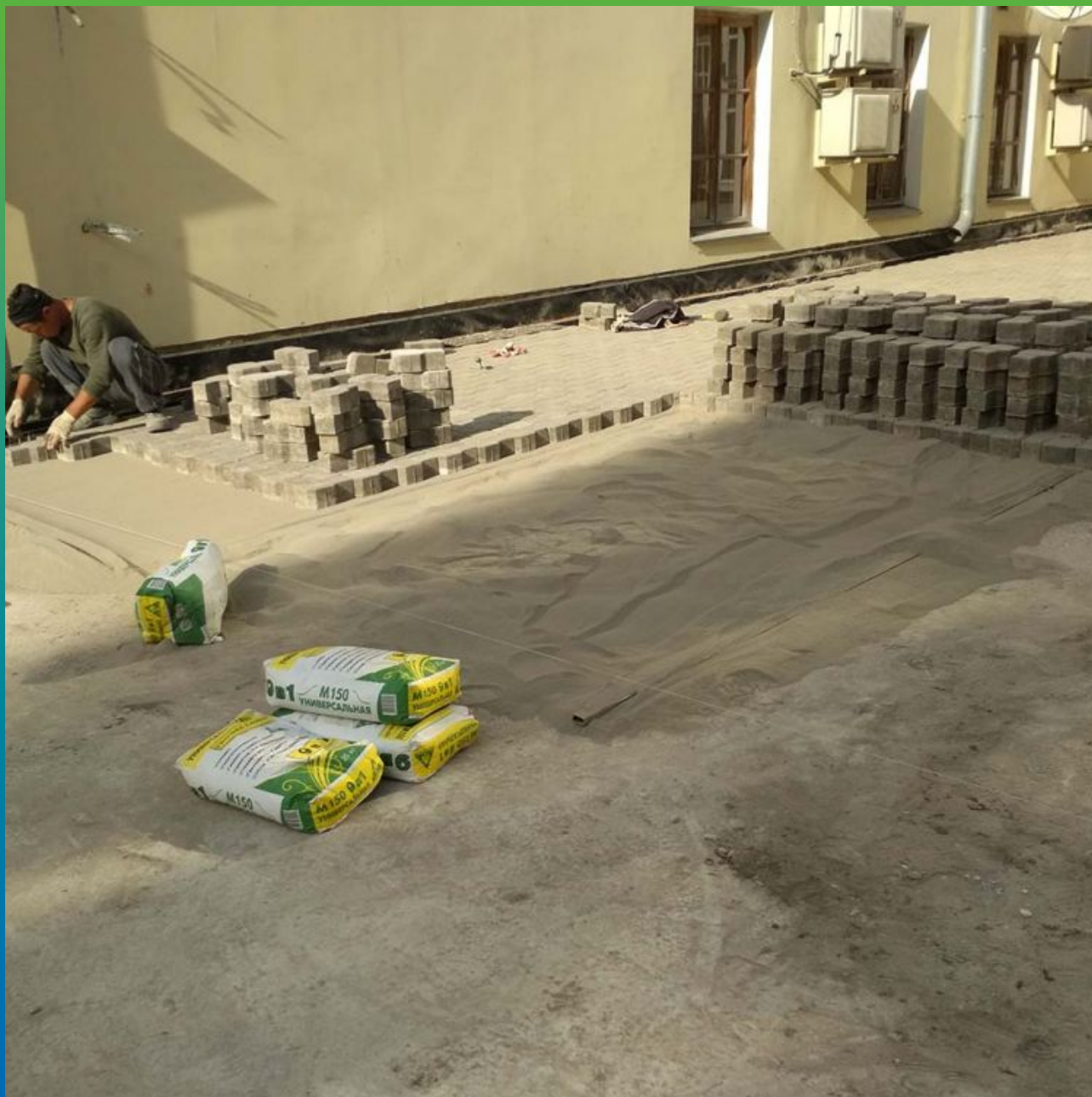
Финишные работы по укладке новой тротуарной плитки, поверх ЭПДМ мембраны Преласта СТ
