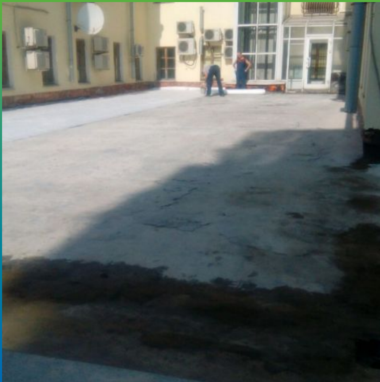
Укладка защитного слоя из геотекстиля перед монтажом мембраны
