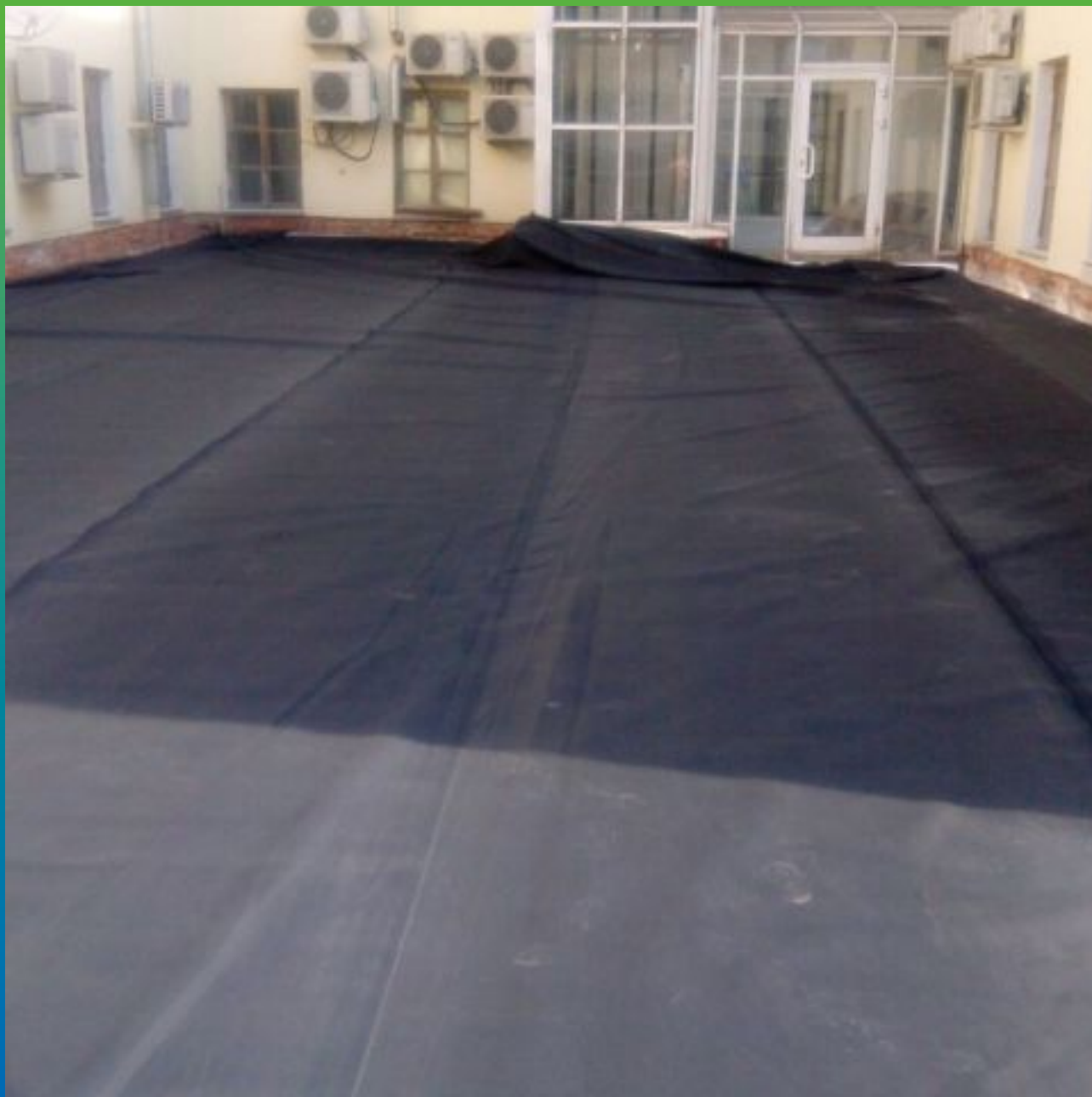
Укладка гидроизоляционной мембраны Преласты СТ
