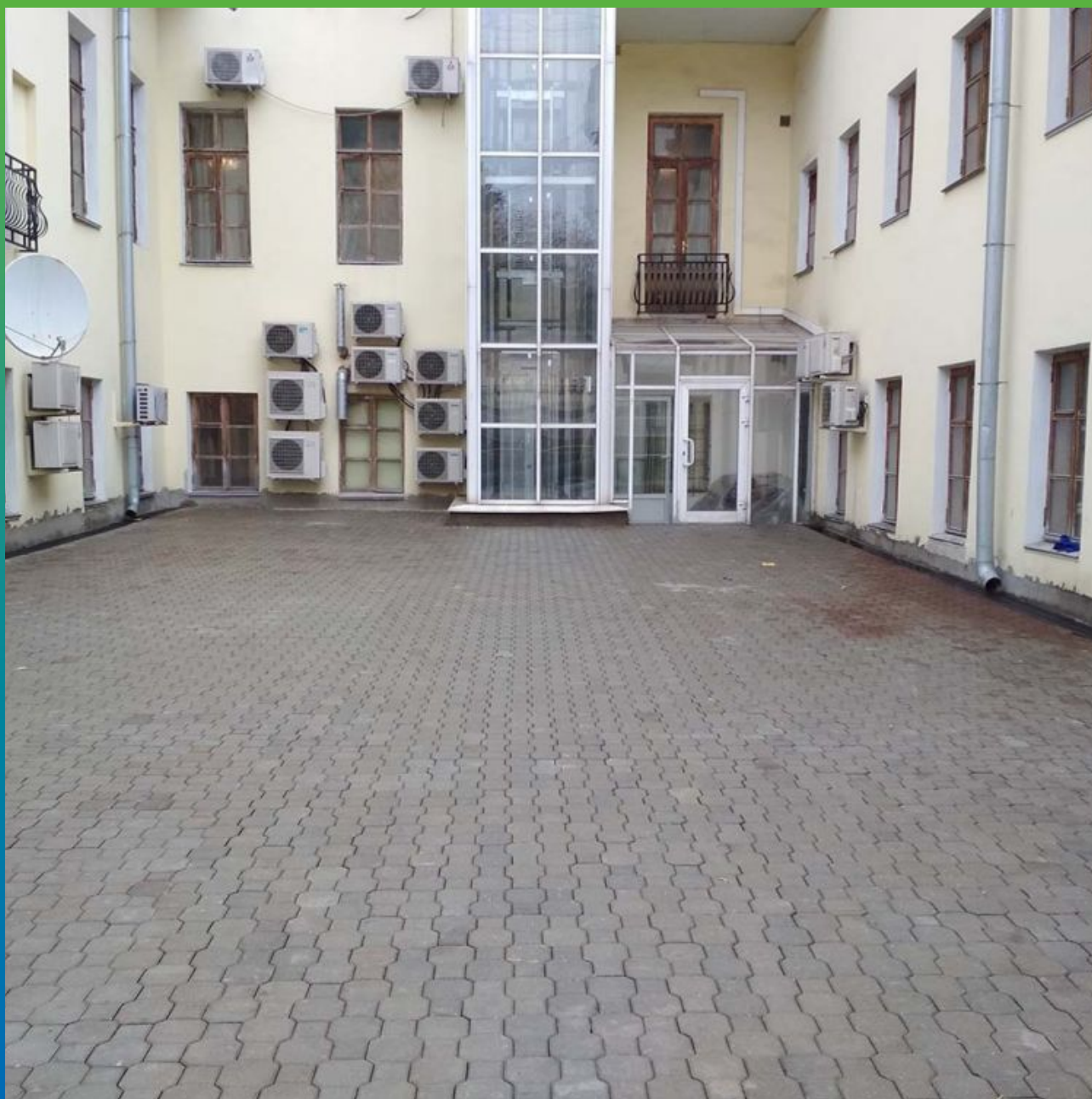
1-ый участок внутреннего двора, стилобатная часть здания
