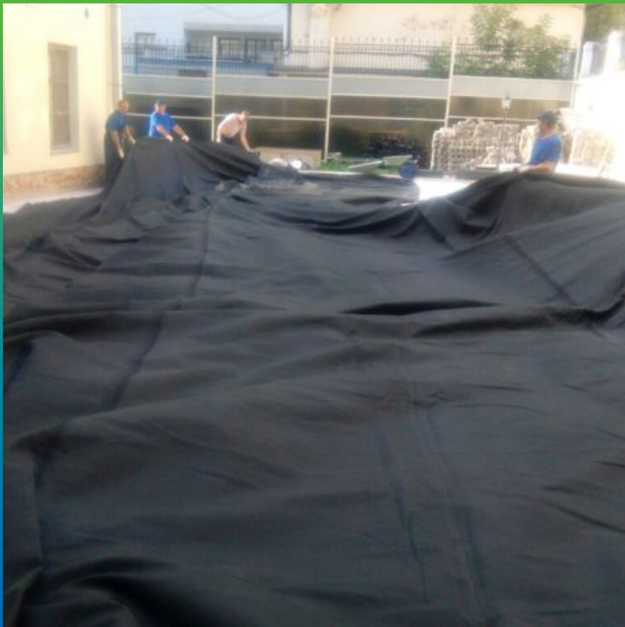
Укладка гидроизоляционной мембраны Преласты СТ
