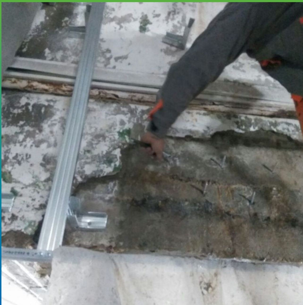
Монтаж пакеров БМ 1099
