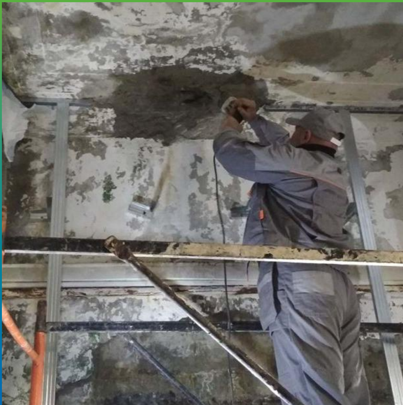
Подготовка основания, перед началом инъекционных работ
