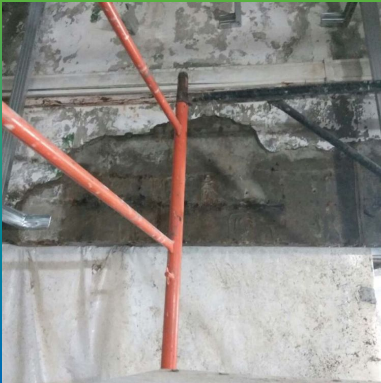
Внешний вид объекта до начала работ
