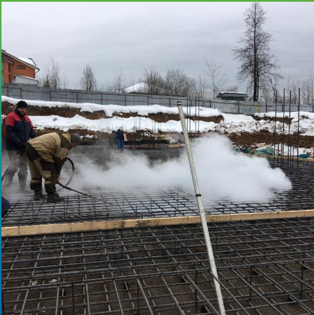
Очистка бетонной подготовки перед просыпкой гидроизоляции Стармекс Сил
