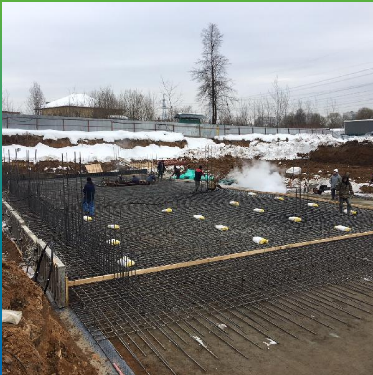
Равномерное распределение мешков Стармекс Сил по захватке бетонирования
