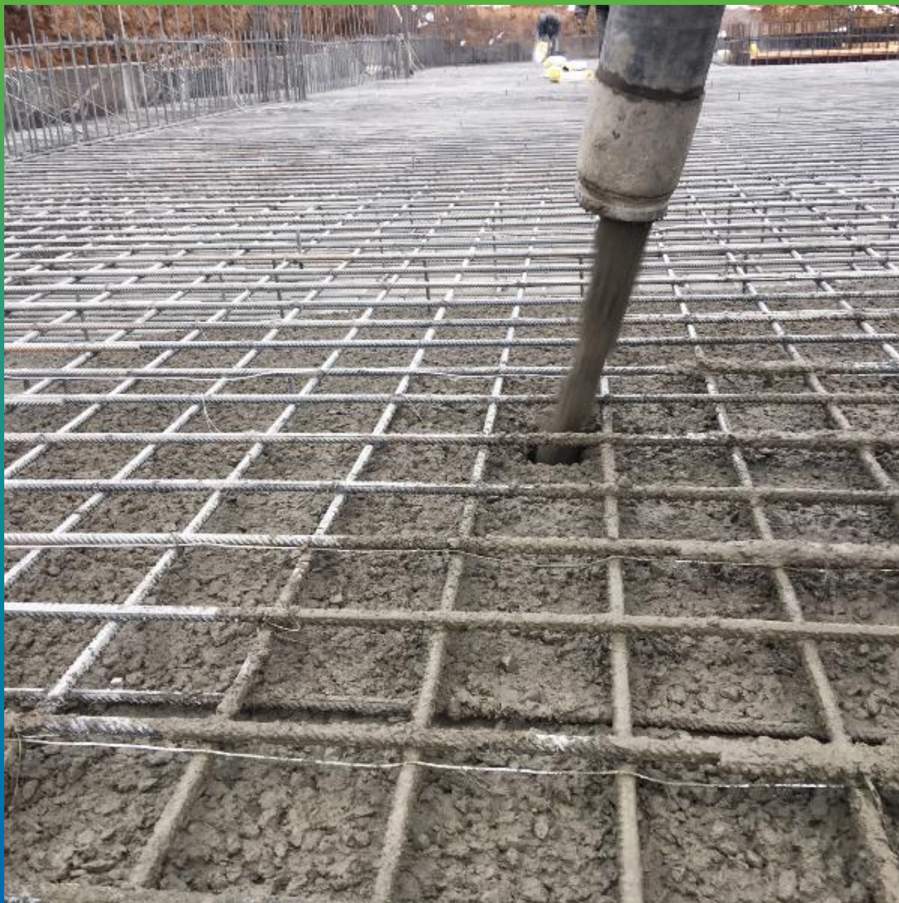
Заливка фундаментной плиты
