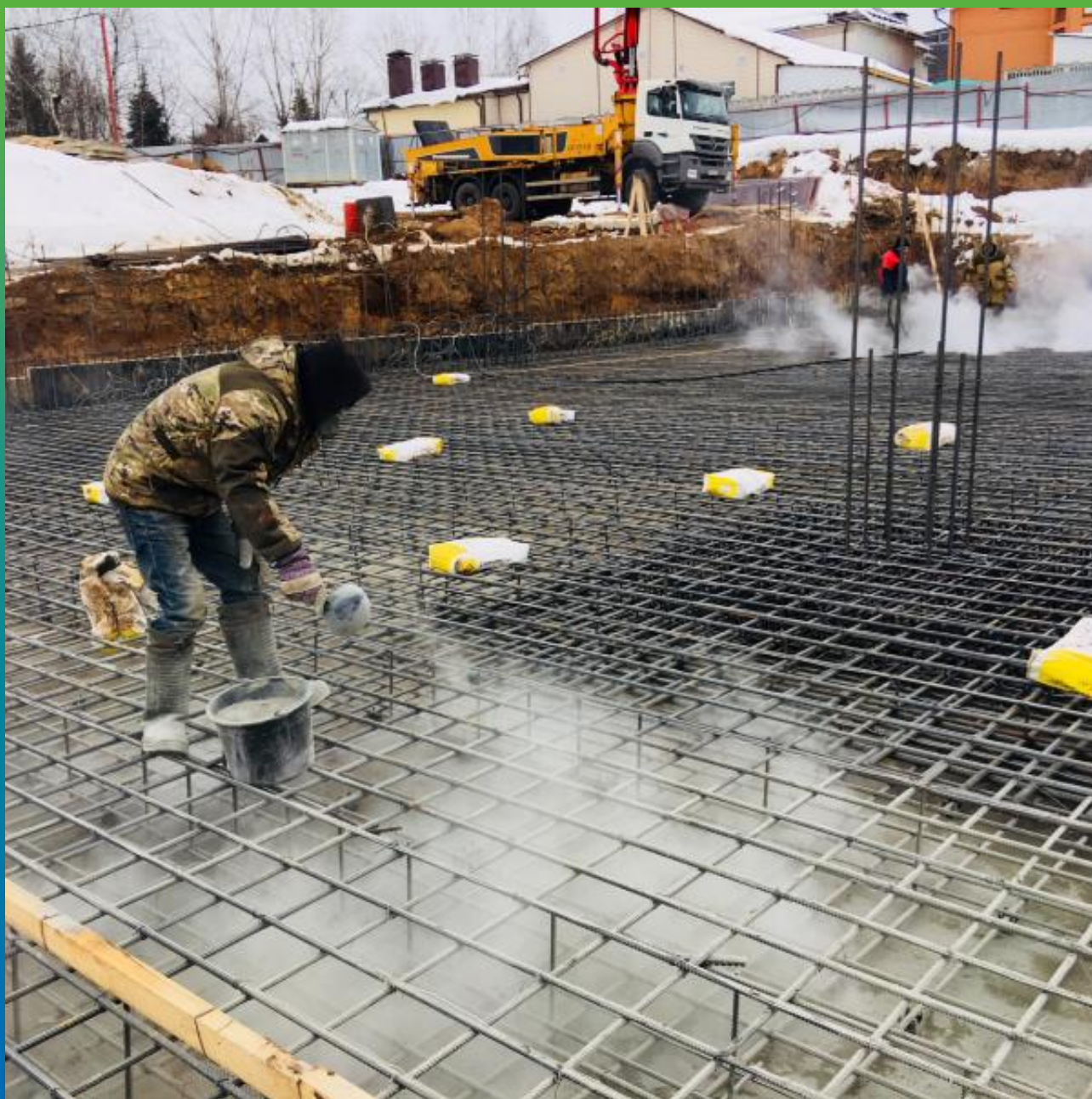
Просыпка материала Стармекс Сил по бетонной подготовке
