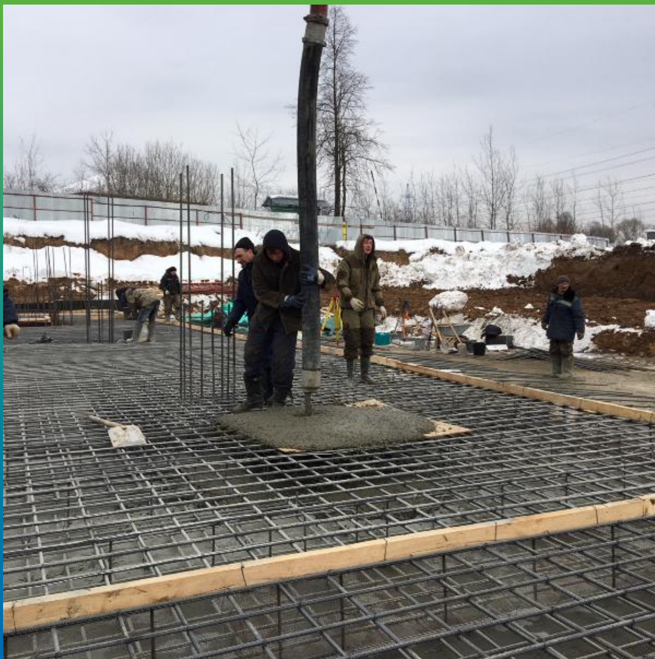
Начало бетонирования
