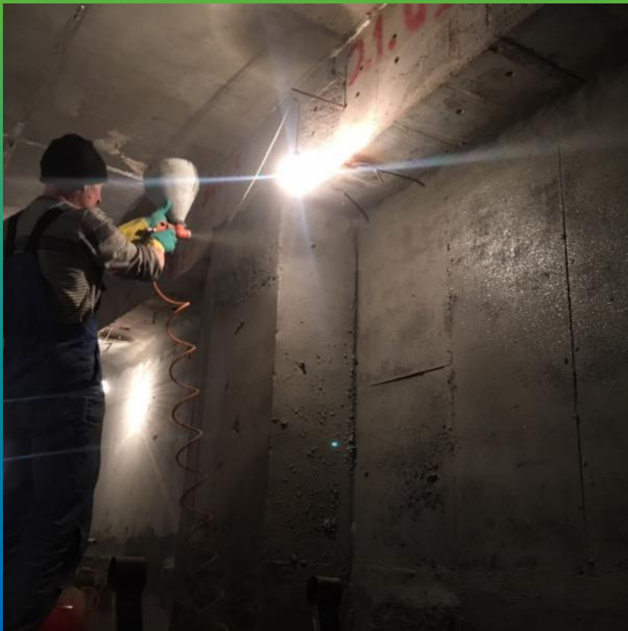
Воздушное нанесение гидроизоляции Стармекс Сил на стены подвала
