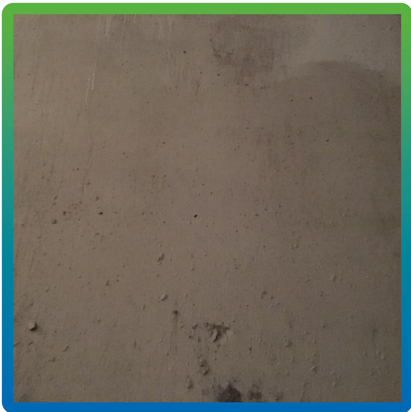
Вид стены после нанесения гидроизоляционного состава Стармекс Сил
