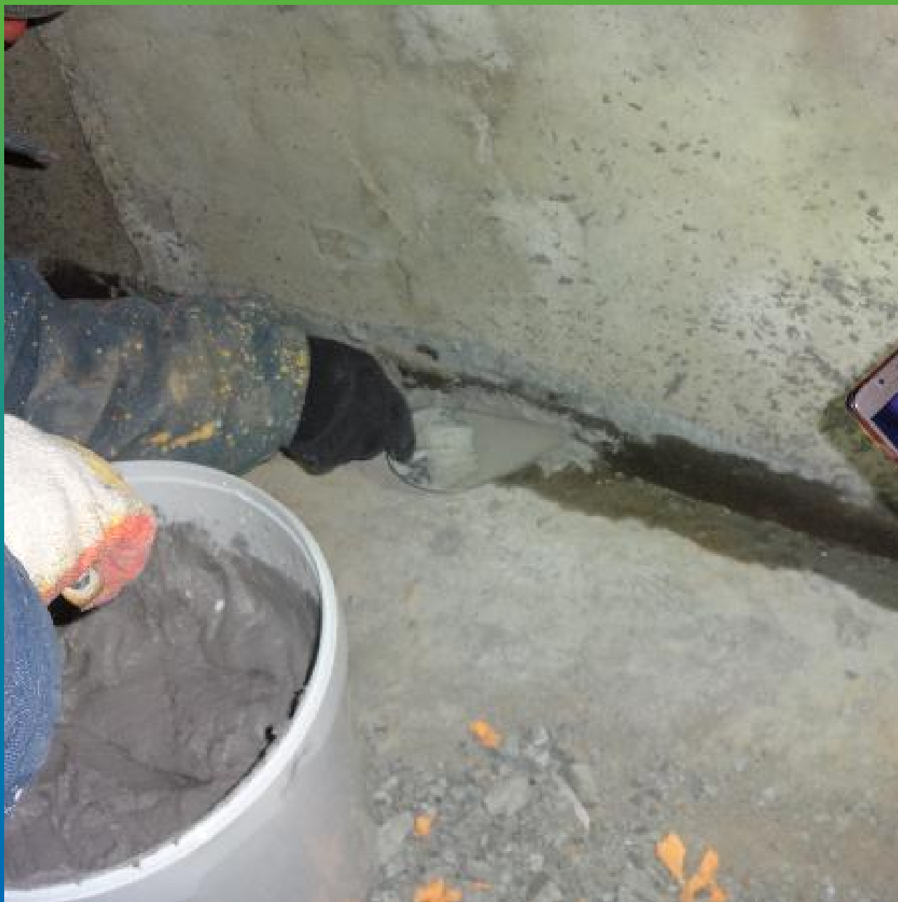
Нанесение полимерцементного герметика в увлажненный деформационный шов
