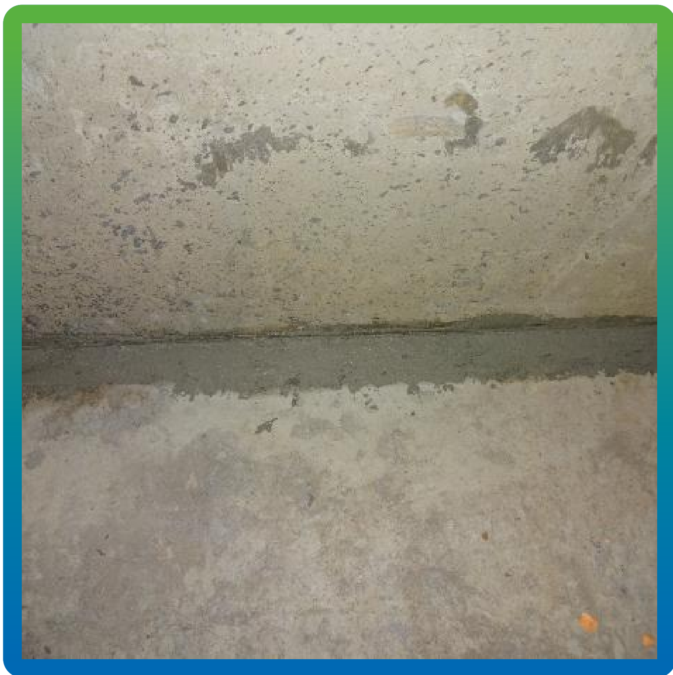
Вид объекта после производства работ по гидроизоляции
