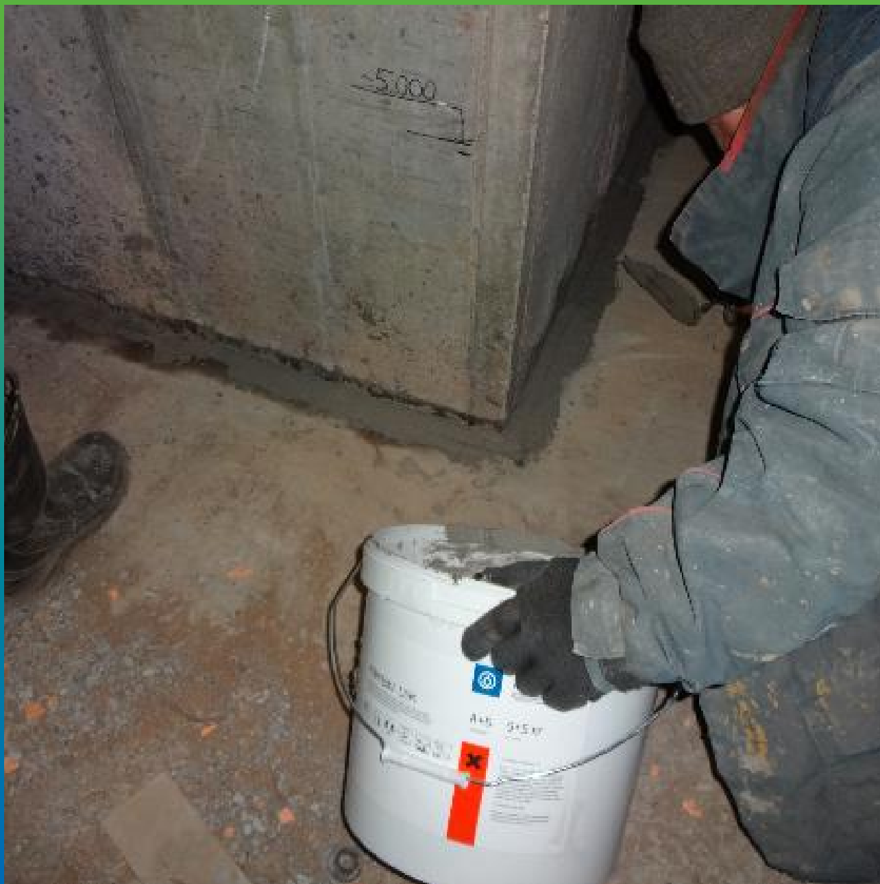
Процесс гидроизоляции швов
