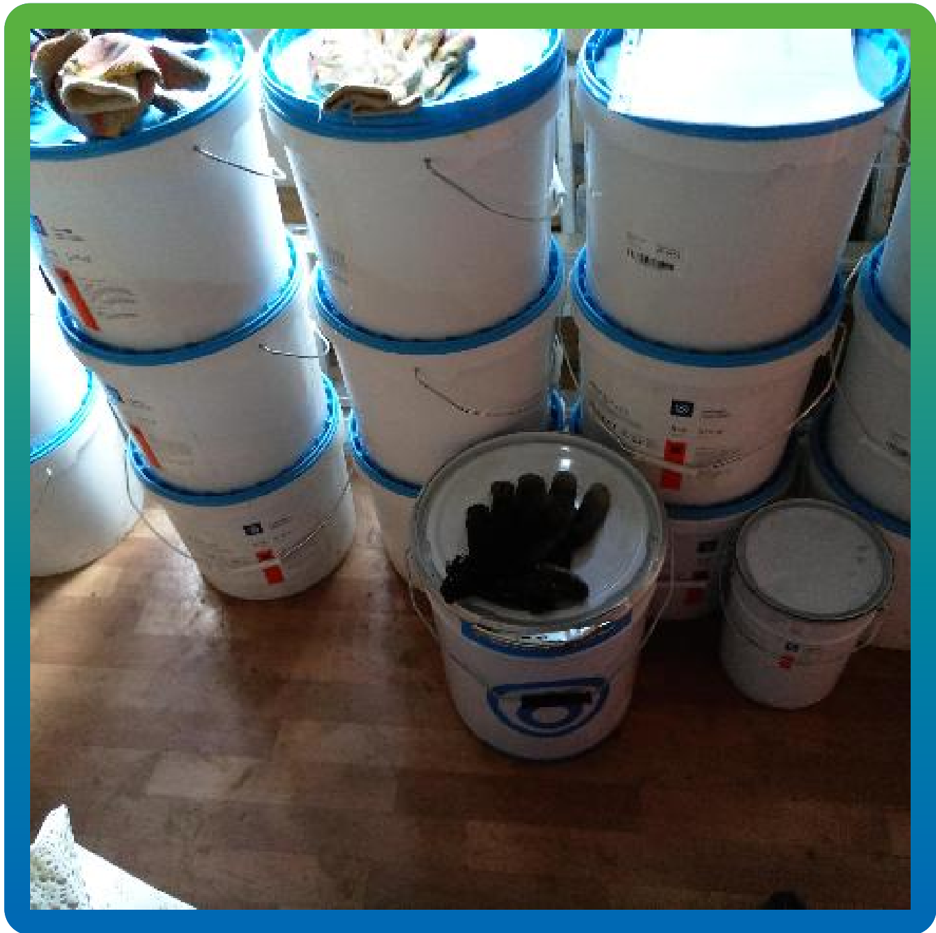
Материалы Гидрозо на объекте
