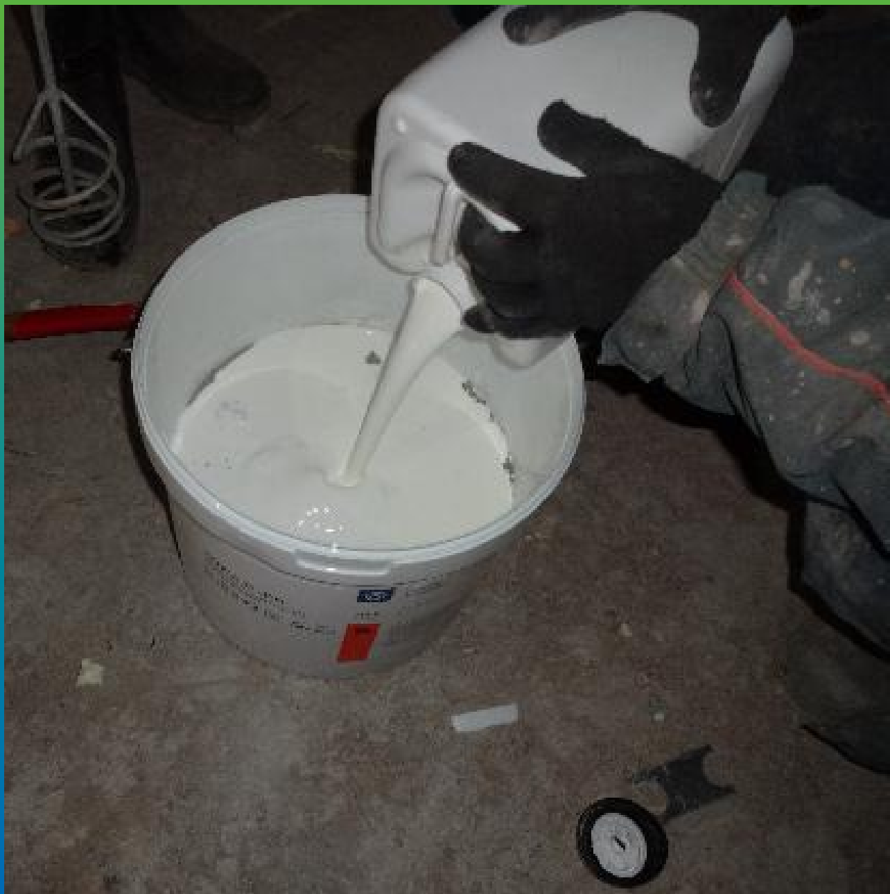
Затворение компонентов А+Б полимерцементного герметика Манодил Цем
