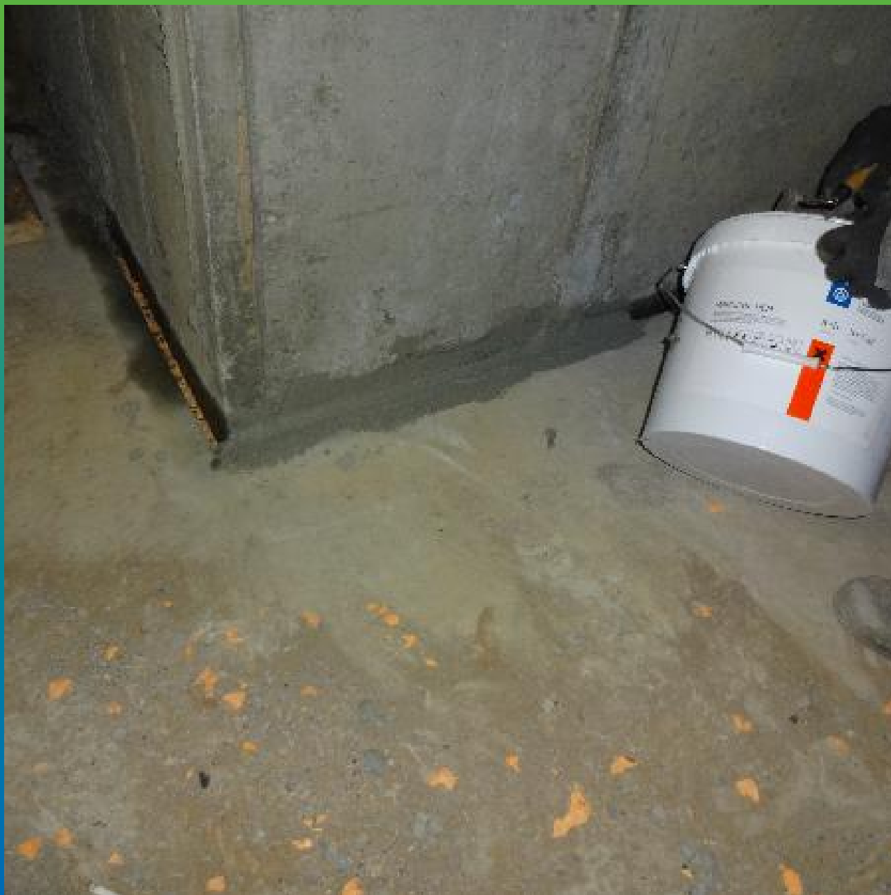
Процесс гидроизоляции швов
