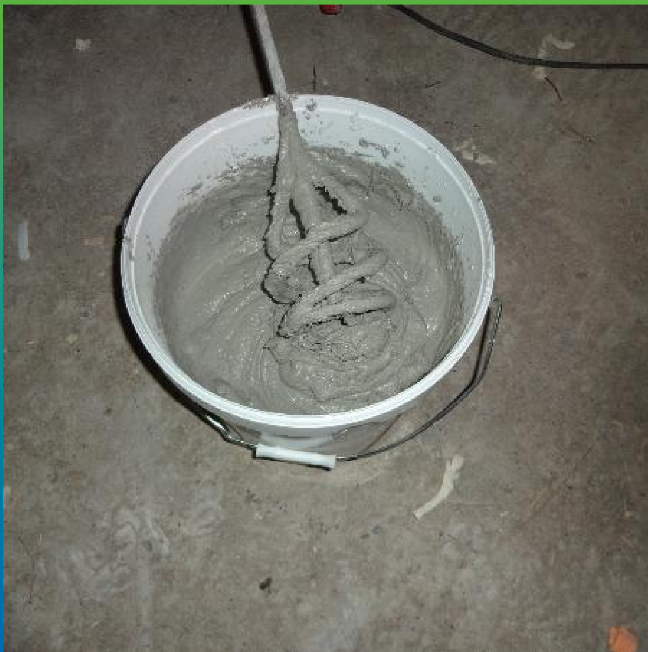
Готовый вид герметика Манодил Цем перед гидроизоляцией деформационных швов
