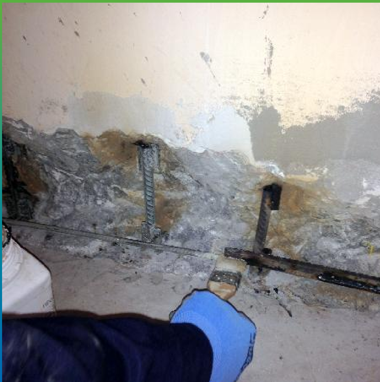
Обработка арматуры защитным составом Маногард 133 Фер
