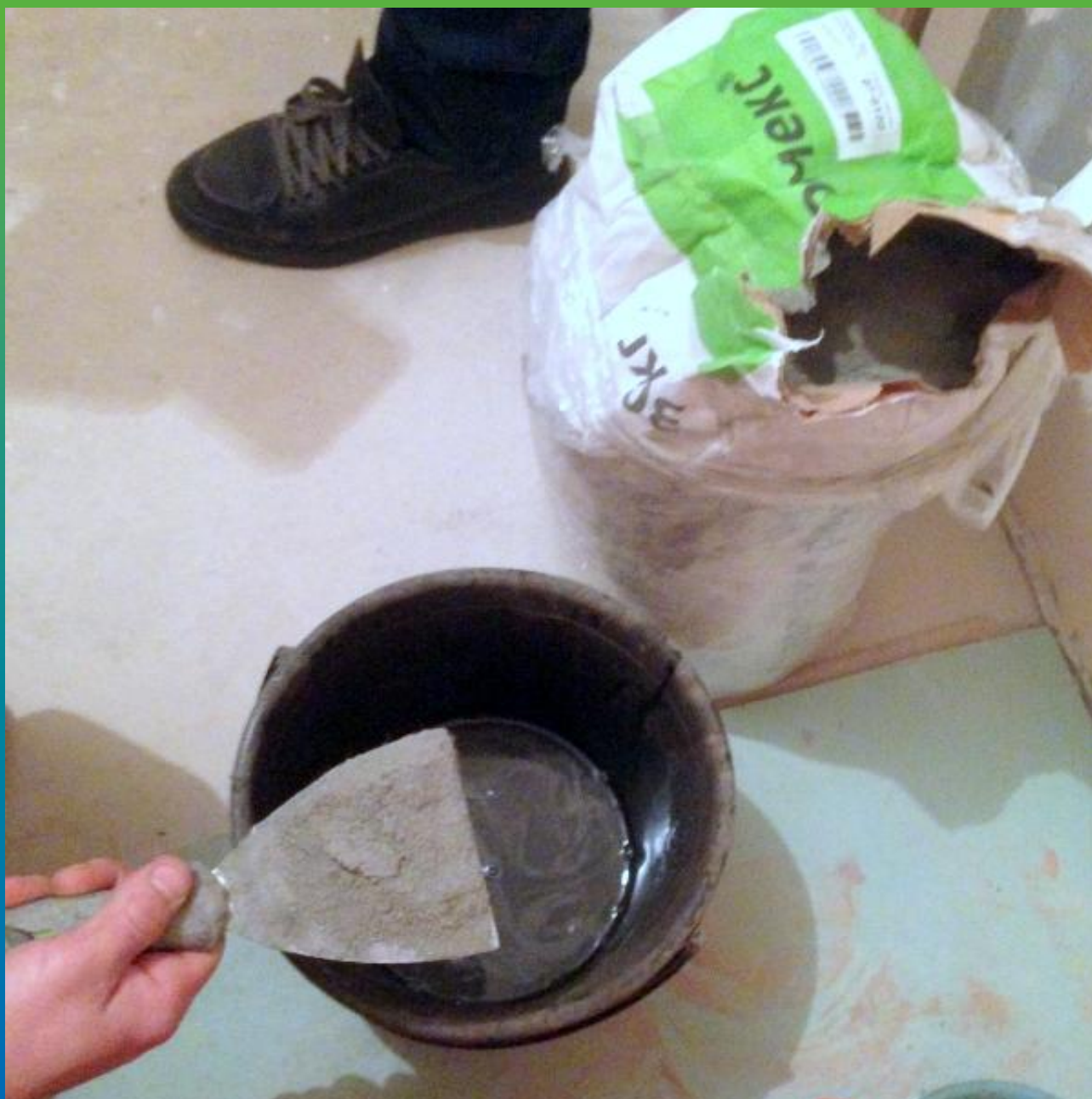
Приготовление грунтовочного состава из Стармекс РМ3 + Вода доведенного до жидкой консистенции
