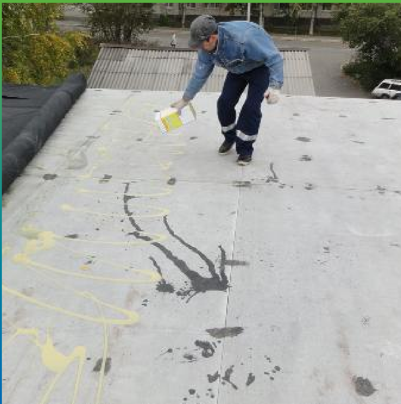
Нанесение адгезива П400 для приклейки ЭПДМ мембраны к основанию.
