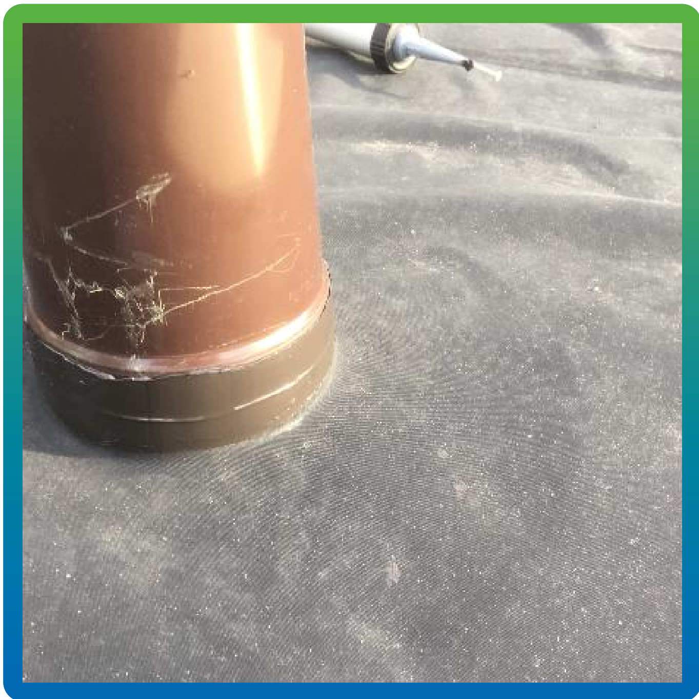
Вид загерметизированного аэратора, при помощи герметика Витрафин Бонд Ф.
