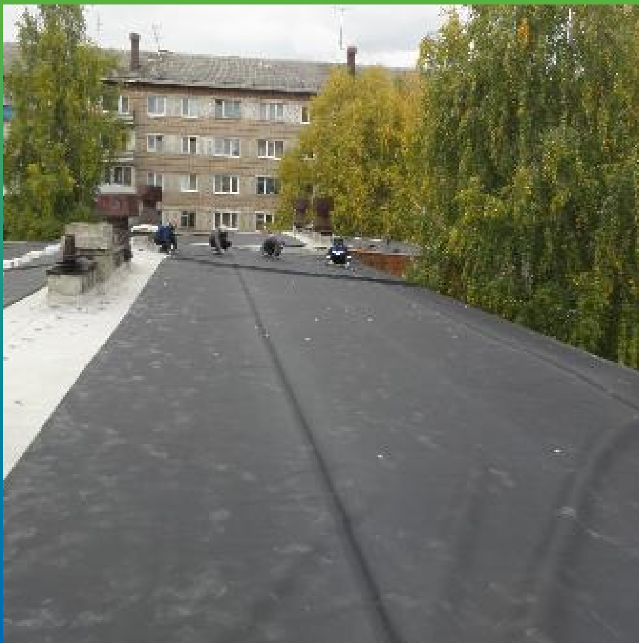
Укладка ЭПДМ мембраны Прелести СТ 1.2мм
