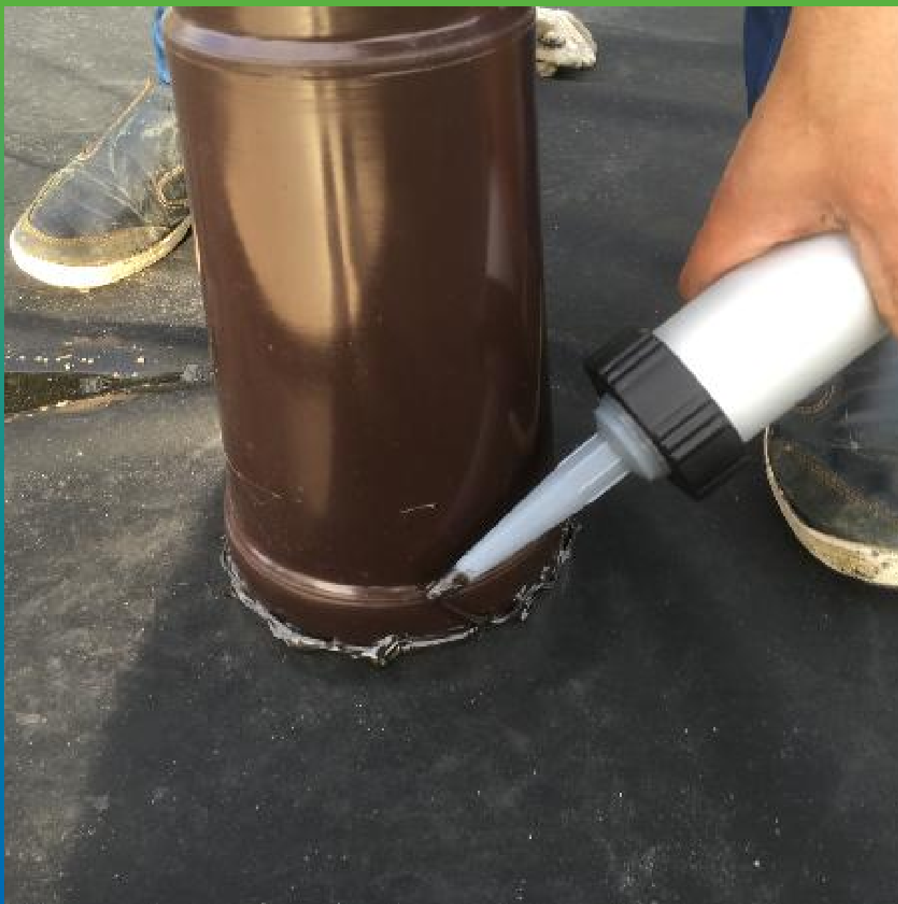
Герметизация аэратора с помощью герметика Витрафин Бонд Ф.
