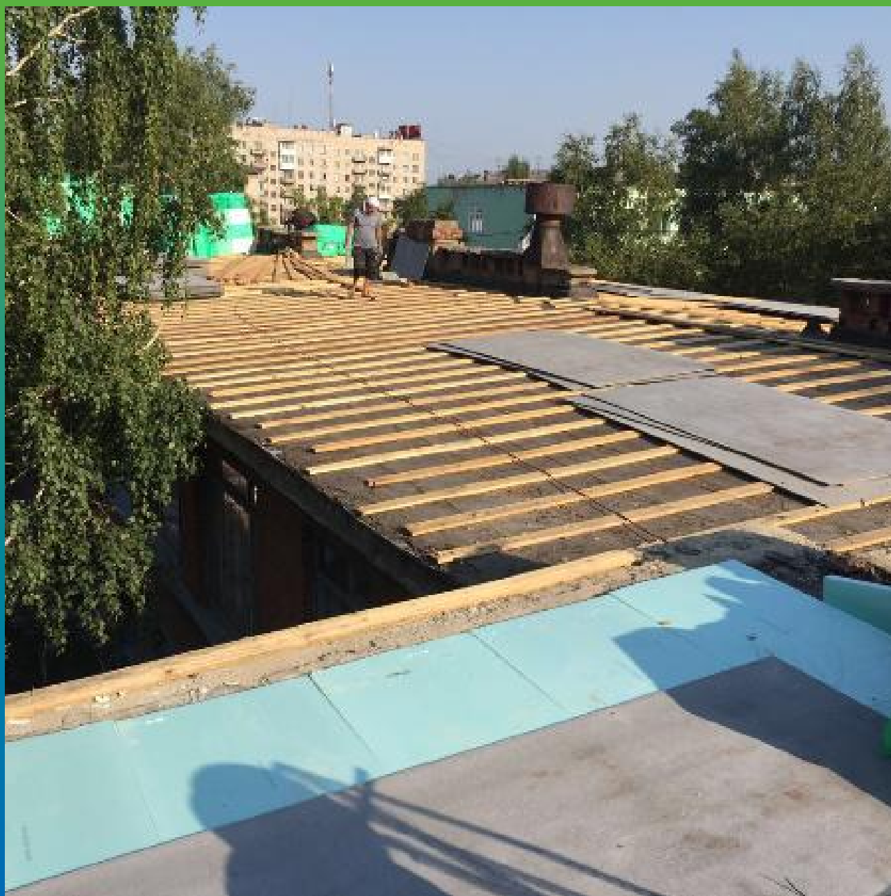
Устройство основания кровли
