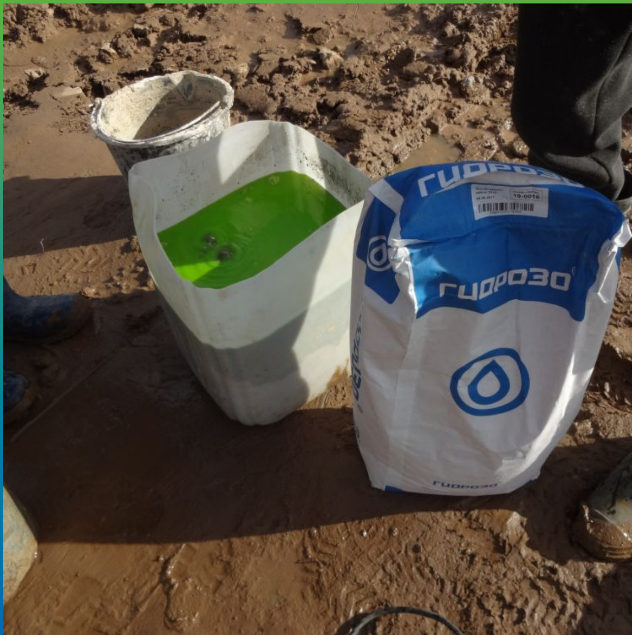
Реолен Адмикс перед заливкой в миксер
