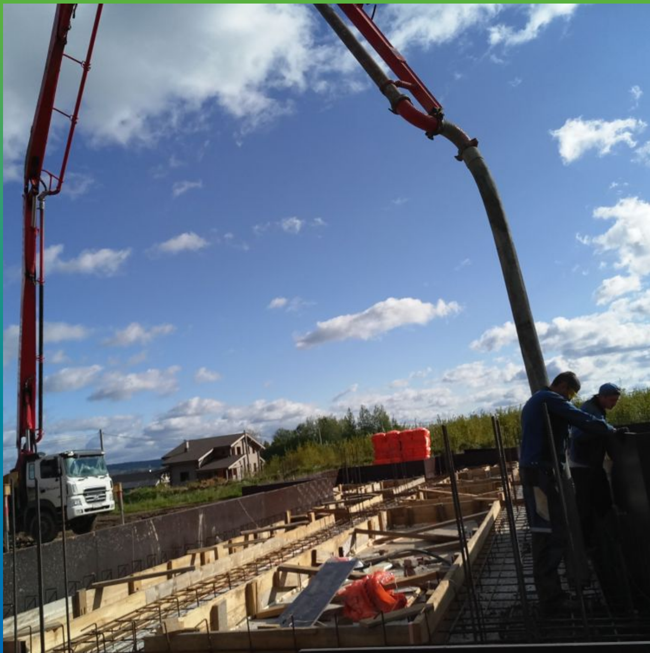
Подача миксером бетонной смеси с Реолен Адмикс
