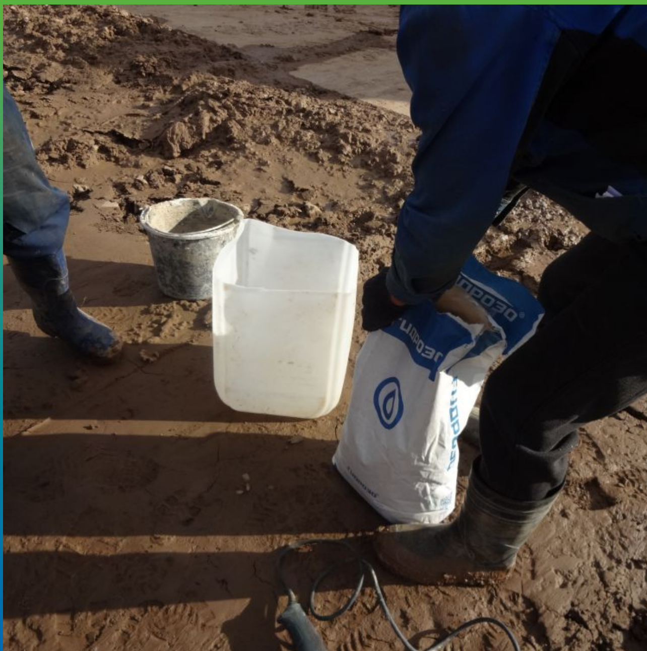
Затворение с водой добавки Реолен Адмикс
