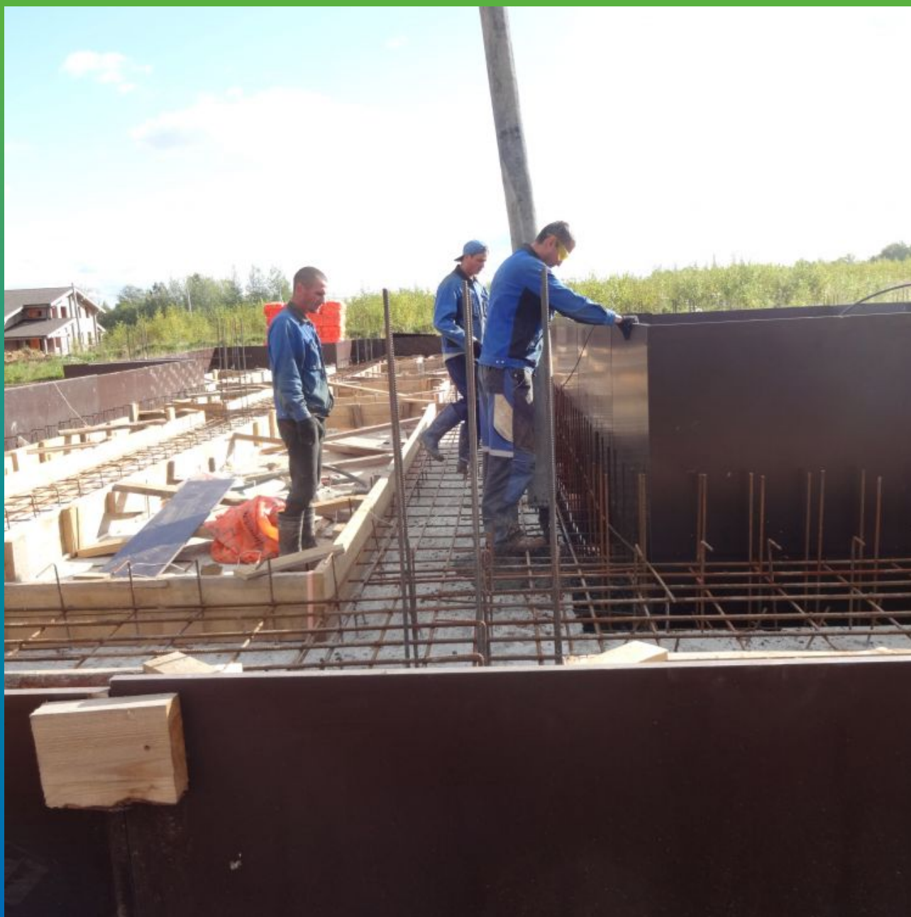
Подача миксером бетонной смеси с Реолен Адмикс
