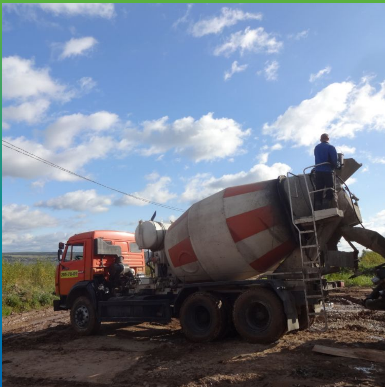
Заливка Реолен Адмикс в миксер
