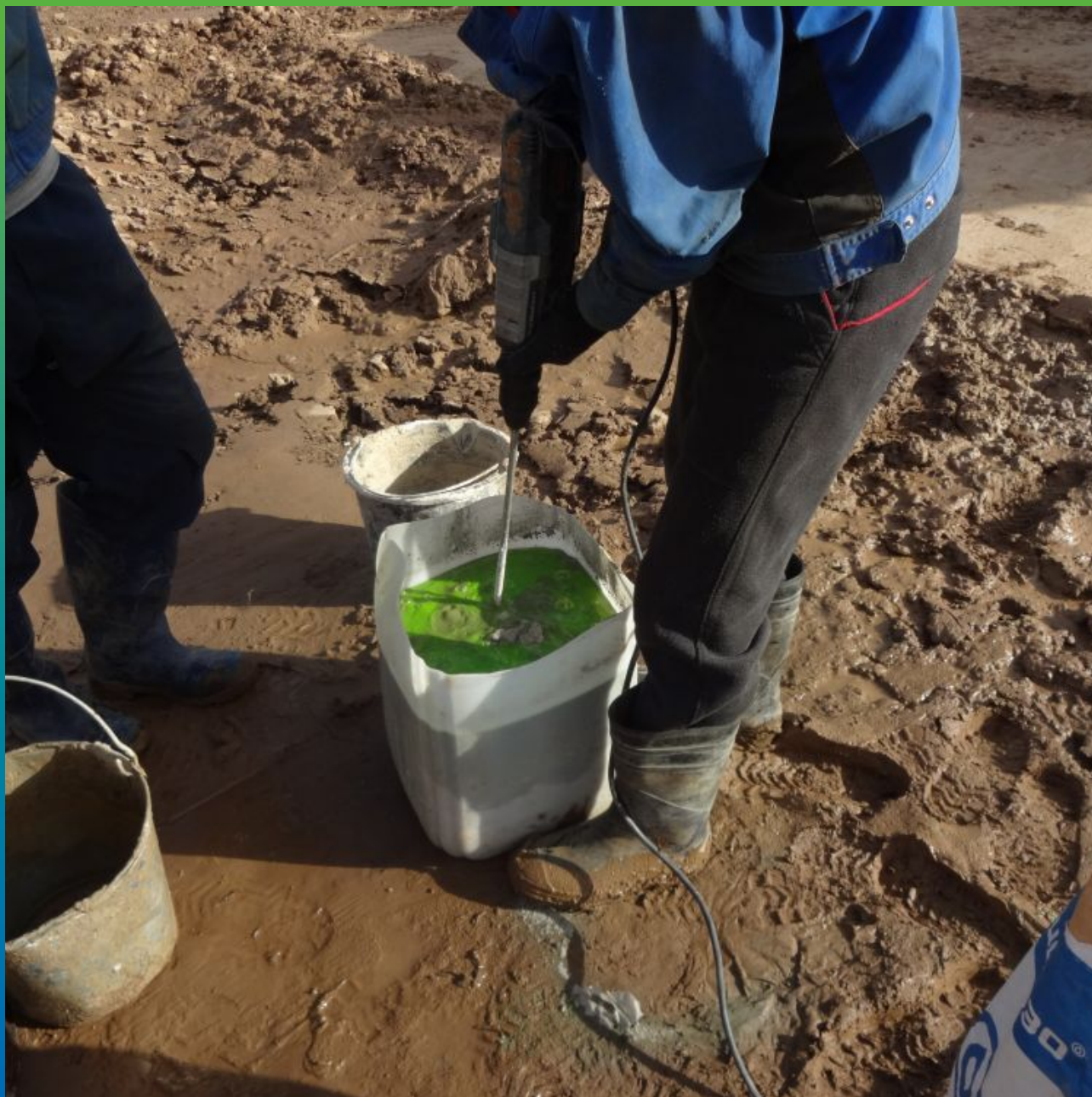
Затворение с водой добавки Реолен Адмикс
