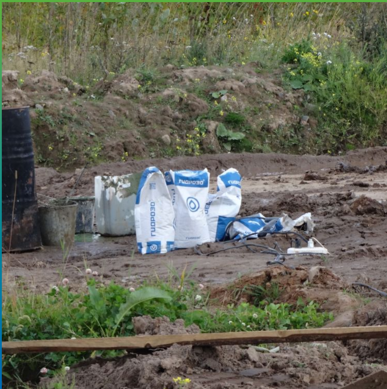
Материалы "Гидрозо" на объекте
