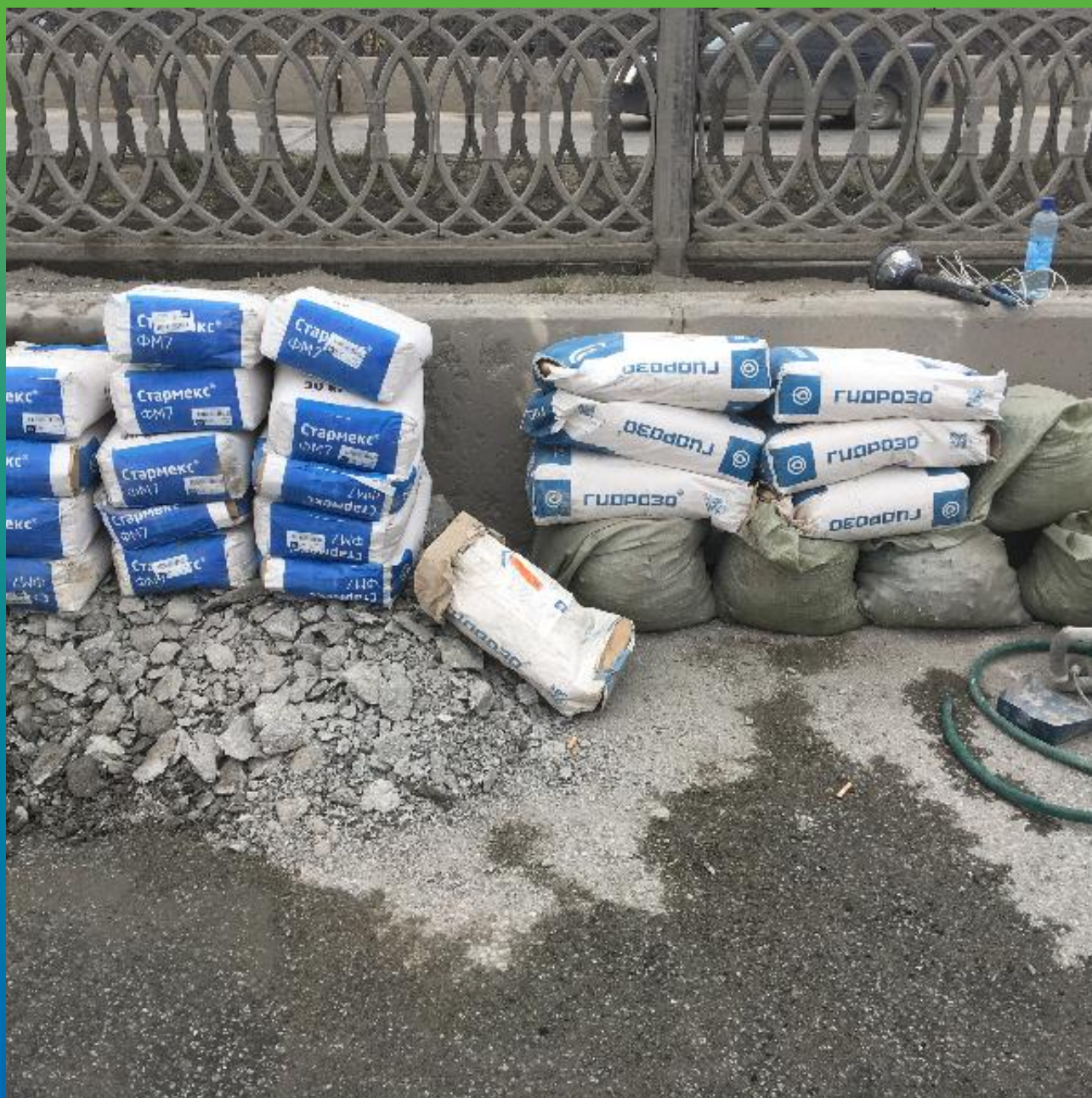
Материалы Гидрозо на объекте
