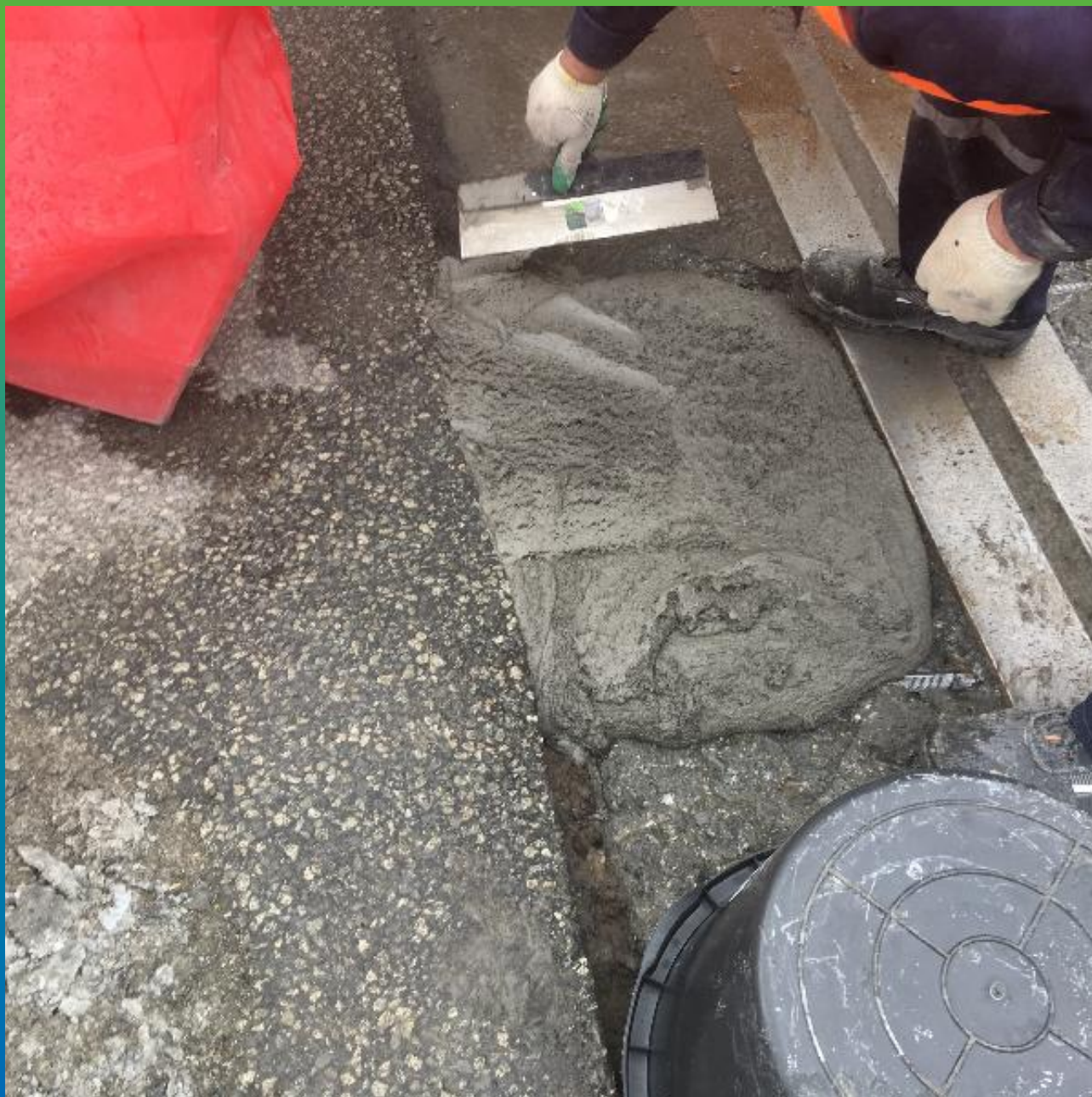
Заливка материала Стармекс ФМ 7
