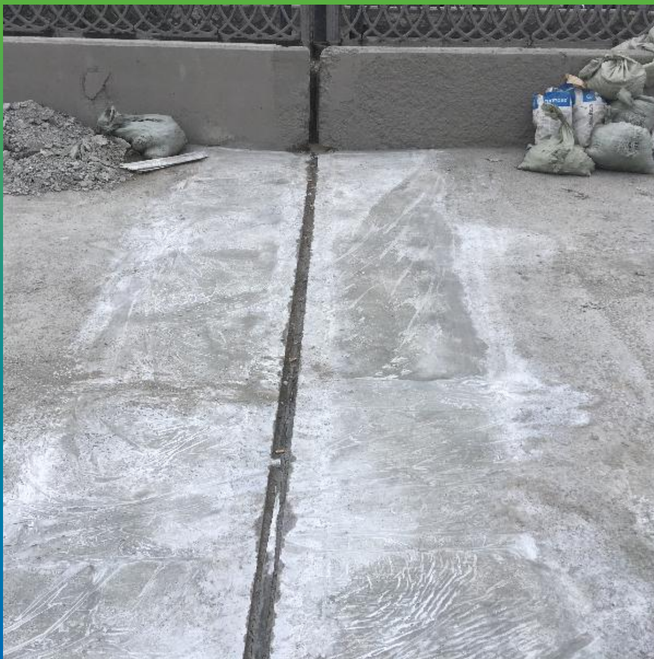
Финальный вид отремонтированного участка
