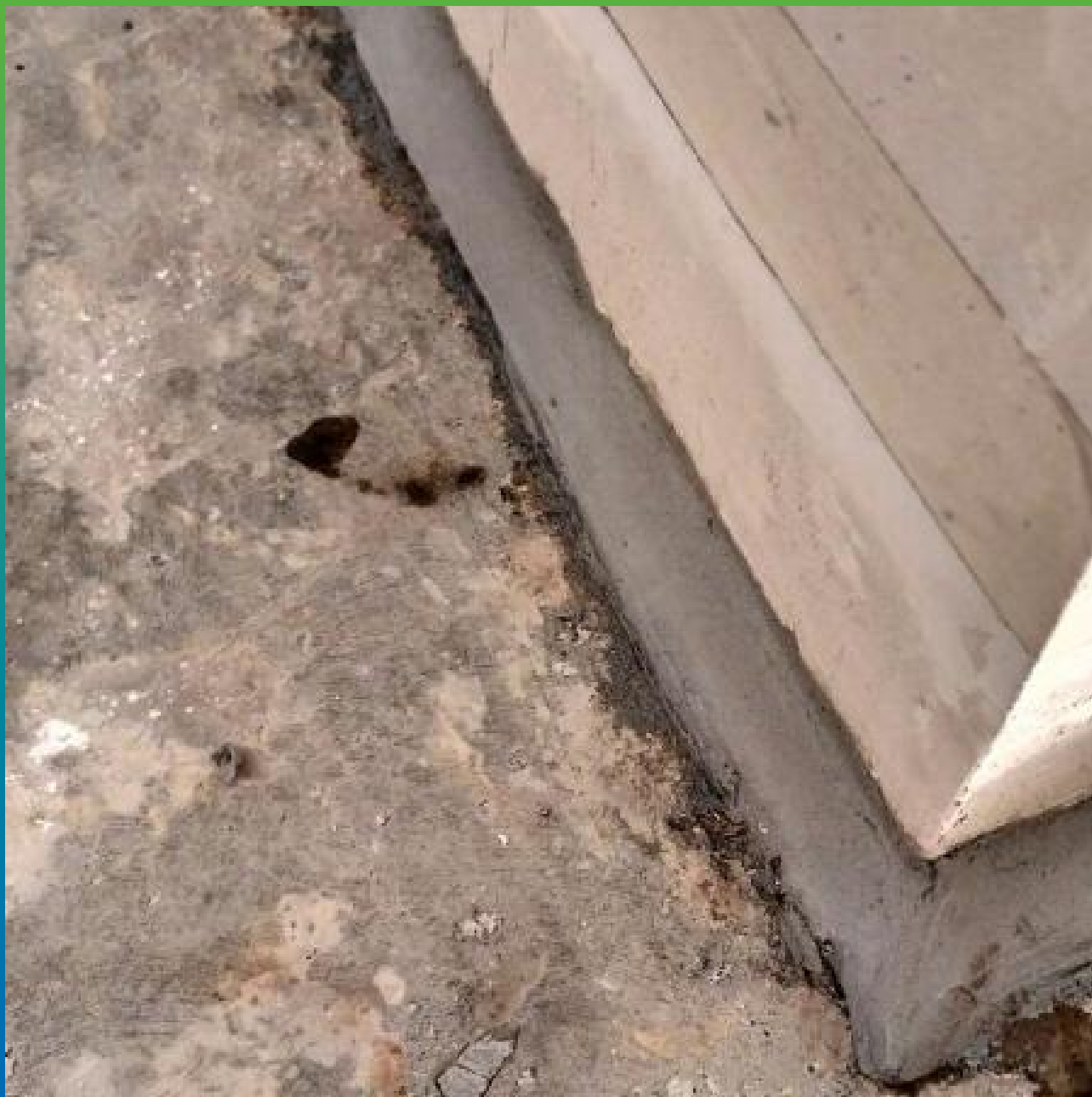
Устройство плинтусов с помощью Манопокс 331
