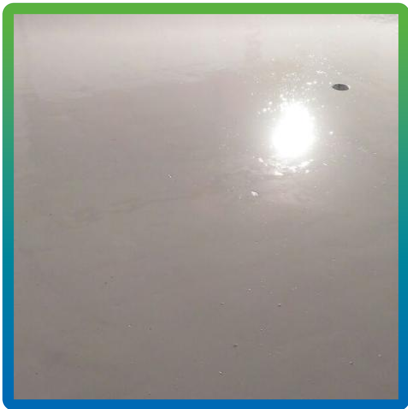
Вид готового покрытия ДенТоп Эп 201
