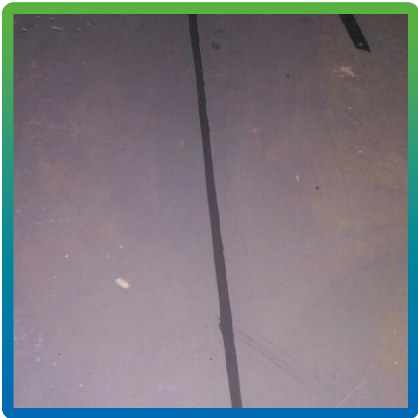
Заполнение швов с помощью герметика Манодил ПУ 696
