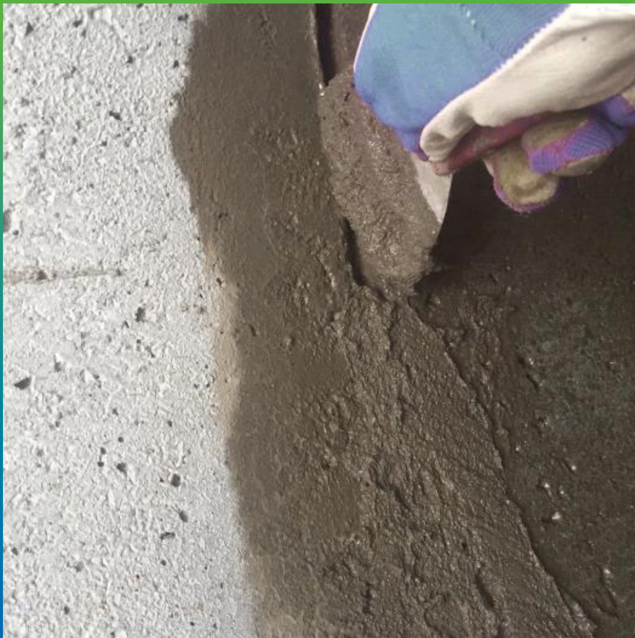
Заделка расшитых трещин составом Стармекс РМЗ
