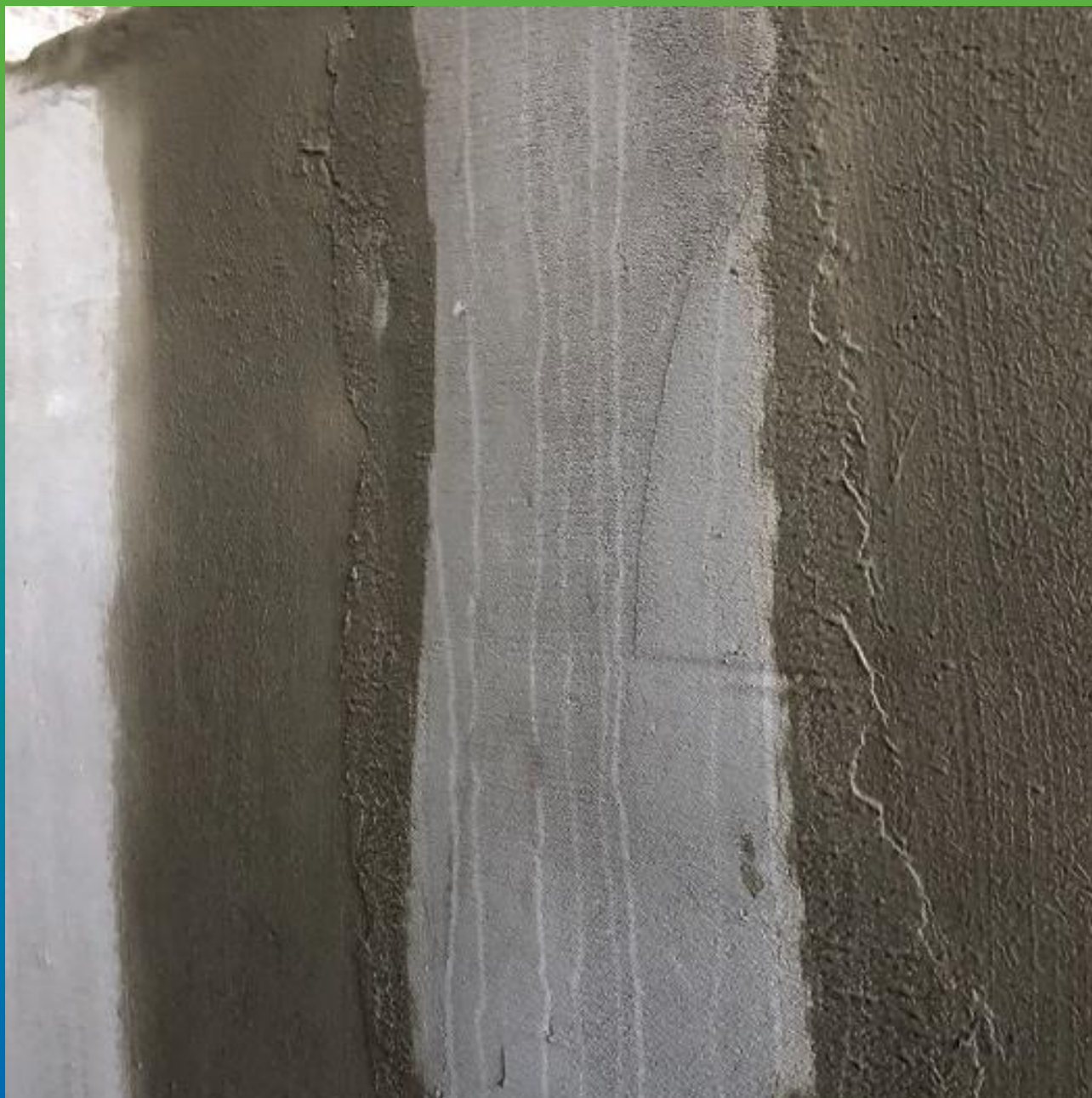
Отремонтированная и гидроизолированная трещина. Частный вид
