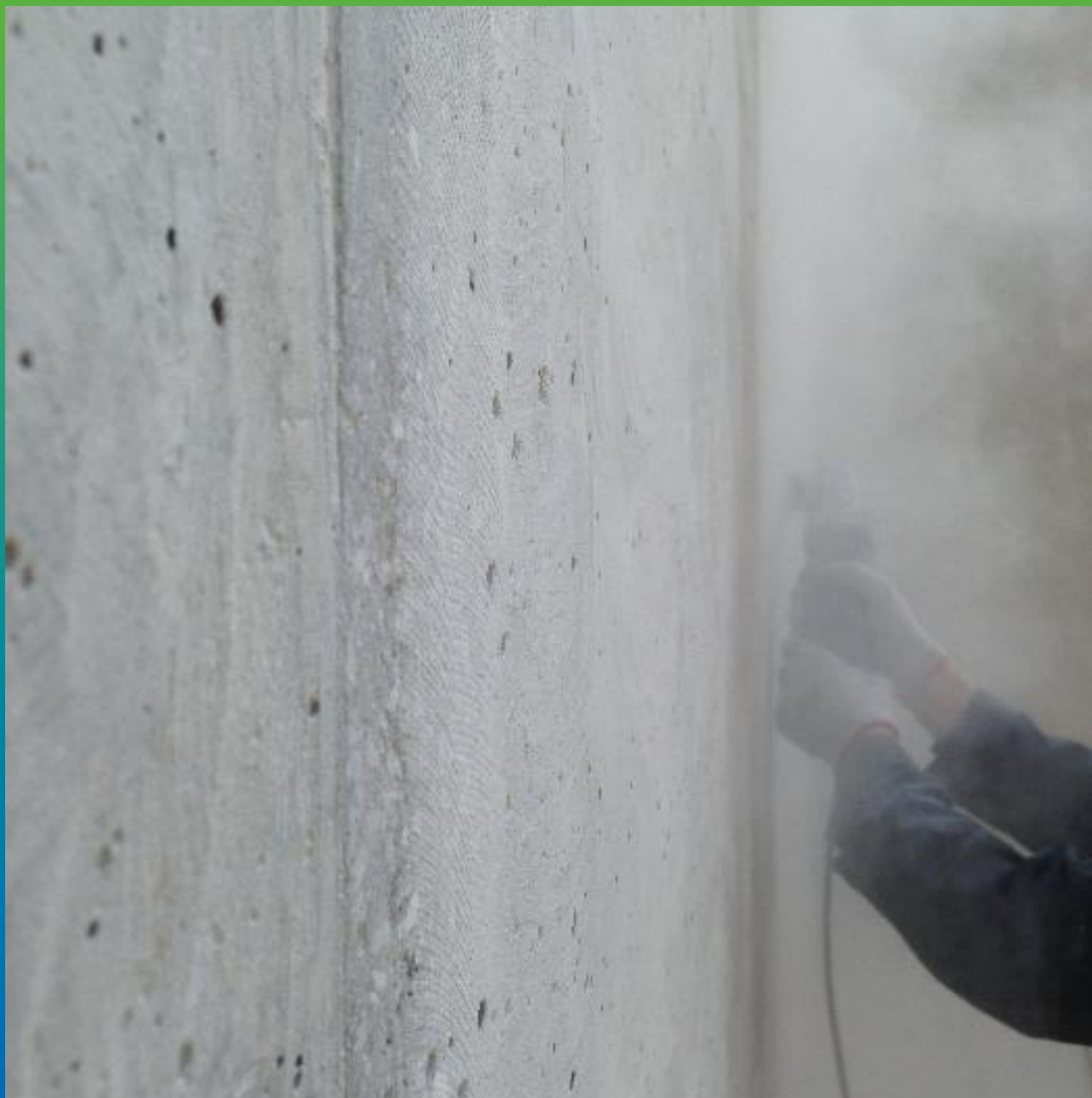
Подготовка поверхности и расшивка трещин
