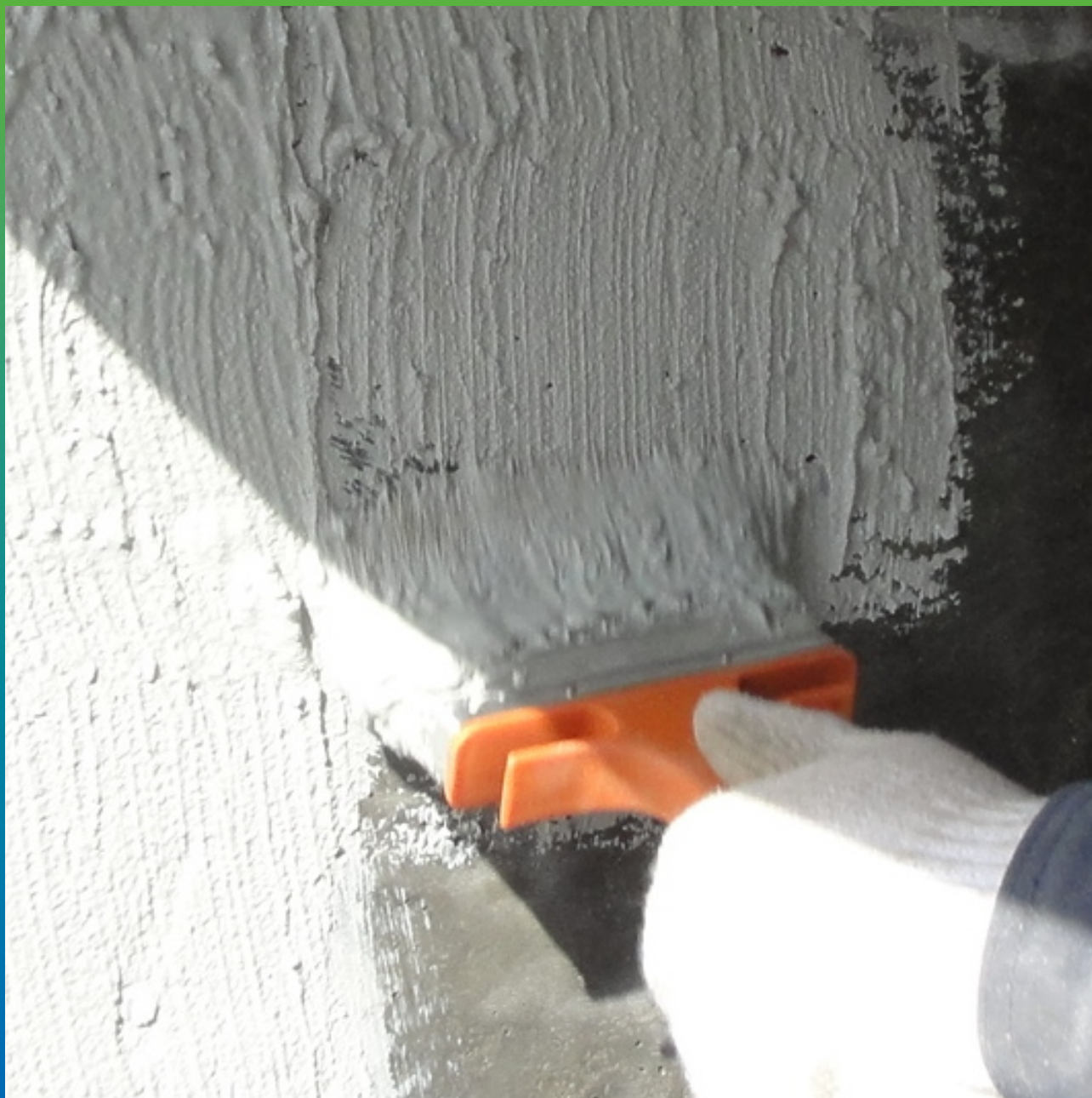
Нанесение полимер-цементной гидроизоляции Стармекс Сил Флекс
