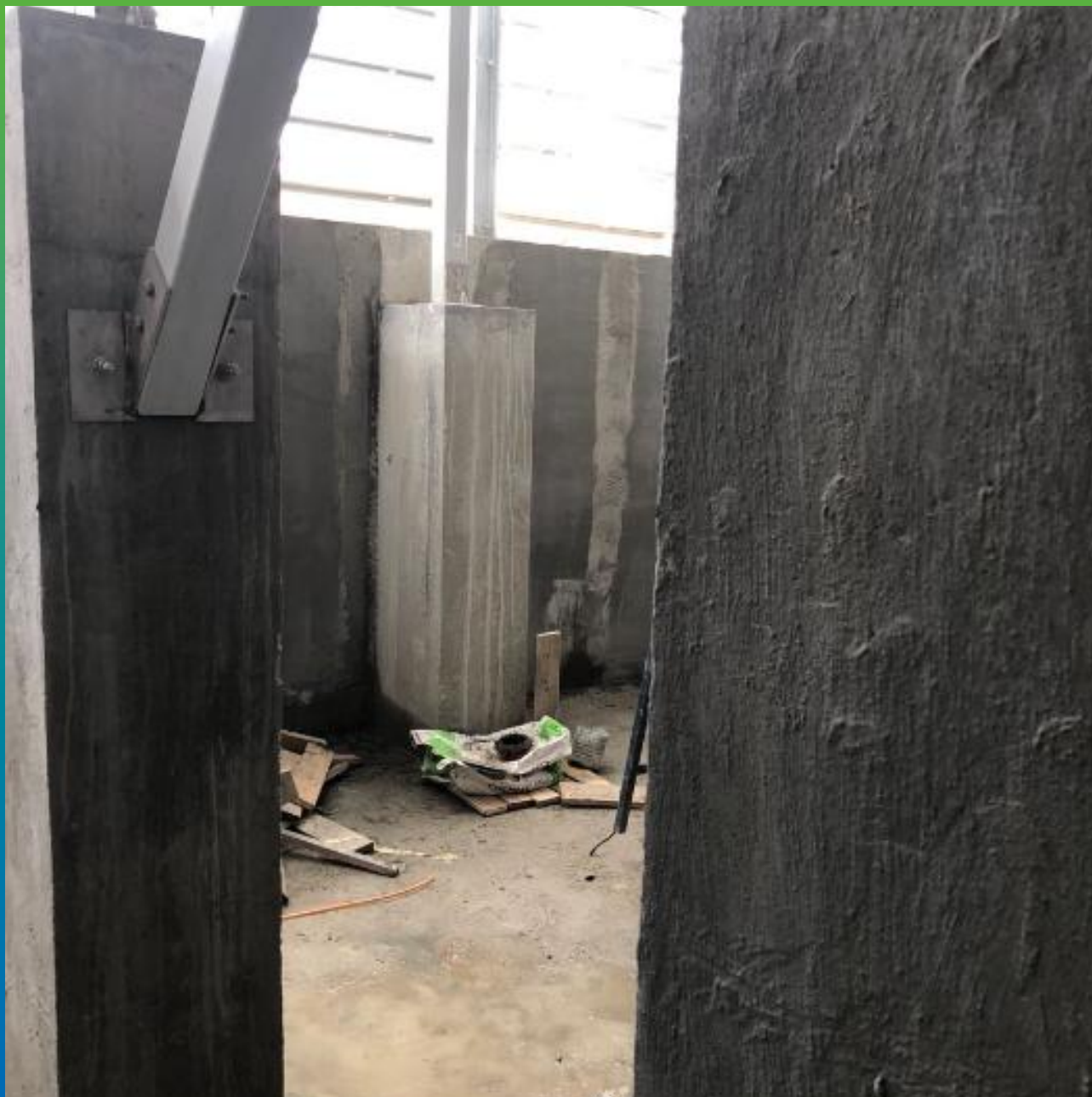
Общий вид ремонтного участка
