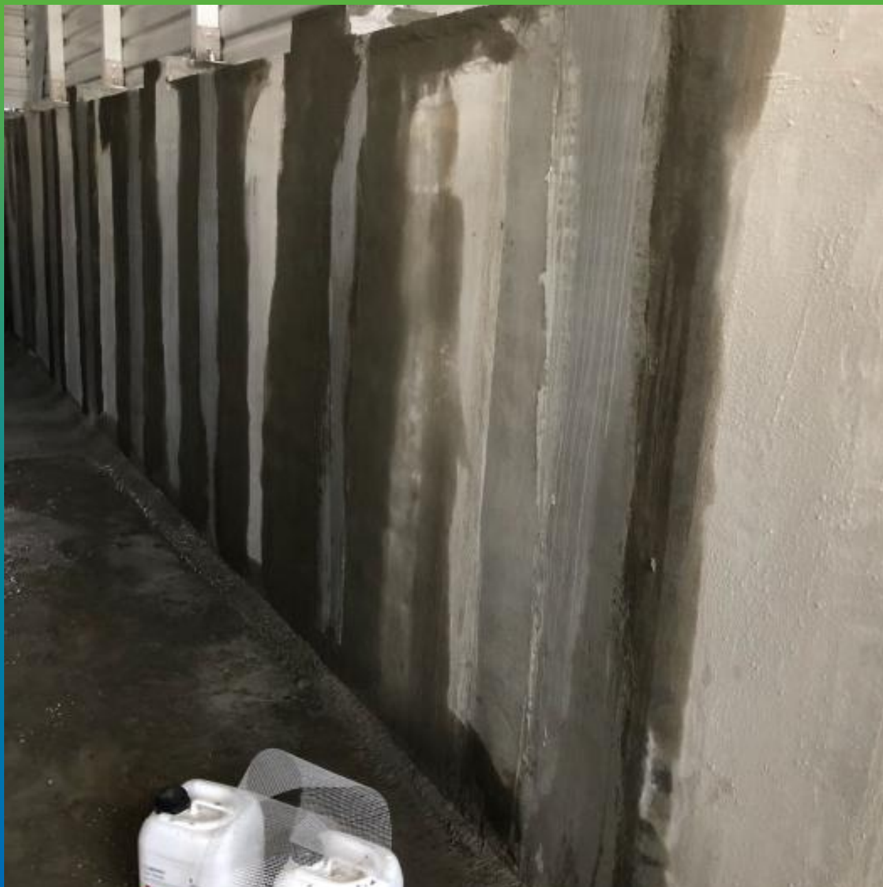
Отремонтированный участок. Общий вид.
