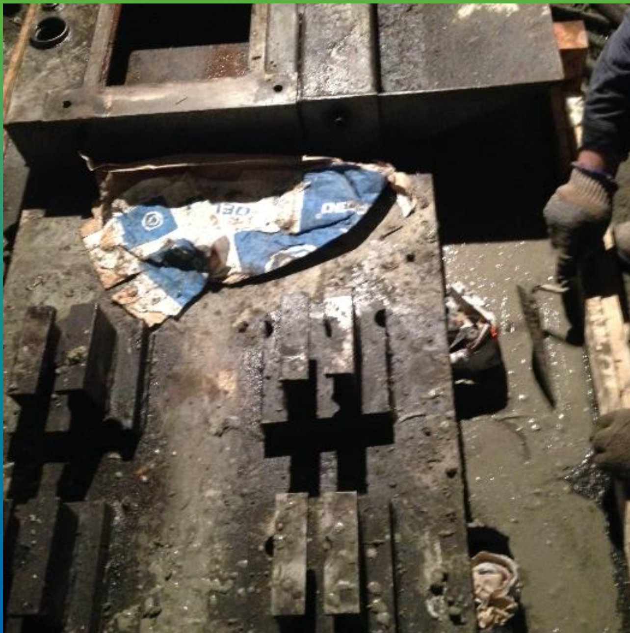
Общий вид участка при выполнении работ
