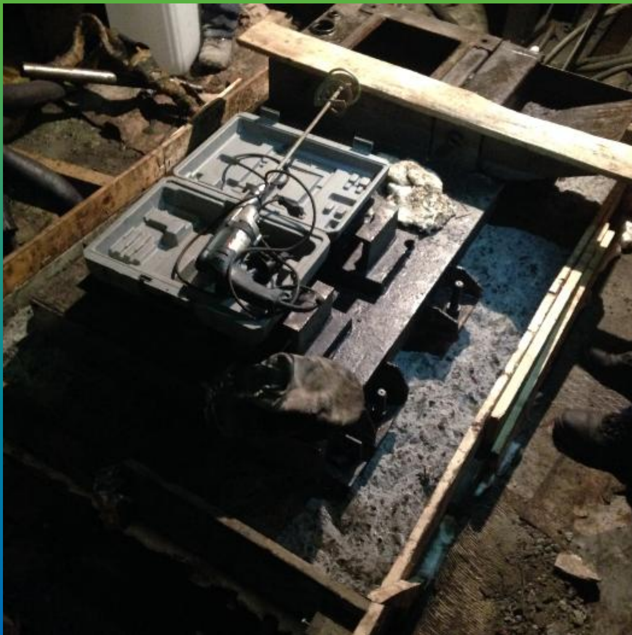
Ремонтный участок. Фундамент оборудования. Общий вид
