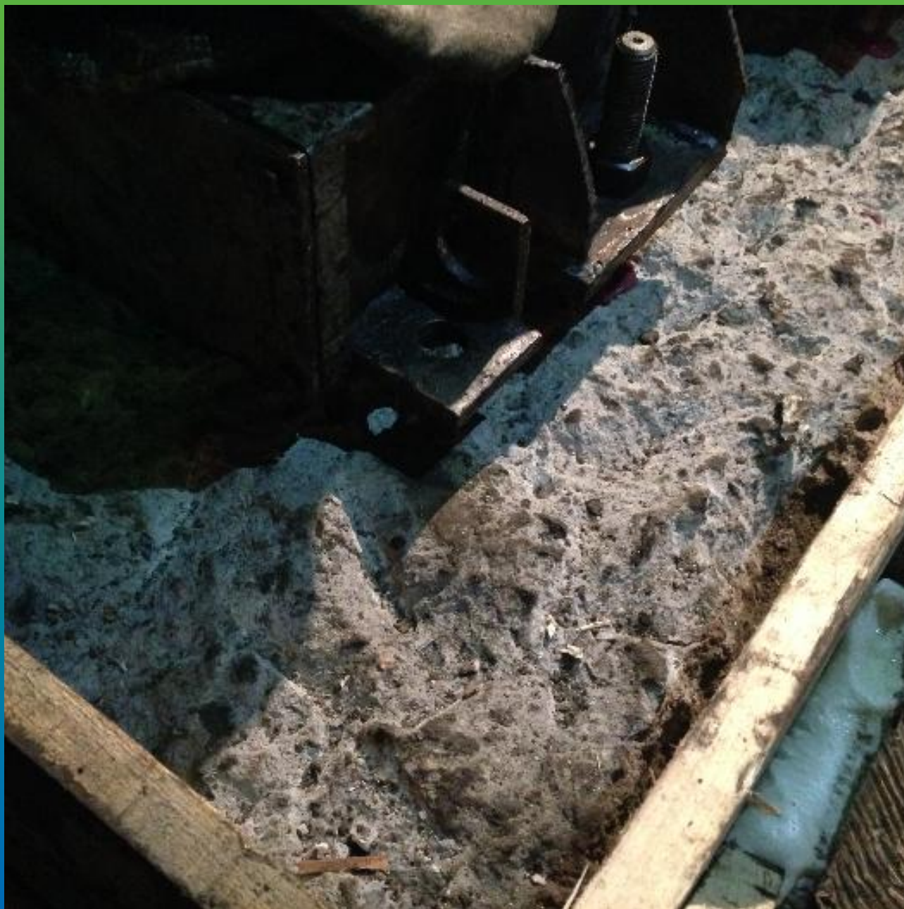
Подготовка участка. Удаление структурно не прочного основания, очистка.
