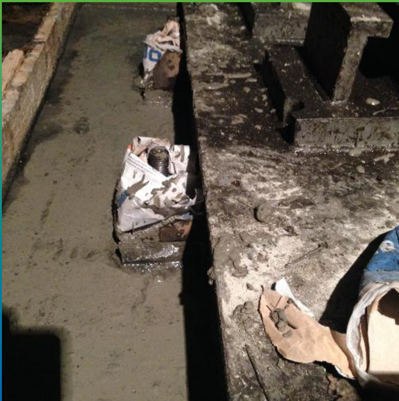
Выполненный участок ремонта фундамента. Частный вид
