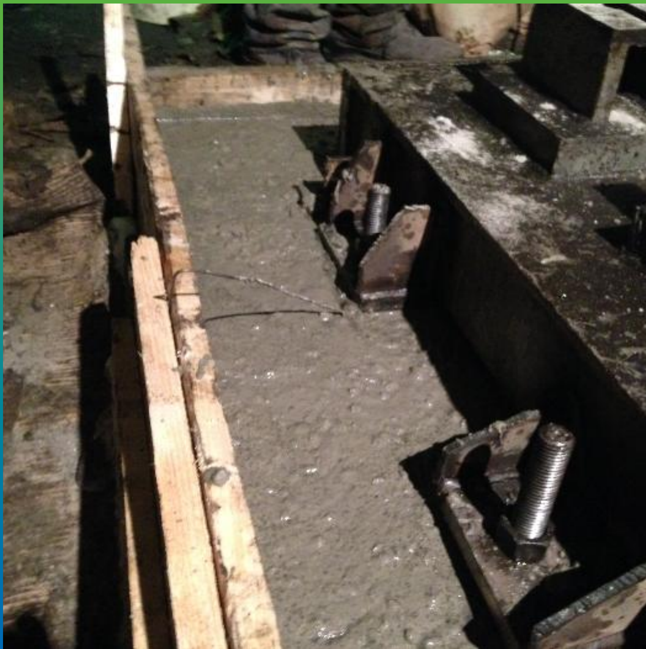
Заполнение опалубки составом Стармекс ФМ7 Зима
