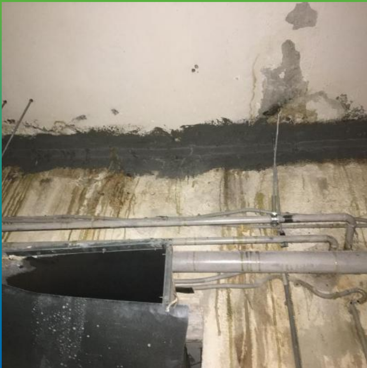
Вид шва после обработки его составом Манопур С и Стармекс РМЗ
