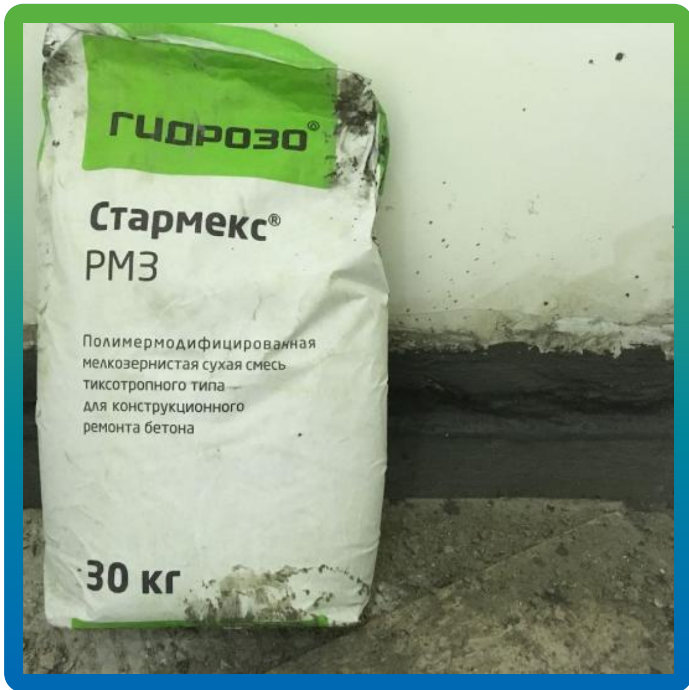
Зачеканенный шов составом Стармекс PM3
