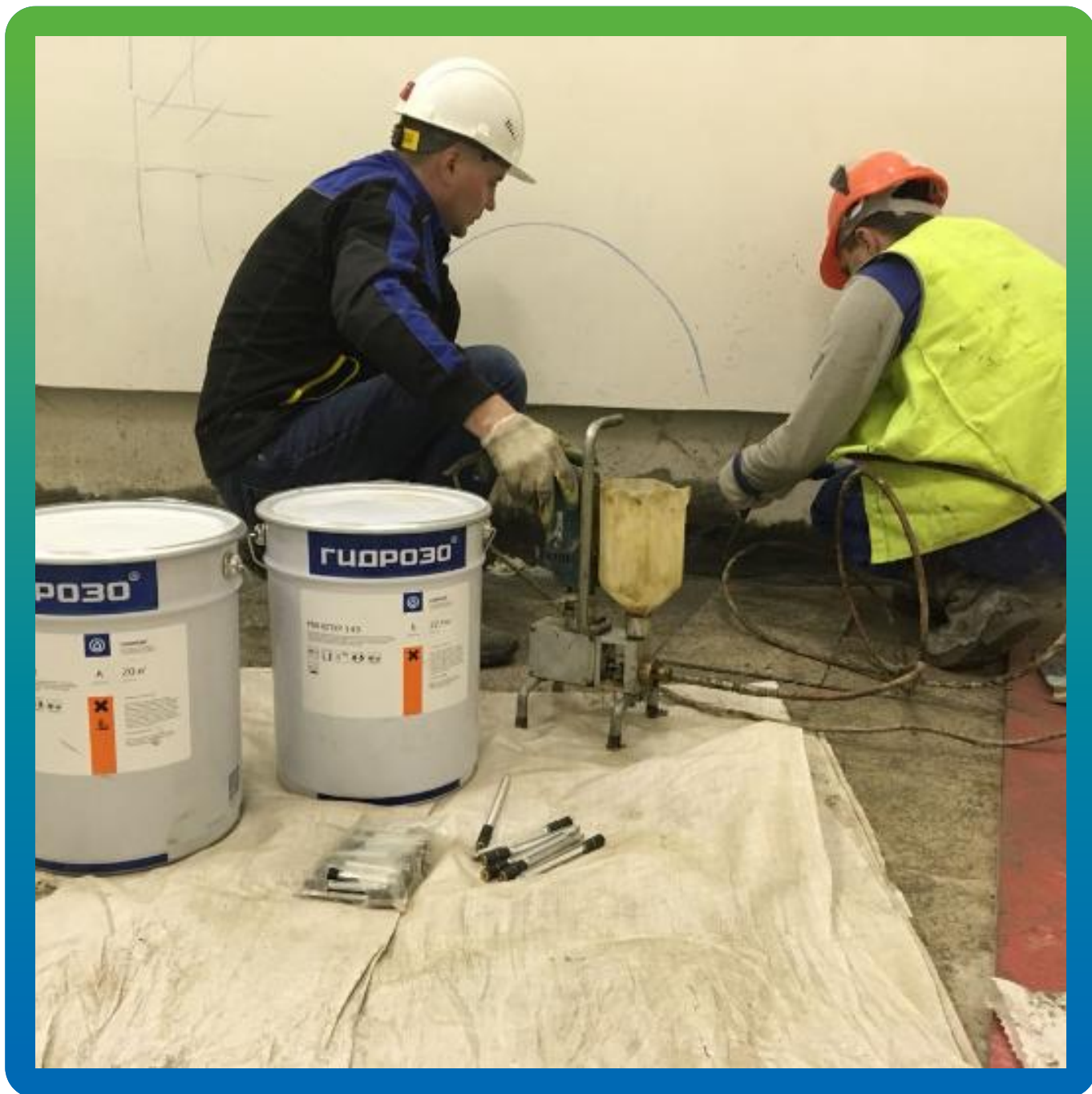
Выполнение работ по герметизации шва составом Манопур С
