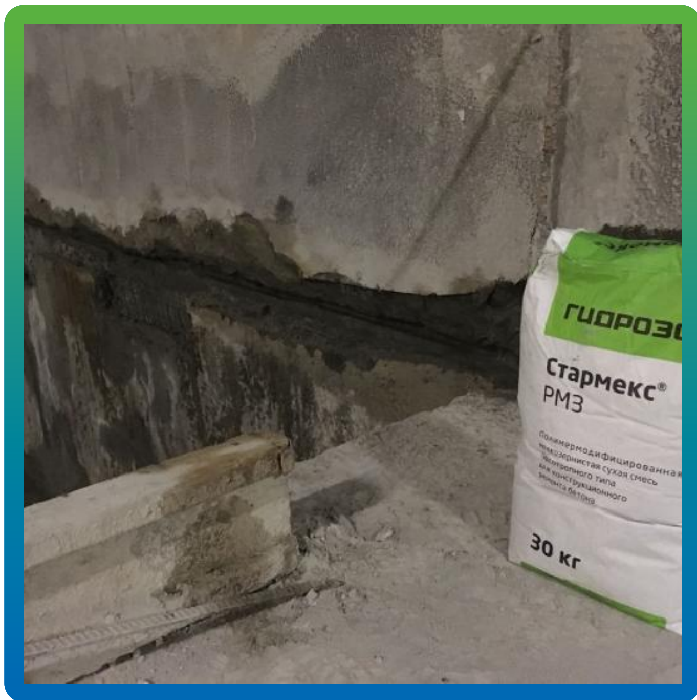
Подготовка шва к зачеканки составом Стармекс РМЗ
