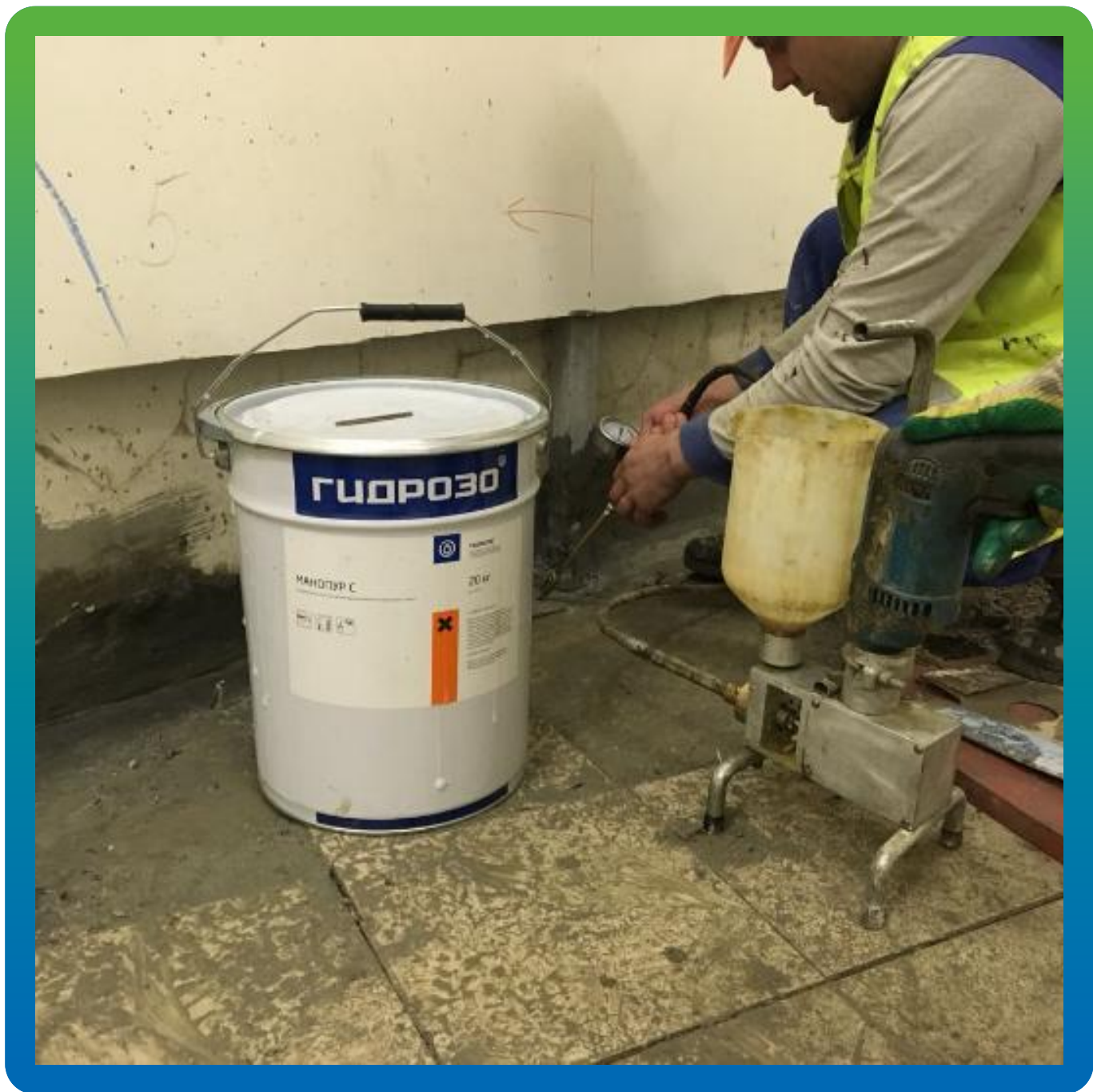
Проведение инъекционных работ по гидроизоляции шва составом Манопур С
