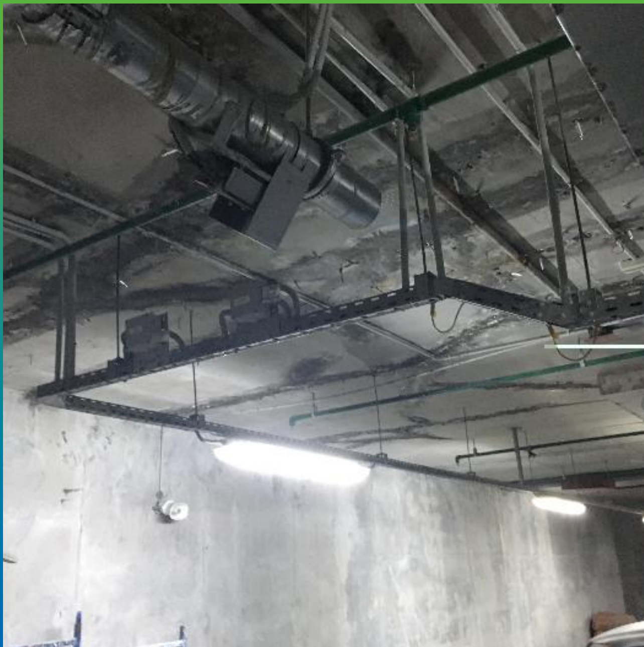
Объект после герметизации плиты перекрытия
