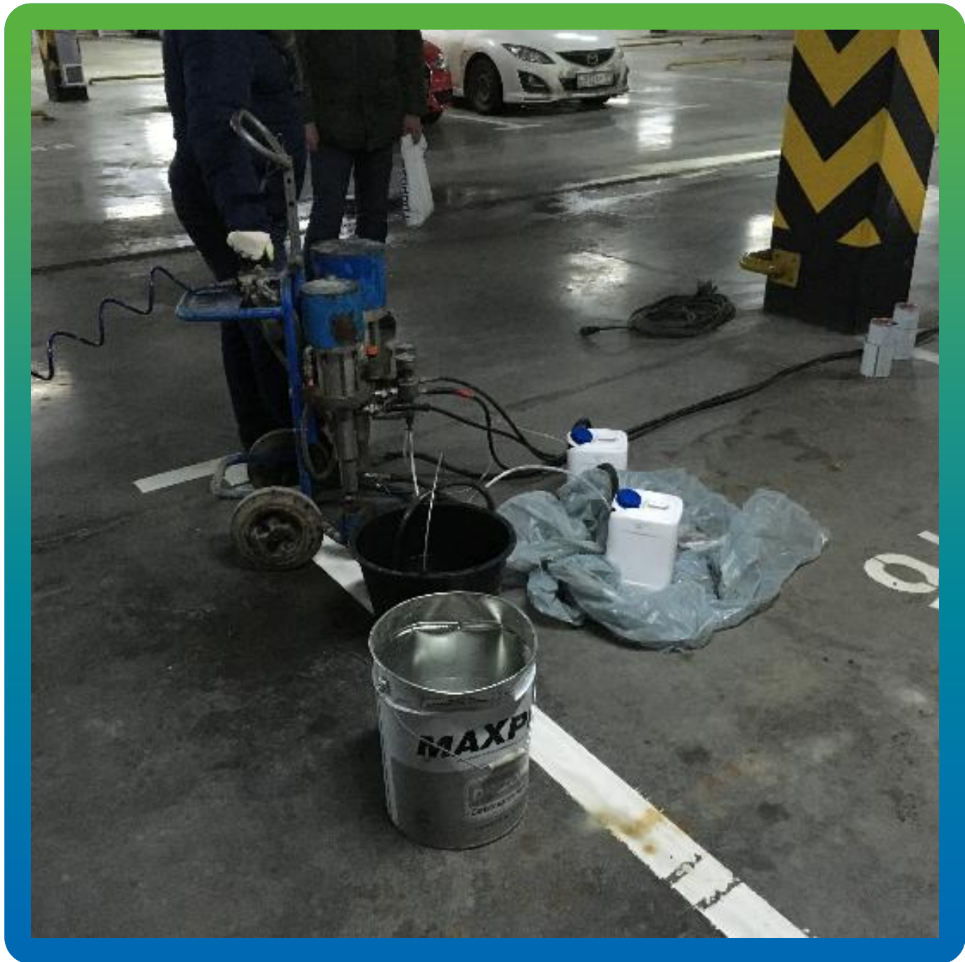
Подготовка к инъектированию Манокрил геля В
