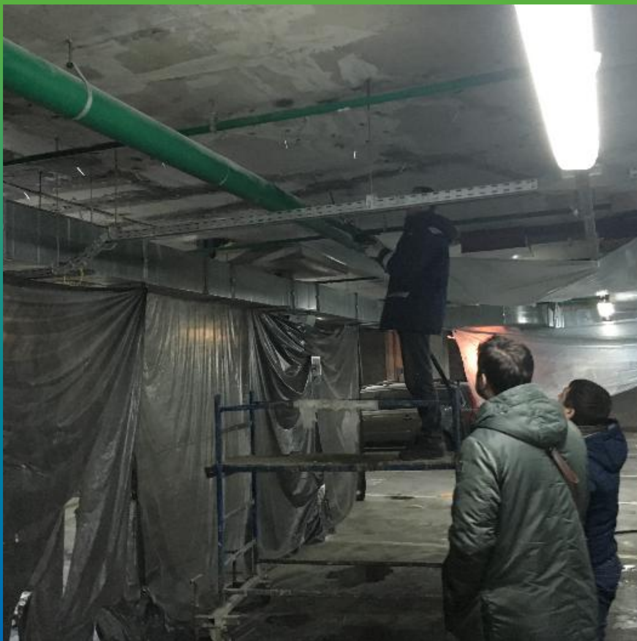
Выполнение работ по герметизации плиты перекрытия
