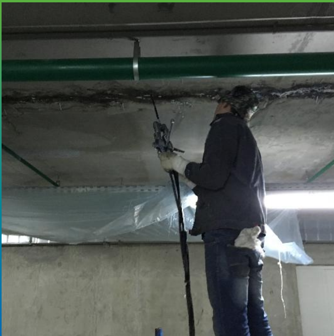
Выполнение инъекционных работ по герметизации плиты перекрытия
