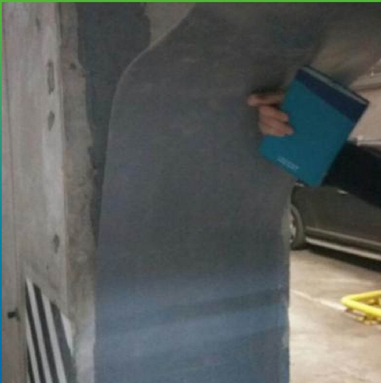
Герметизация шва с помощью ленты Манодил Про и Манопокс 331
