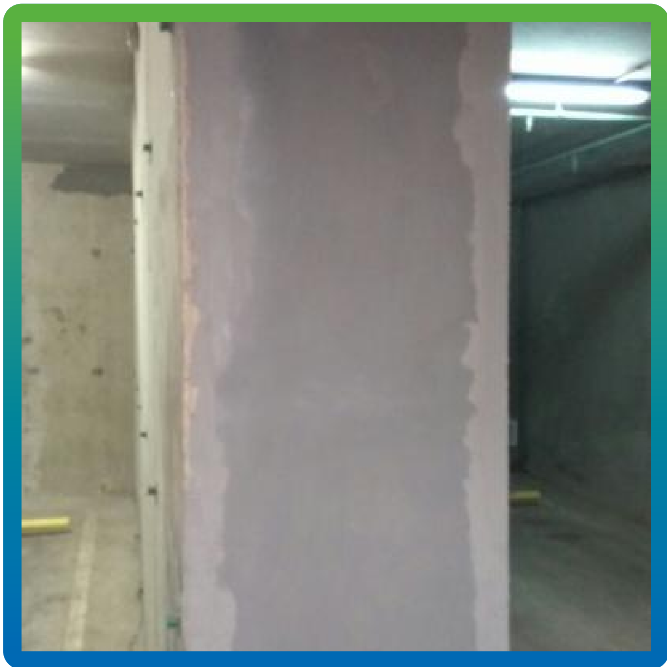
Финишный вид. Герметизация шва Манодил Про и Манопокс 331
