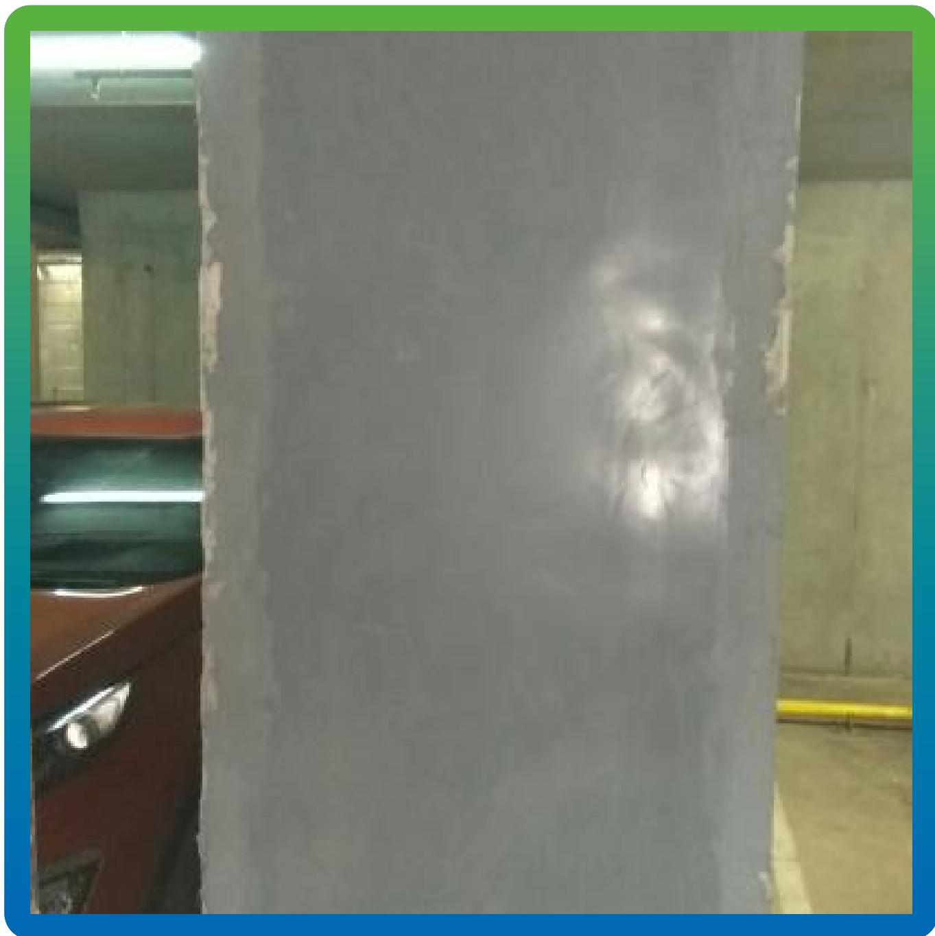
Финишный вид проблемного места после герметизации
