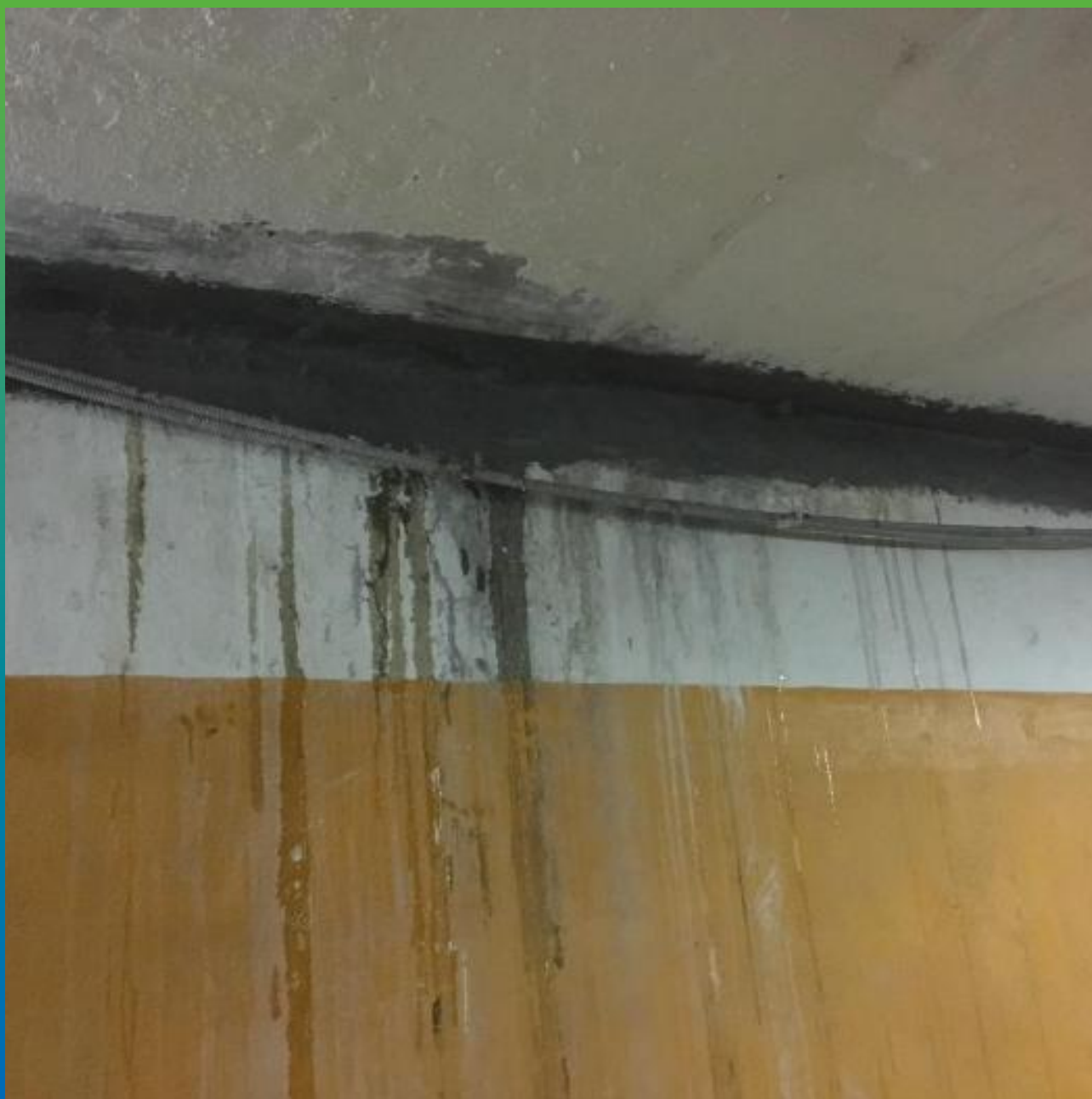
Зачеканка шва с помощью ремонтного состава Стармекс РМЗ
