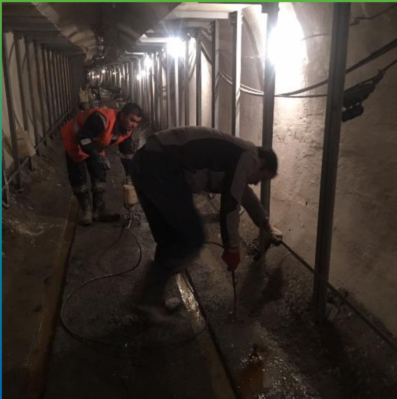
Инъектирование протечек Манопуром 15
