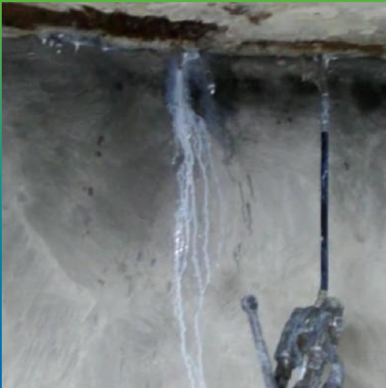
Инъектирование геля Манокрил гель В
