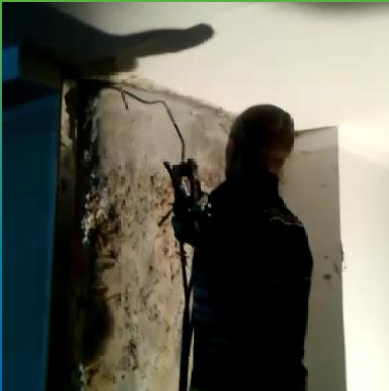
Инъектирование геля Манокрил гель В
