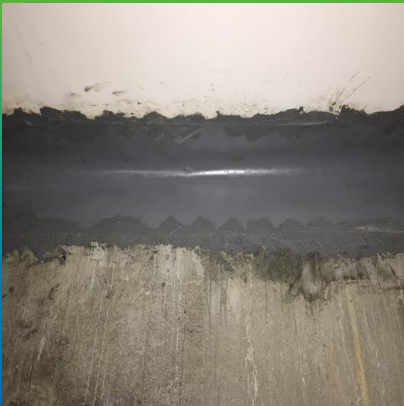
Шов заклеенный лентой Манодил Про и Манопокс 331
