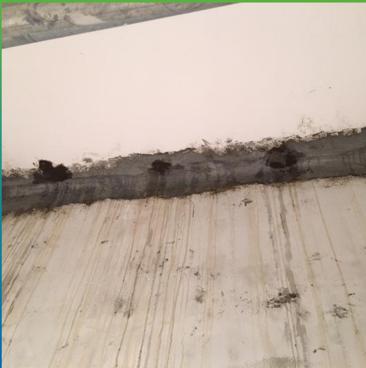
Проинъектированный участок
