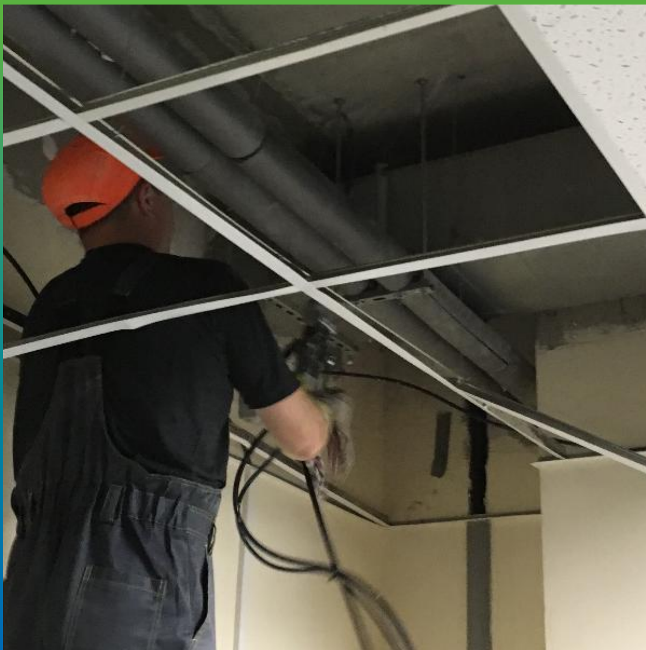
Процесс инъектирования Манокрил Геля В насосом БМ 1425
