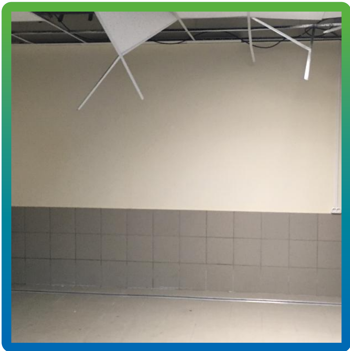
Вид после инъектирования
