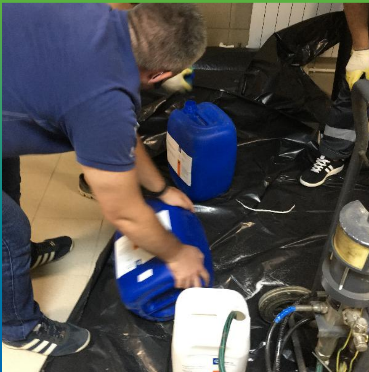
Перемешивание составов Манокрил Геля В перед инъектированием
