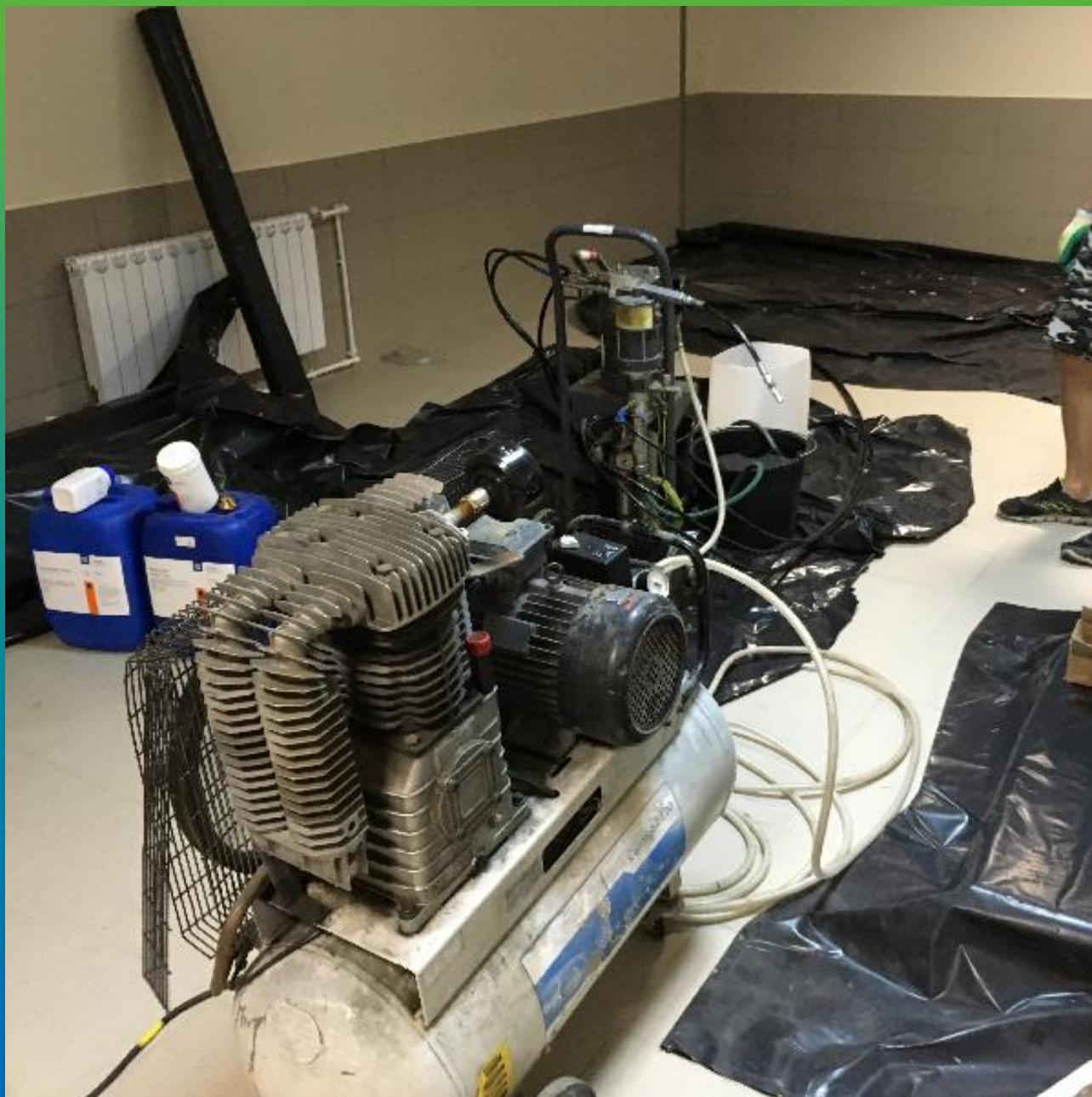
Подготовка к инъектированию Манокрил Гелем В с помощью насоса БМ 1425
