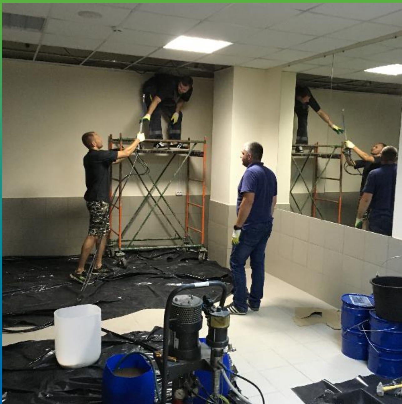
Процесс инъектирования Манокрил Геля В насосом БМ 1425
