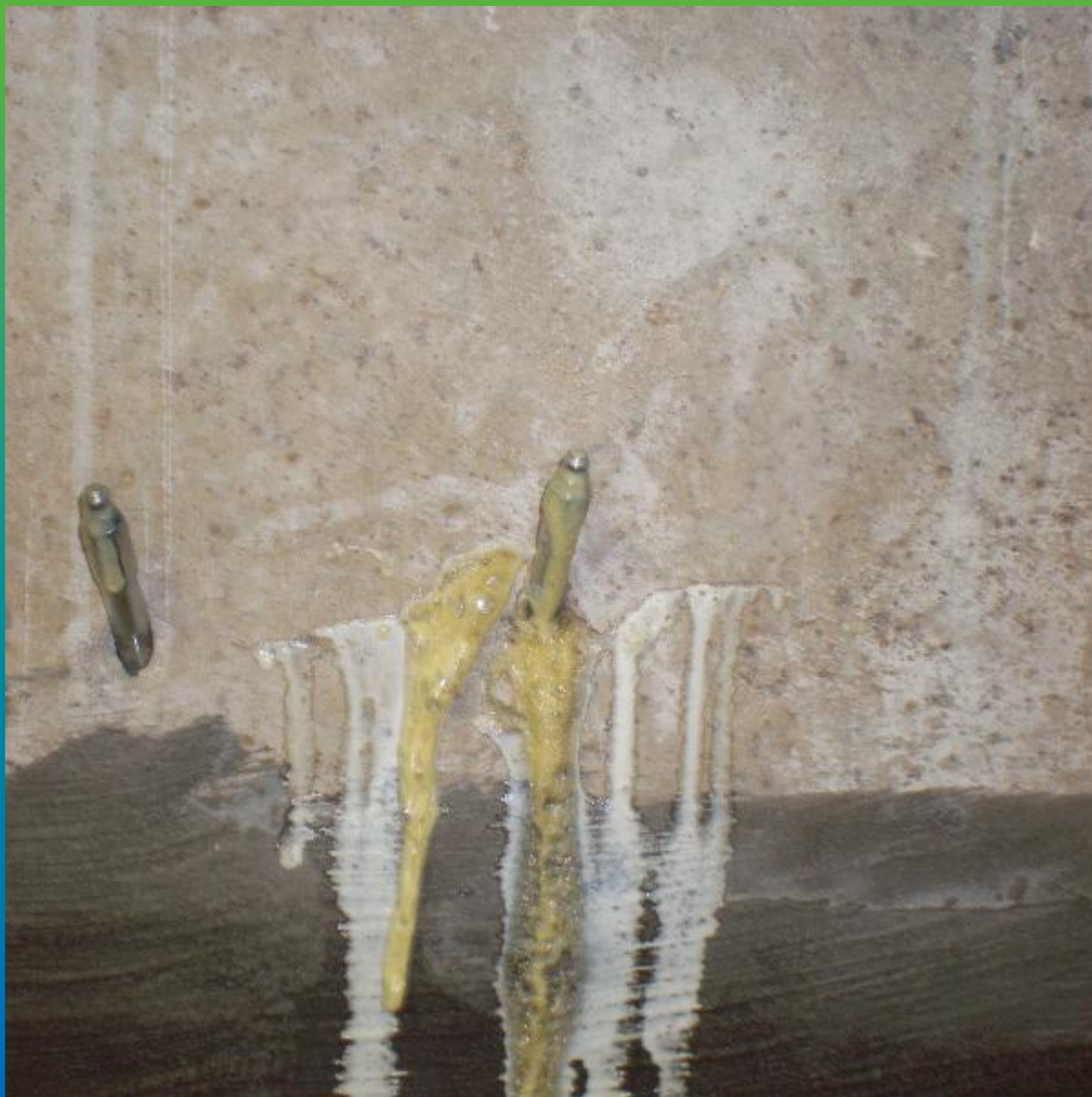
Инъектирование швов между блоками Манопуром 143
