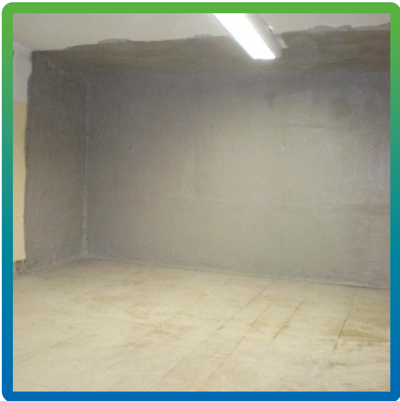
Финишная гидроизоляция Максил супер.
