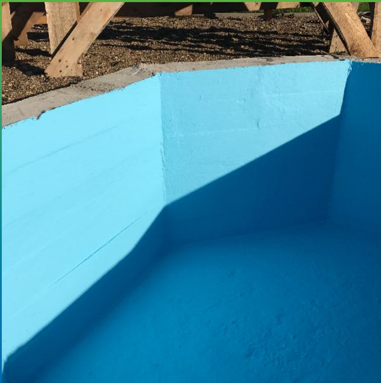
Вид бассейна после нанесения Максшин Пул
