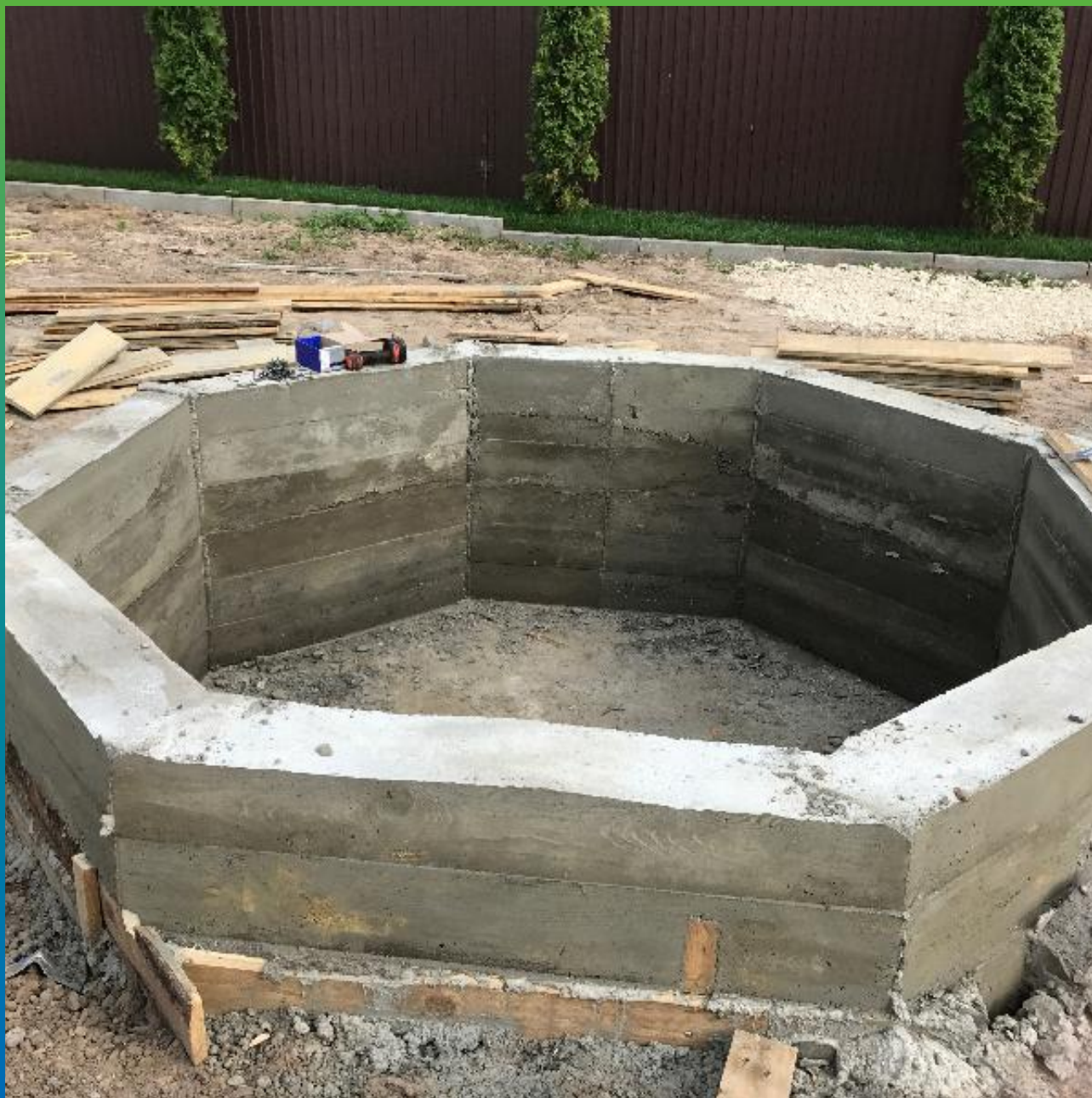
Вид бассейна после разопалубки
