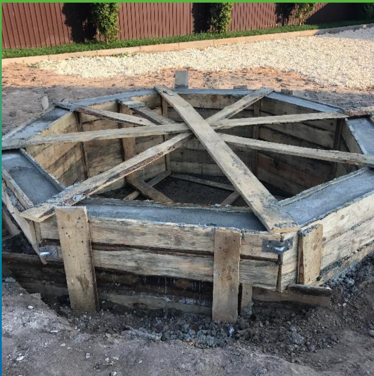
Вид бассейна до разопалубки
