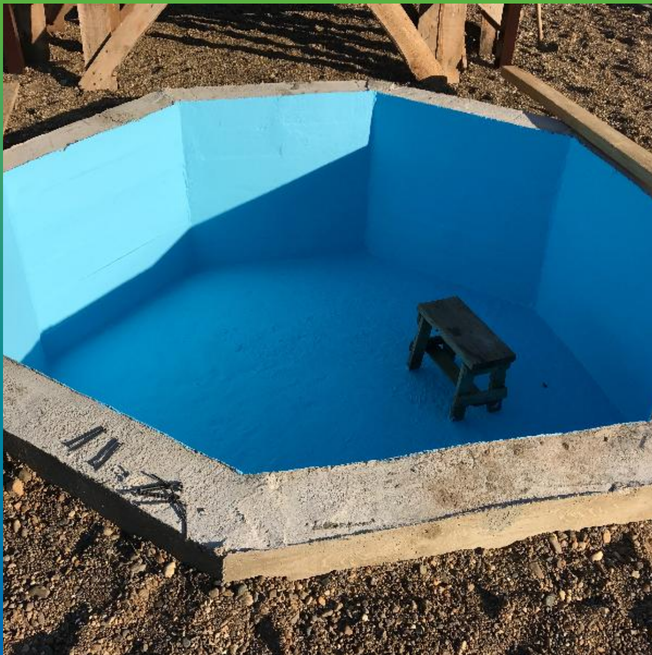
Вид бассейна после нанесения Максшин Пул
