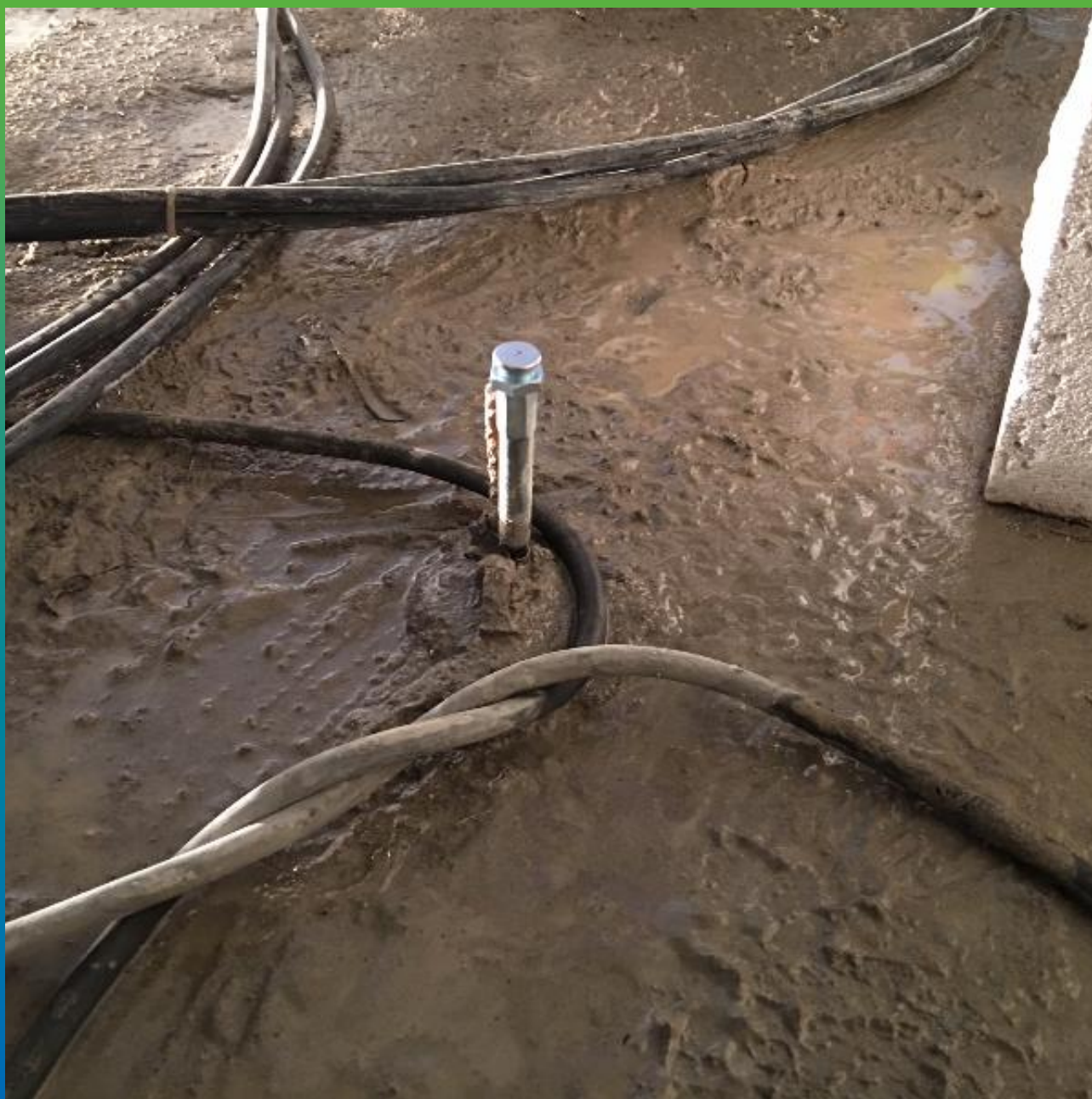
Установка пакера в инъекционные шланги ремонтной системы мембранной гидроизоляции
