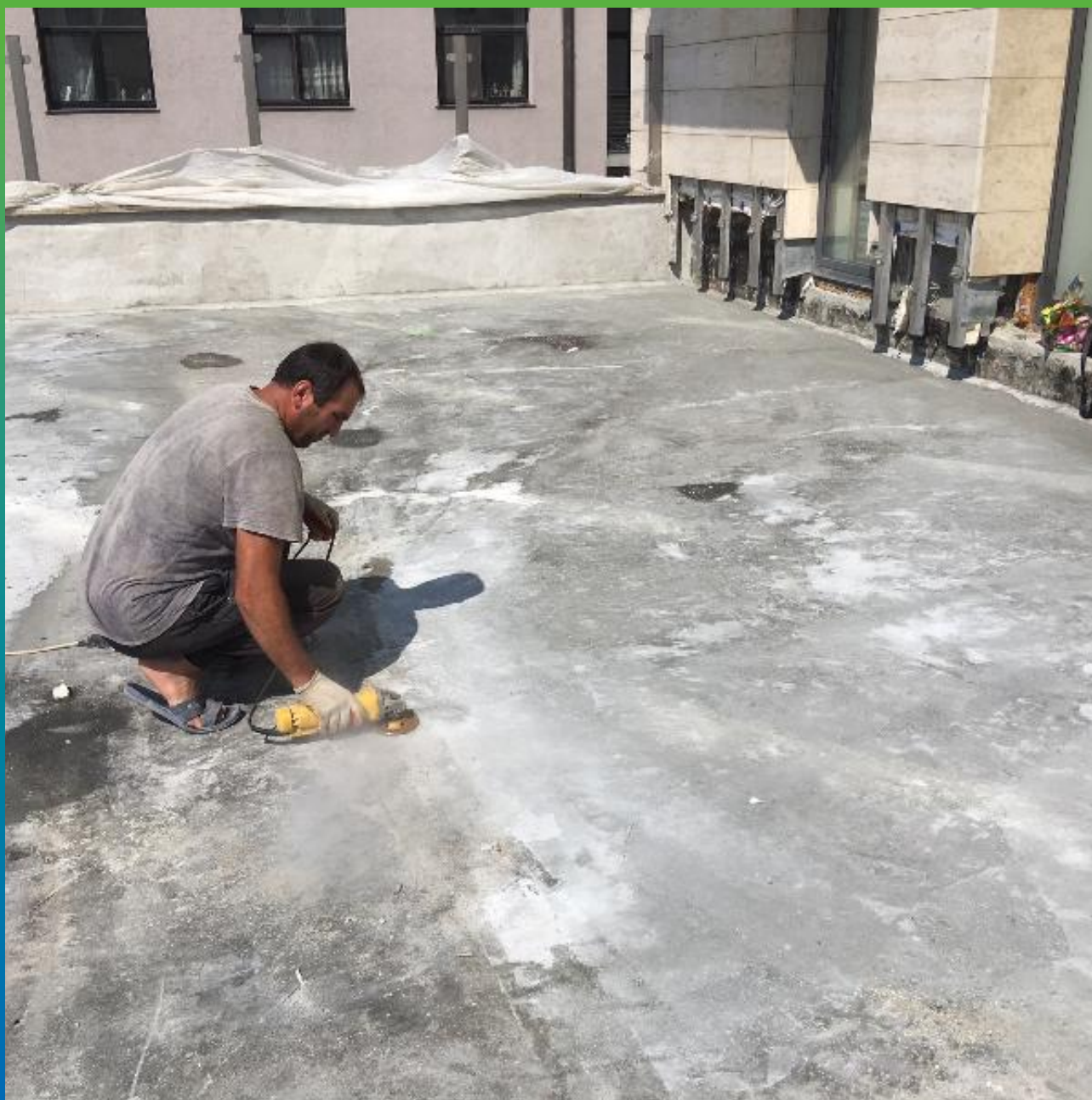
Шлифовка дефектных мест стяжки
