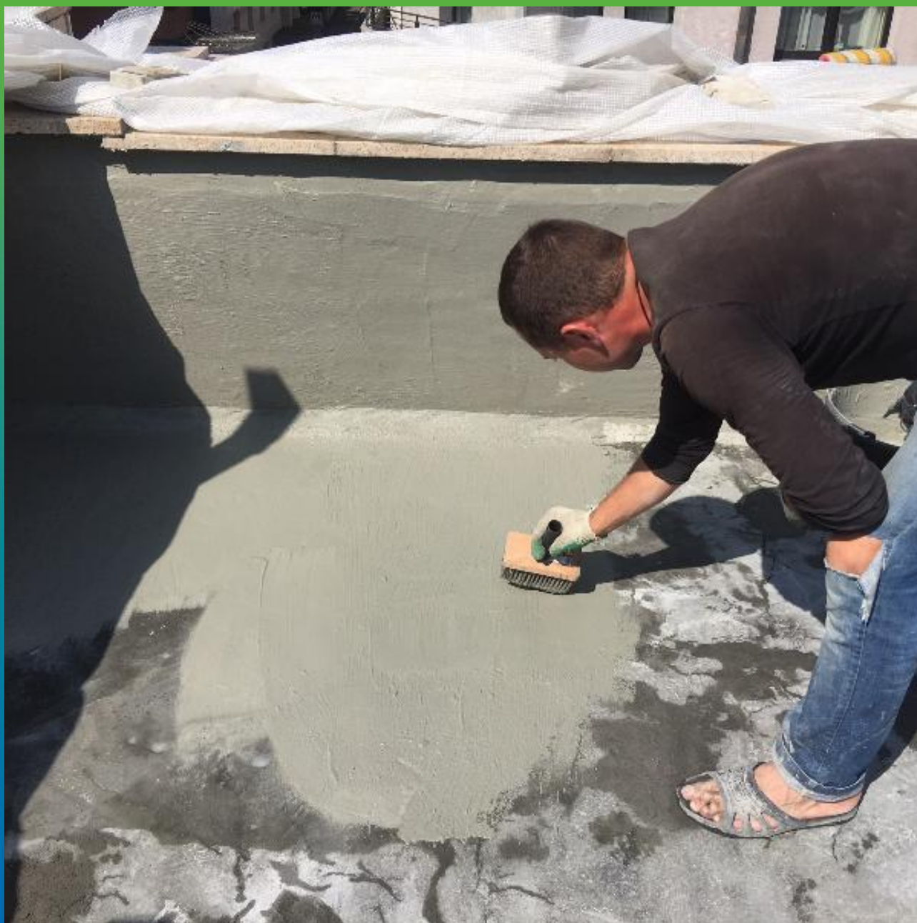
Нанесение Стармекс Сил по стяжке
