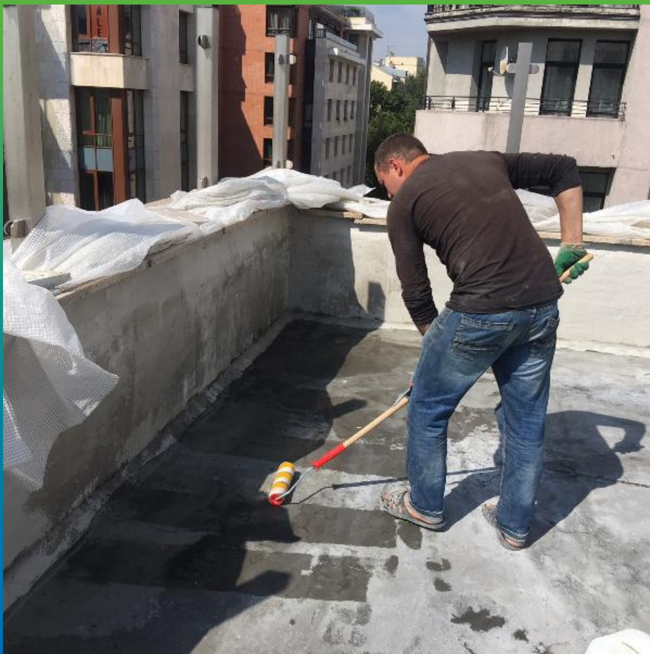
Смачивание поверхности перед нанесением полимерцементной гидроизоляции
