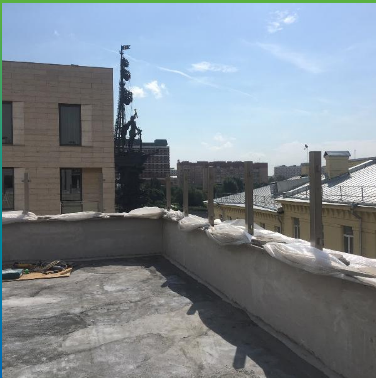
Общий вид с кровли объекта
