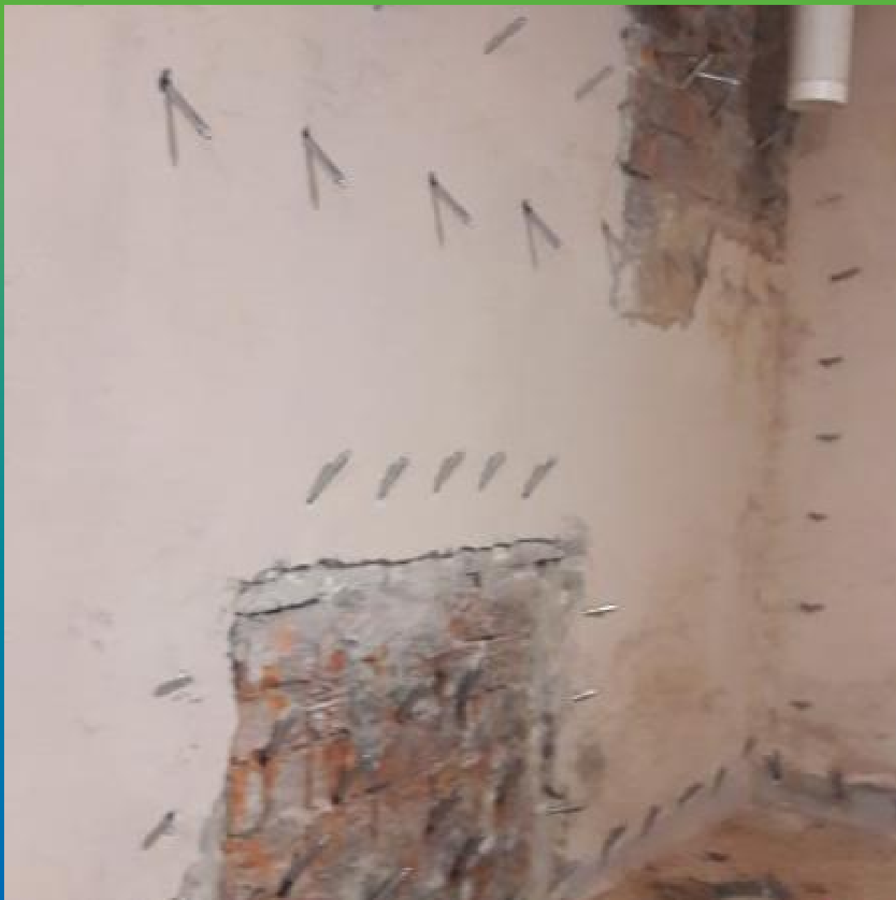
Инъектирование насосом БМ 1102 и БМ 0401 Манопур 143
