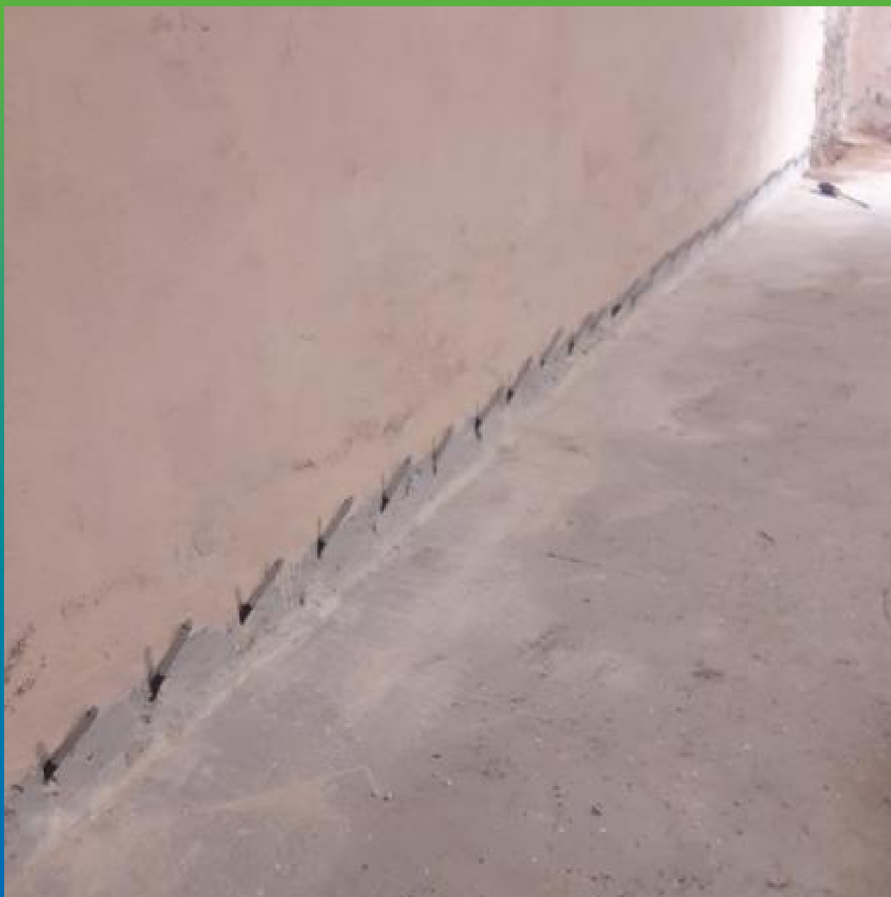
Финишный вид после инъектирования
