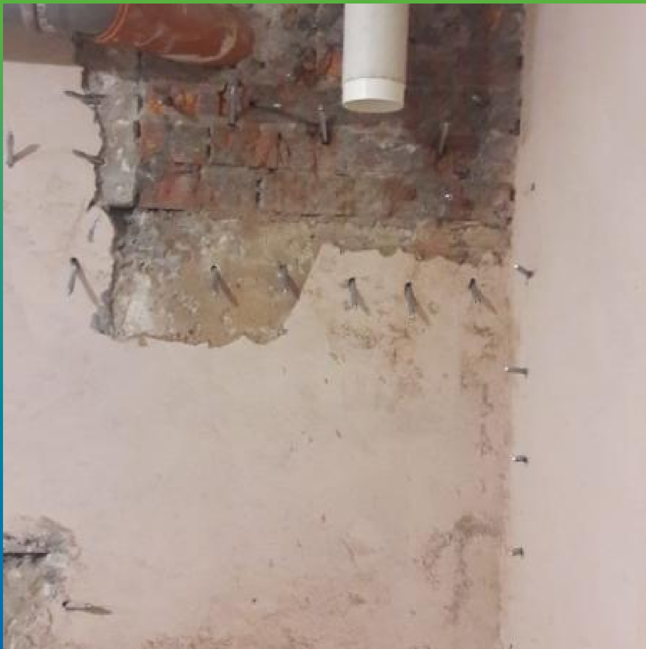
Расстановка пакеров для инъектирования в кирпичную кладку Манопур 143
