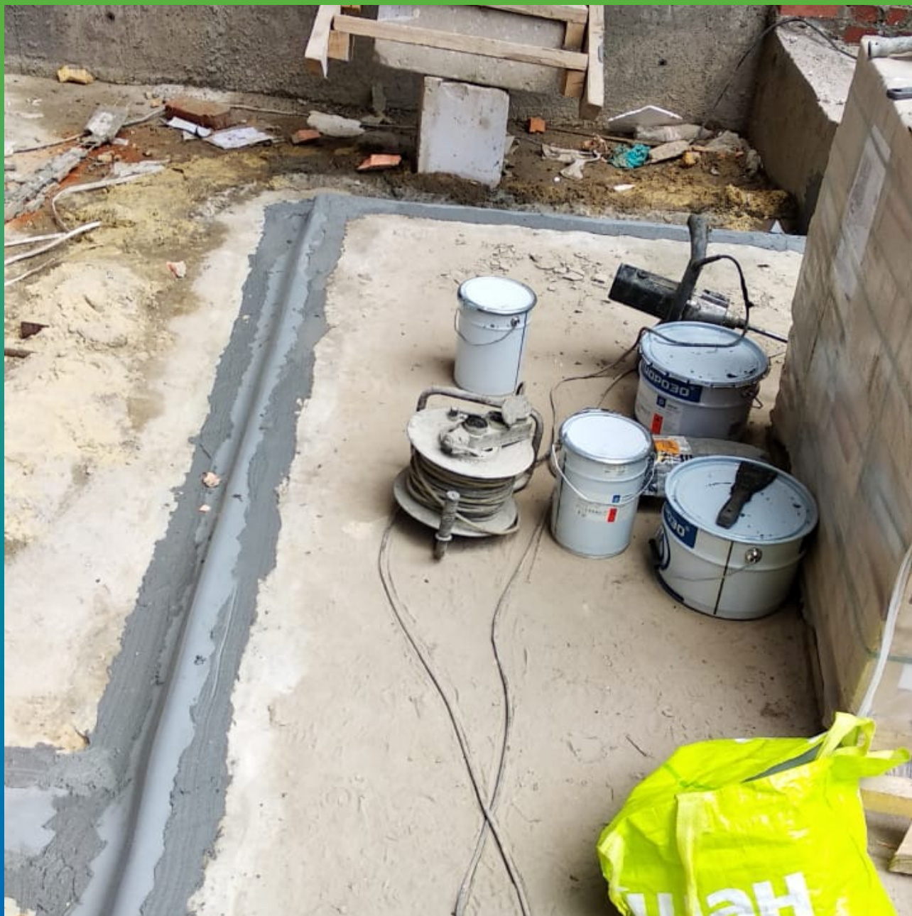
Материалы Гидрозо на объекте
