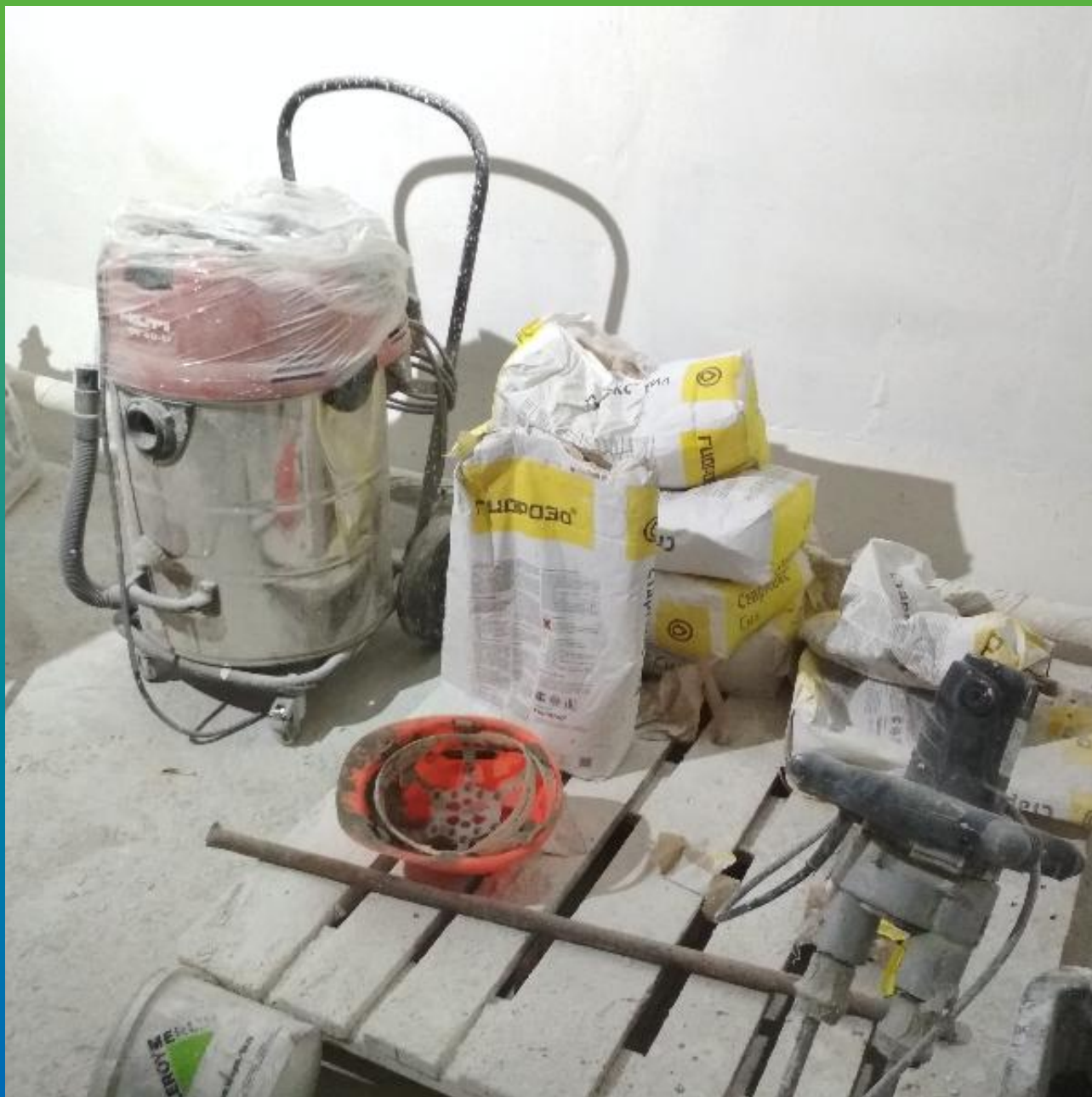
Подготовка оборудования и материала Стармекс Сил белый перед его нанесением
