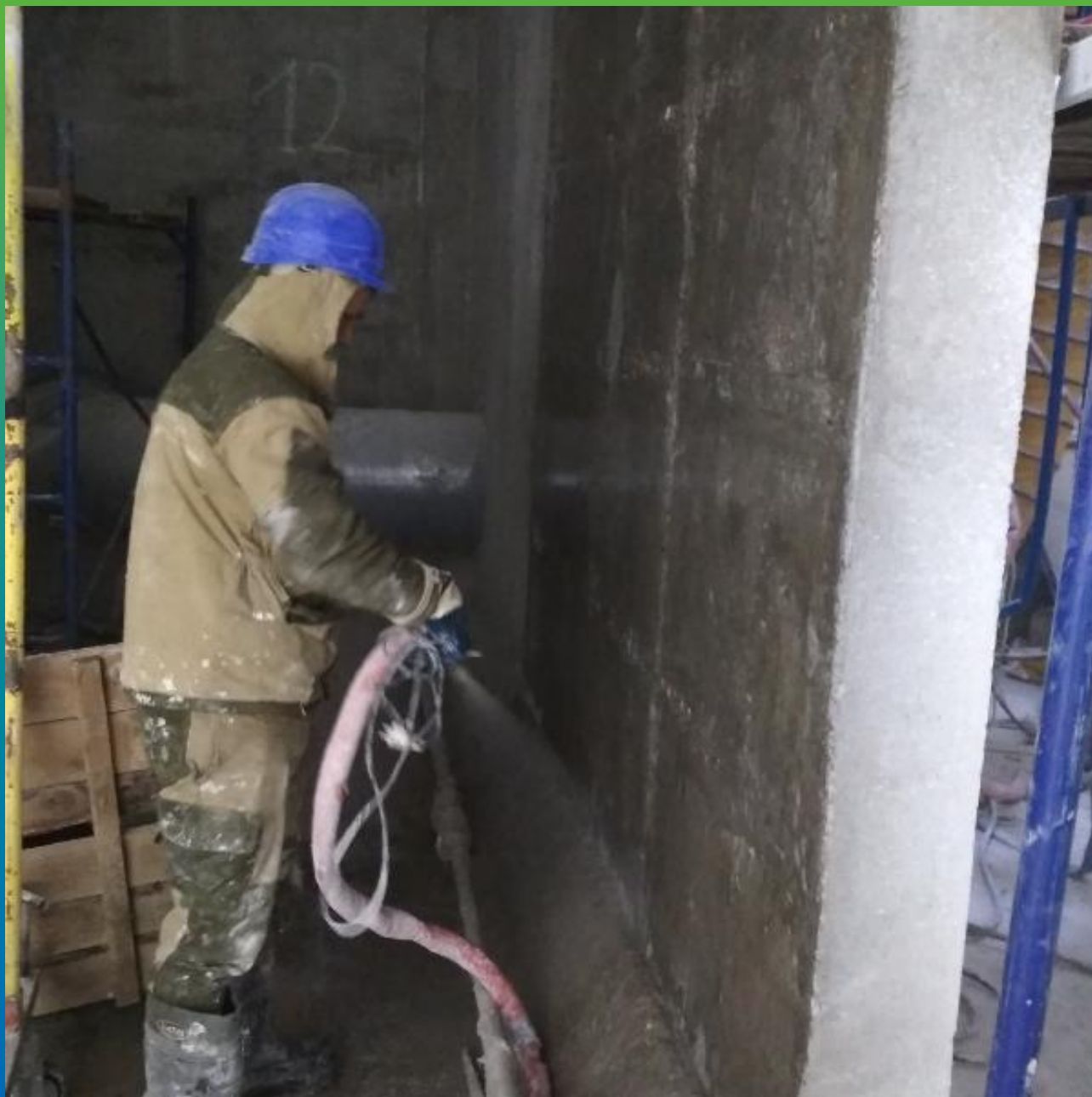
Предварительное увлажнение поверхности перед нанесением материала Стармекс Сил белый
