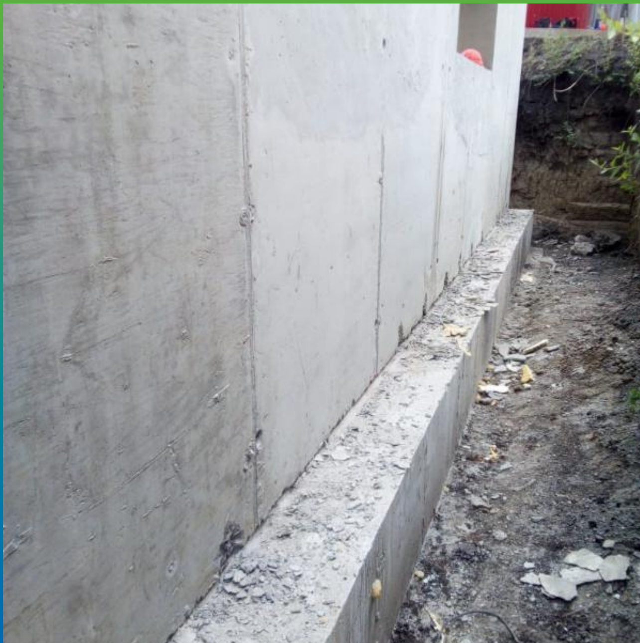
Расчеканка примыкания "плита-стена"
