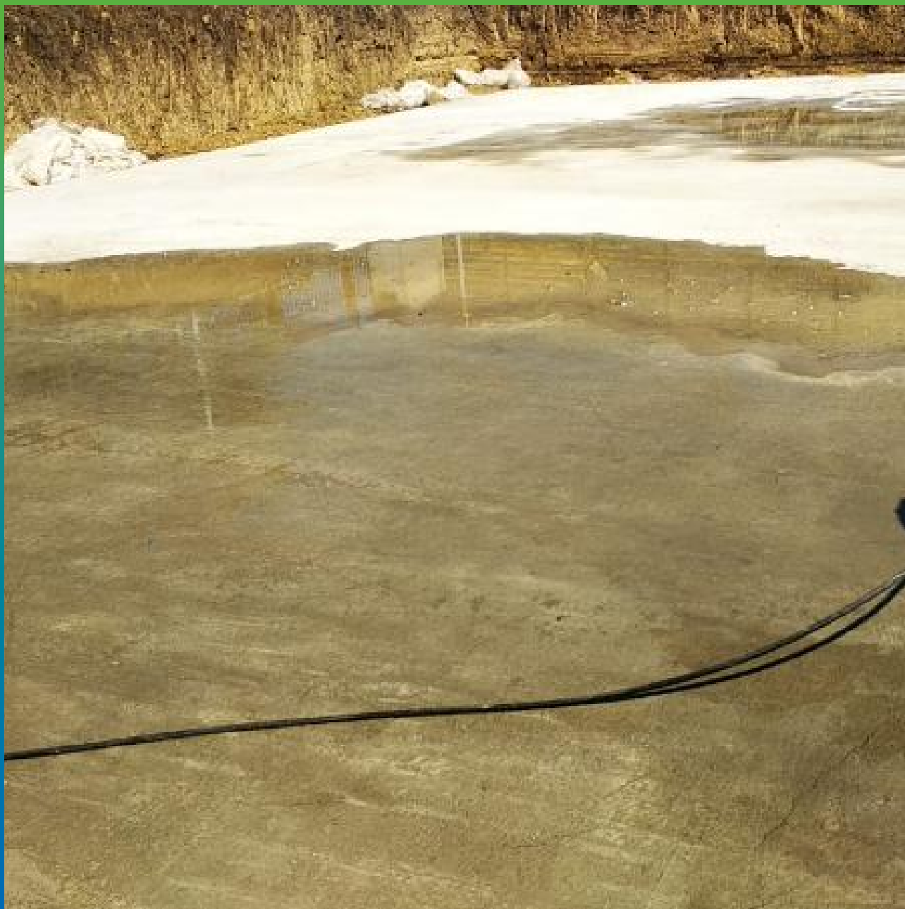
Замывка бетонной подготовки перед нанесением проникающей гидроизоляции Стармекс Кристалл
