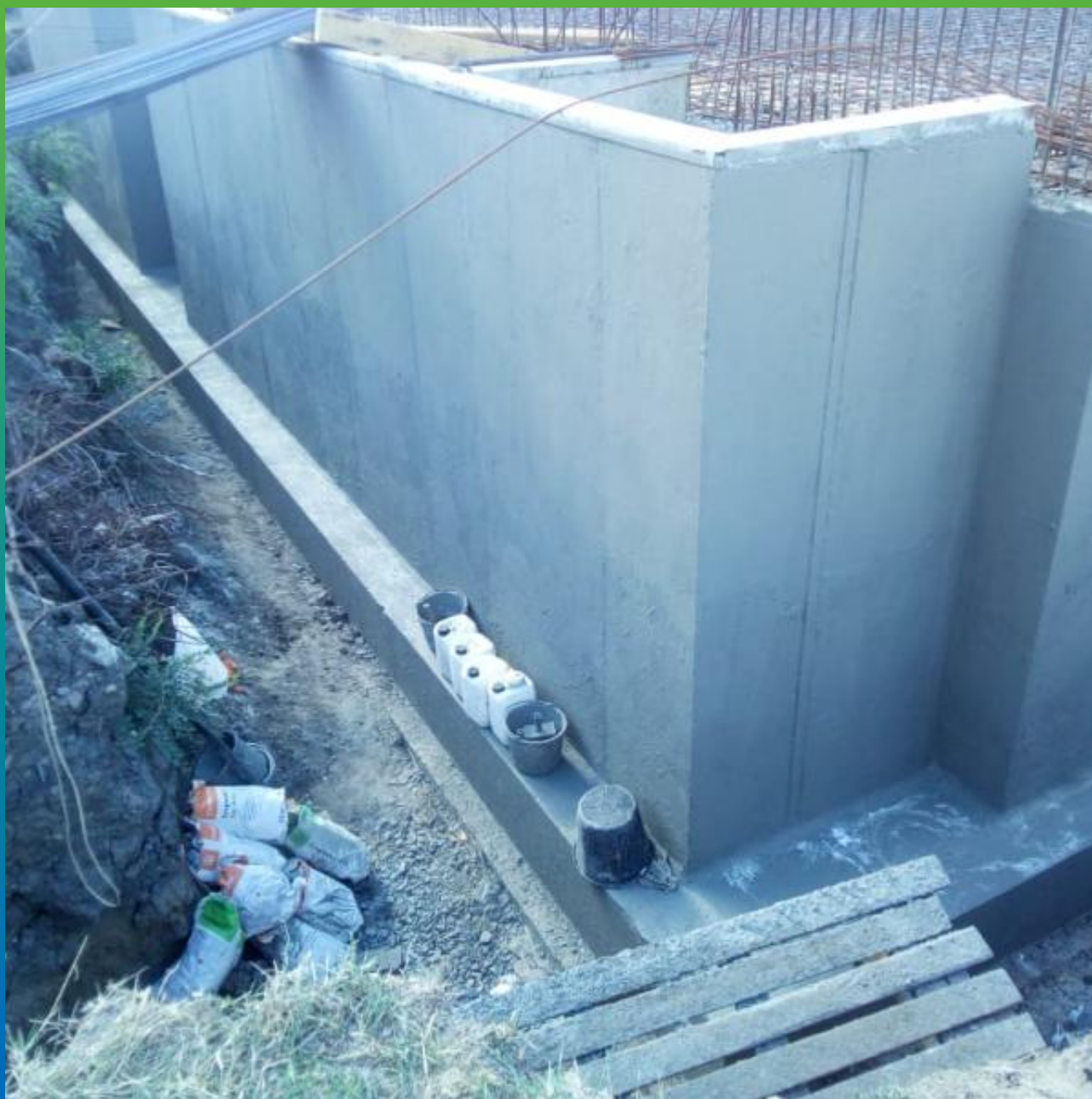
Стармекс РМЗ и Стармекс Сил Флекс на объекте
