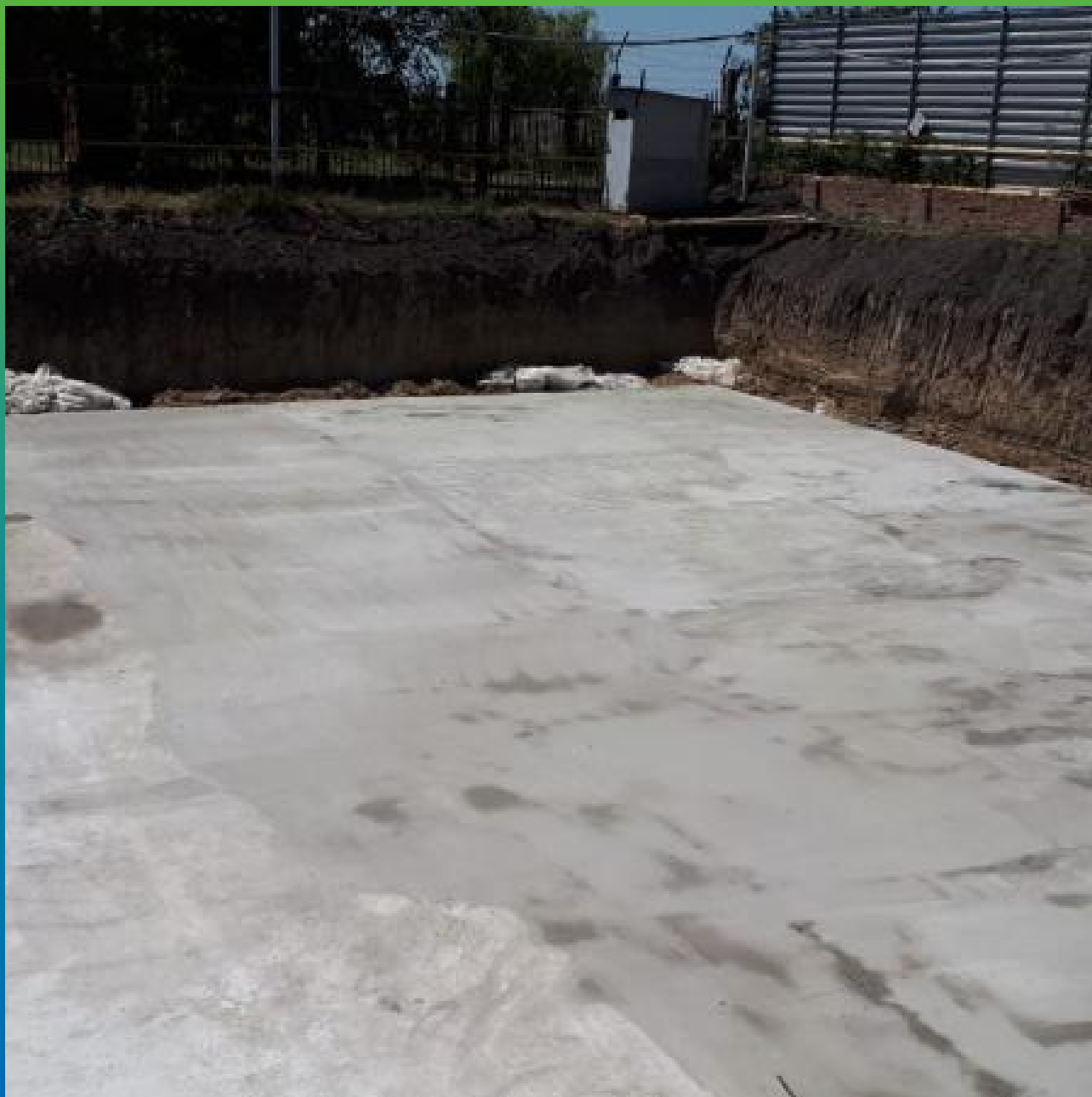
Часть бетонной подготовки обработана Стармекс Кристалл
