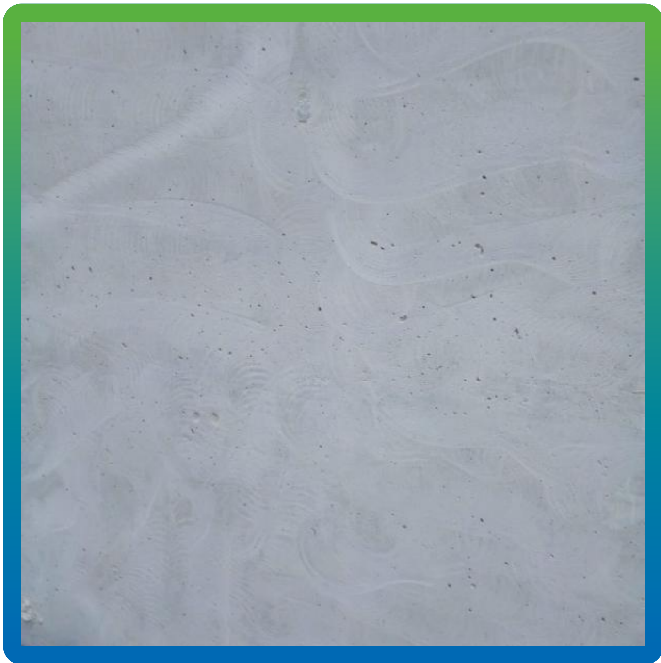
Зашлифованный бетон стены перед нанесением гидроизоляции
